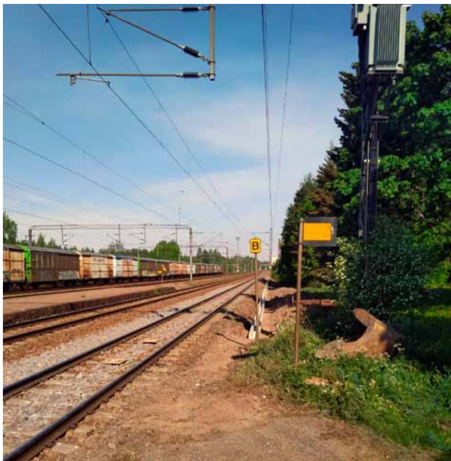
Uutta kaapelireittiä asennettuna Inkeröisten asemalta. Kuva Ville Nykänen Rejlers Finland Oy.
