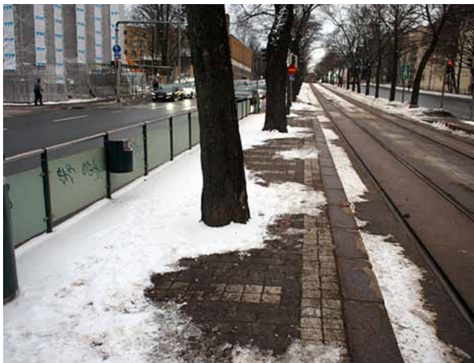
Kuva 1 Raitiotiepysäkin kalusteet tai katupuut voivat tehdä talvikunnossapidosta haasteellista, kuten tässä Kimmontien pysäkillä.
