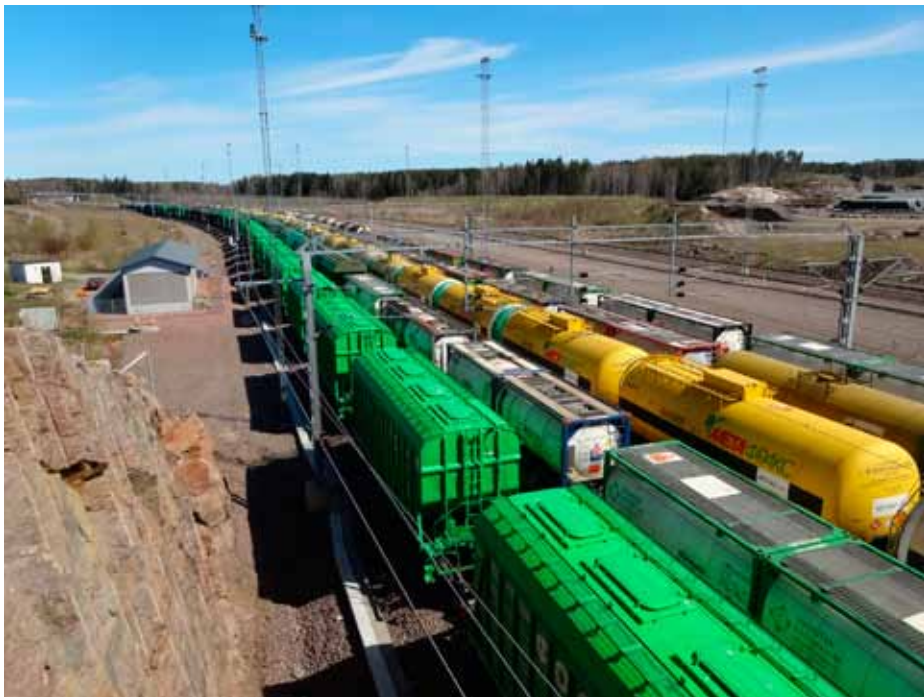
Kotolahden ratapihan raiteet valmistuivat v. 2012. Uusi turvalaitetila vasemmalla. Kuva Jukka Ylönen Welado Oy.
