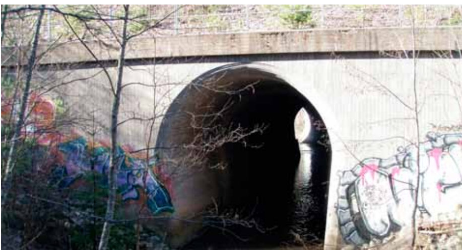
Kuva 3. Nykyinen Palojoen ratasillan itäpuolen julkisivu.
