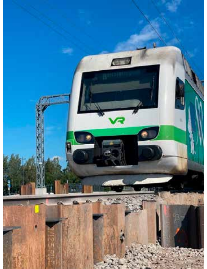
Rakentaminen liikenteellä olevilla raiteilla asettaa suunnitteluratkaisuille erityisiä vaatimuksia. Kuvassa tuentaratkaisuja Ainolan tulevan seisakkeen uuden sillan rakentamisen osalta. Kuvat: Anssi Honkala, Viakon Infra Oy.
