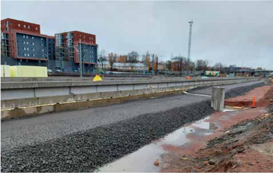
Kuva 4 Raiteen 001 rakentaminen on edennyt routalevyjen ja välikerroksen asentamiseen. Raiteen 001 viereen tulee lisäksi käyttövalmiushuollon varusteet. Laituri on perustettu paalulaatalla painumien estämiseksi.
