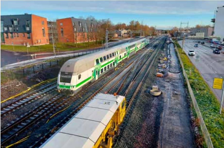
Kuva 2 Vaihdekujan tukemistyö on käynnissä Aninkaisten ylikulkusillan koillispuolella lokakuussa 2023. Toijalan suunnasta saapuu samalla IC-juna Turun asemalle.
