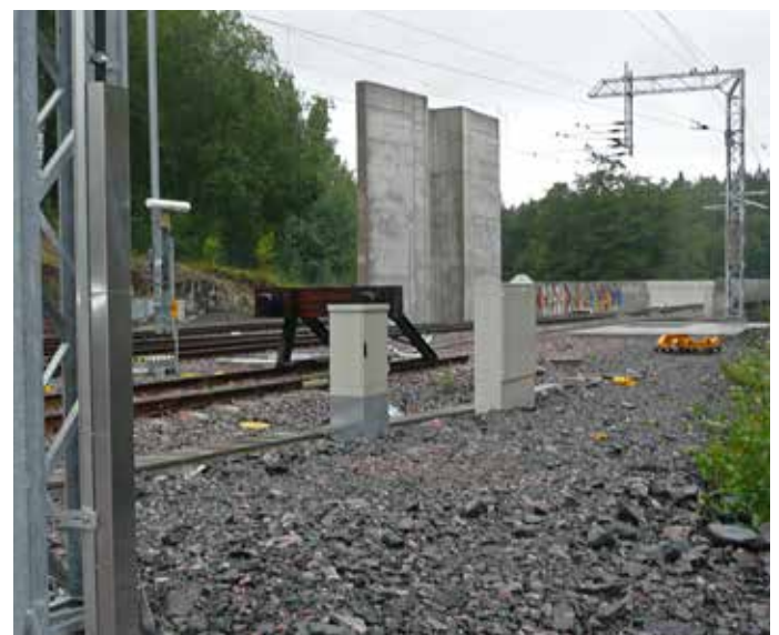
Kuva 4. Röntgenlaitteen suojaseinä purettiin ja siirrettiin Vainikkalaan.
