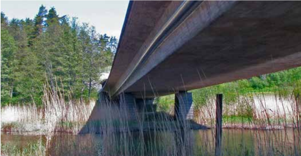
Kuva 3. Sillan välituet tehtiin vesialueen ulkopuolelle.
