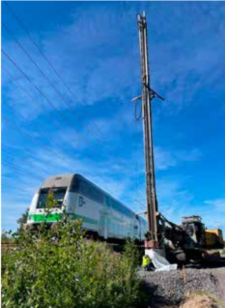
Stabilointia liikennöidyn radan vieressä. Kuva: Anssi Honkala, Viakon Infra Oy.
