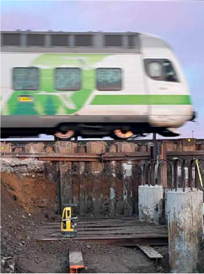
Rakentaminen liikenteellä olevilla raiteilla asettaa suunnitteluratkaisuille erityisiä vaatimuksia. Kuvassa tuentaratkaisuja Ainolan tulevan seisakkeen uuden sillan rakentamisen osalta. Kuvat: Anssi Honkala, Viakon Infra Oy.
