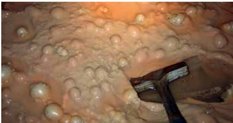
Lentoaseman aseman itäpuolella tunnelin kanaaleihin muodostui syksyllä 2010 vedenpinnalle mikrobikasvustoa, johon syntyi kaasukuplia. (Kuva: Kehärata-projekti).
