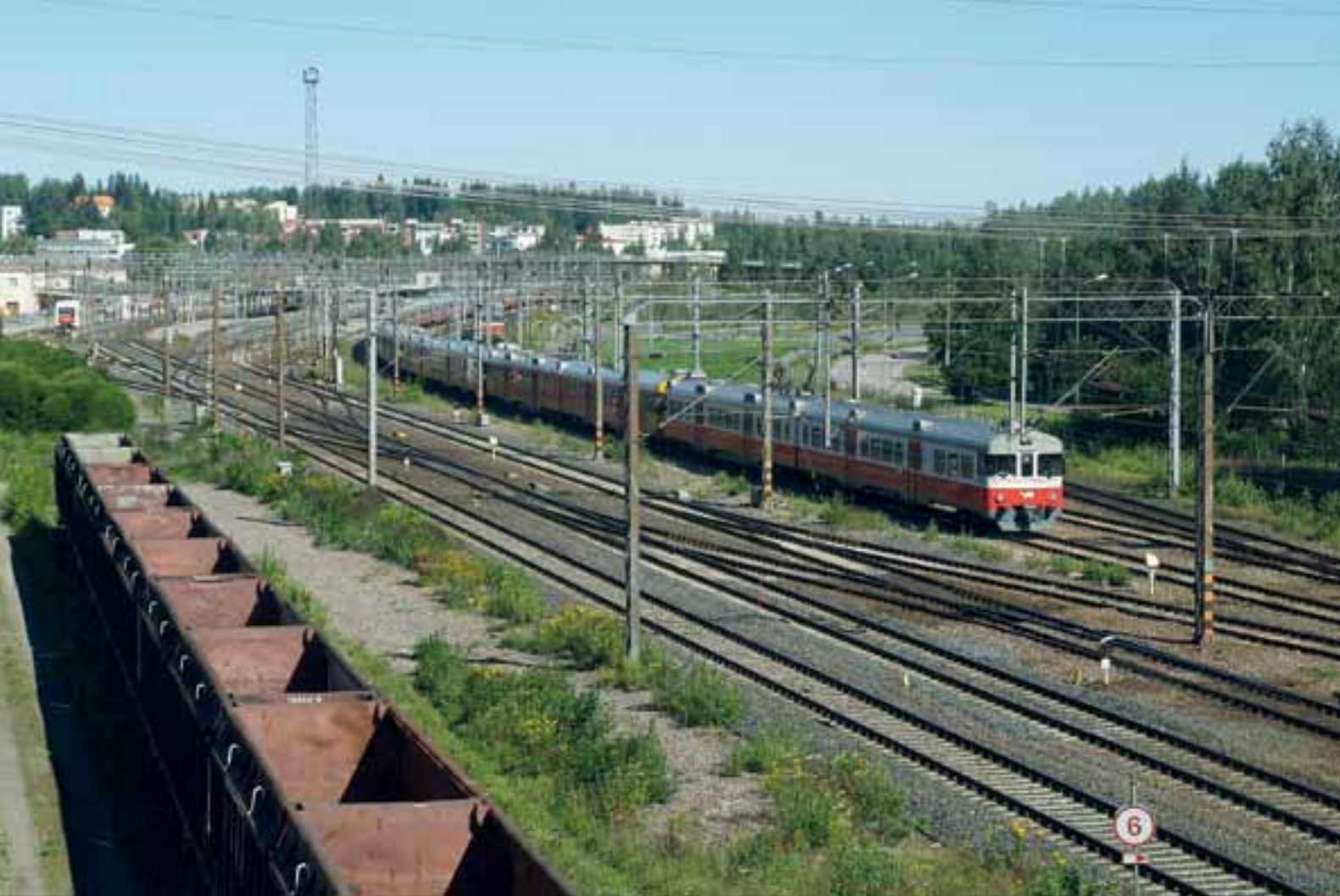
Riihimäen aseman raiteistoa uudistetaan. (Kuva: Sakari K Salo).
