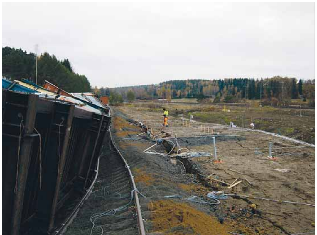
Kuva 1. Ratapenkereen stabiliteetin laskennan kehittämiseen tähtäävässä tutkimushankkeessa toteutettu instrumentoidun kohteen kuormitus sortumaan Perniössä 2009
