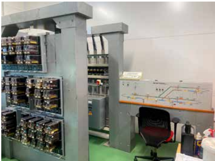
Kuva 3. Releasetinlaite Network Railin Larbertin koulutuskeskuksessa. Reletelineet ovat varsin järeää tekoa, mutta releet samoja, joita käytetään mm. Siemensin Westrace MkII-tietokoneasetinlaitteissa.
