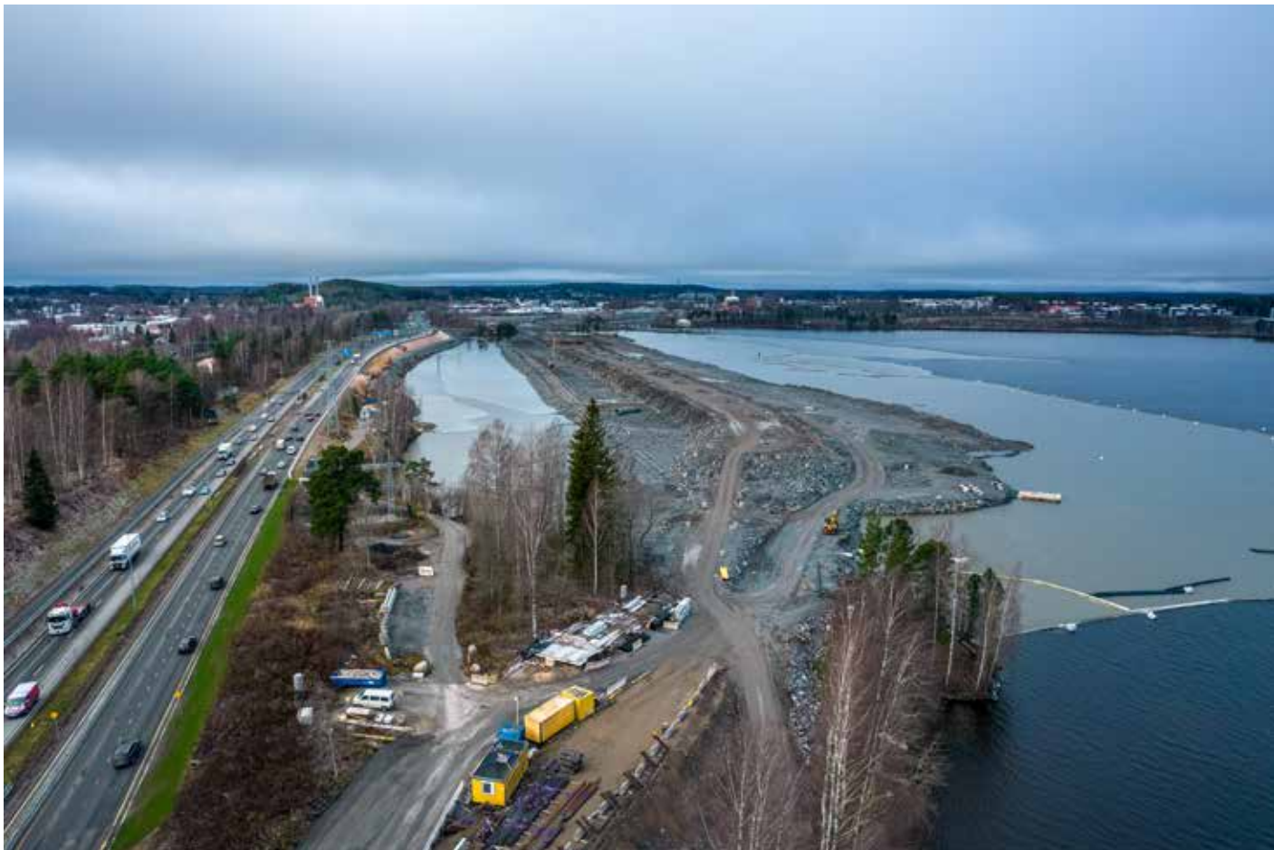
Näsijärveen rakennettu Näsisaari toimii raitiotien reittinä kohti Lentävänniemeä. Saari rakennettiin Tampereen kaupungin toimesta. Kimmo Vallden / Raitiotieallianssi.
