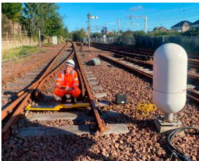
Kuva 1. Larbertin koulutuskeskuksen ulkolaiteosiossa oli esillä siipiopastimien joukossa kuvassa oikealla näkyvä Honeywellin tutka, jonka avulla varmistetaan, että tasoristeyksen puomien välissä ei ole henkilöitä tai ajoneuvoja. Oranssiasuinen henkilö esittelee etäohjattavaa oikosulkujohdinta, jossa jäljempänä lisää.
