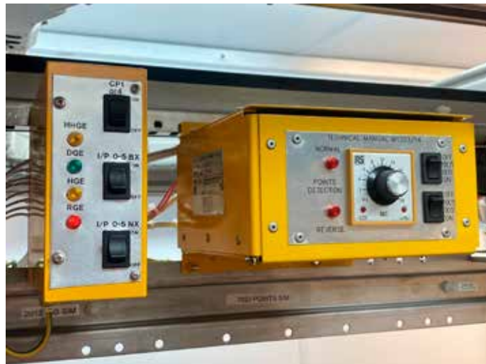
Kuva 5. Koulutuskeskuksen asetinlaitteissa oli vaihteen korvauskytkentä toteutettu astetta hienommalla tekniikalla. Simuloitu kääntöaika oli aseteltavissa potentiometrillä.
