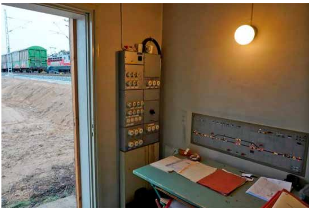
Kuva 1. Vuodesta 1964 uskollisesti Törölän liikennepaikan liikennettä turvannut DrS-releasetinlaite sai kunnian hoitaa Luumäki–Lappeenranta-rataosan viimeisen junakohtauksen 5.11.2022 klo 12.30 ennen uusien turvalaitteiden käyttöönoton alkamista. Liikennetilanne näkyy asetinlaitetaulussa. Huomaa kaadettuna pystytystä odottava uusi lähtöpostin.
