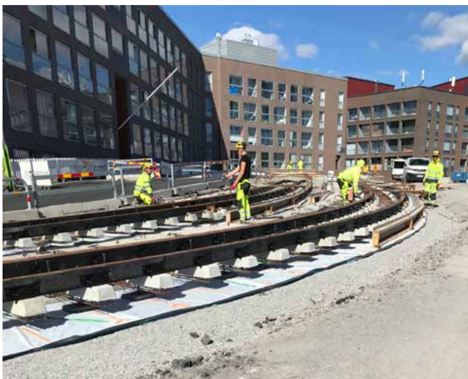
Kuva 3 Kiintoraidelaatan rakenne Kruunusilloilla. Kiskojen aseointi ja kiintoraidelaatan muotitustyö käynnissä (Kuva: Linda Sundholm)
