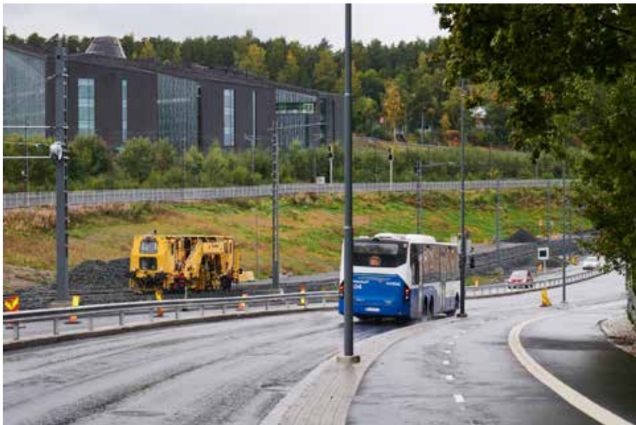
Syksyllä 2022 sepelirataa tuettiin Paasikivenkadulla Ruotsista tulleella tukemiskoneella. Wille Nyysönen / Raitiotieallianssi.
