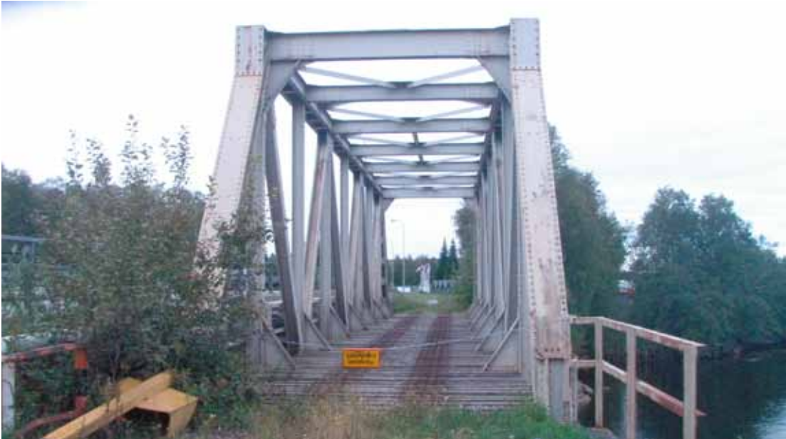
Kuva 4. Satamarata Oulussa on purettu ja Toppilansalmessa oleva vanha Tammerkosen ristikkosilta on käyttämättömänä.
