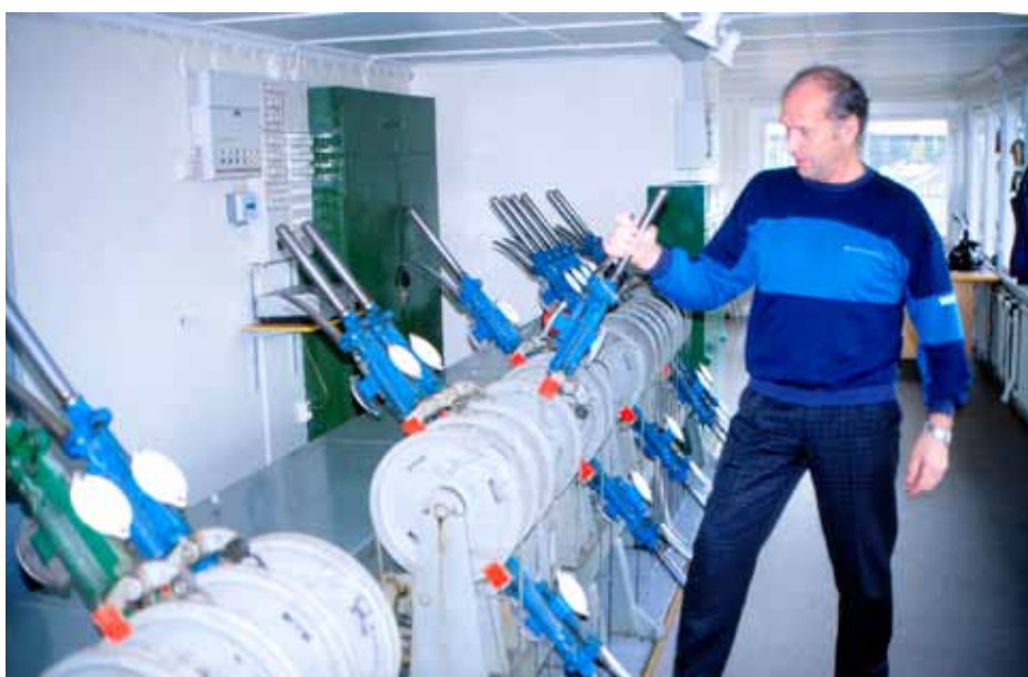
Kuva 1. Rovaniemen kankiasetinlaite vuonna 1995. Kuva Tapio Keränen
