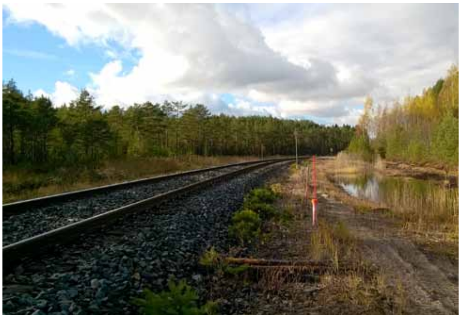
Kuva 5. Hyvinkää - Hanko radalla Vihdissä radan painumia seurataan inklinometriputkin.
