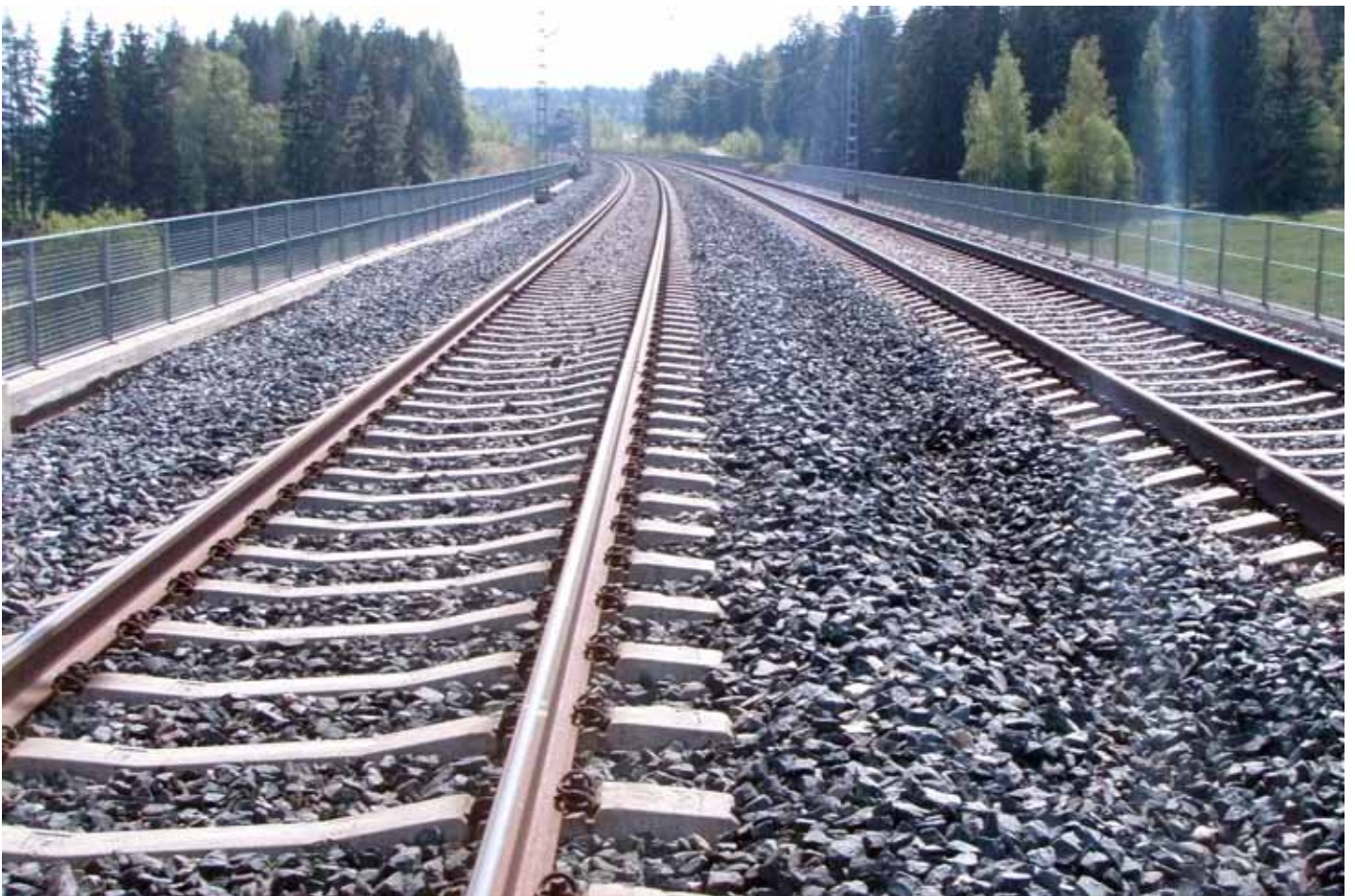
Kuva 1. Lahden oikoradalla raideväli sallii nopeuden 300 km/tunnissa. Kuva Rööpakan pohjoiselta ratasillalta.
