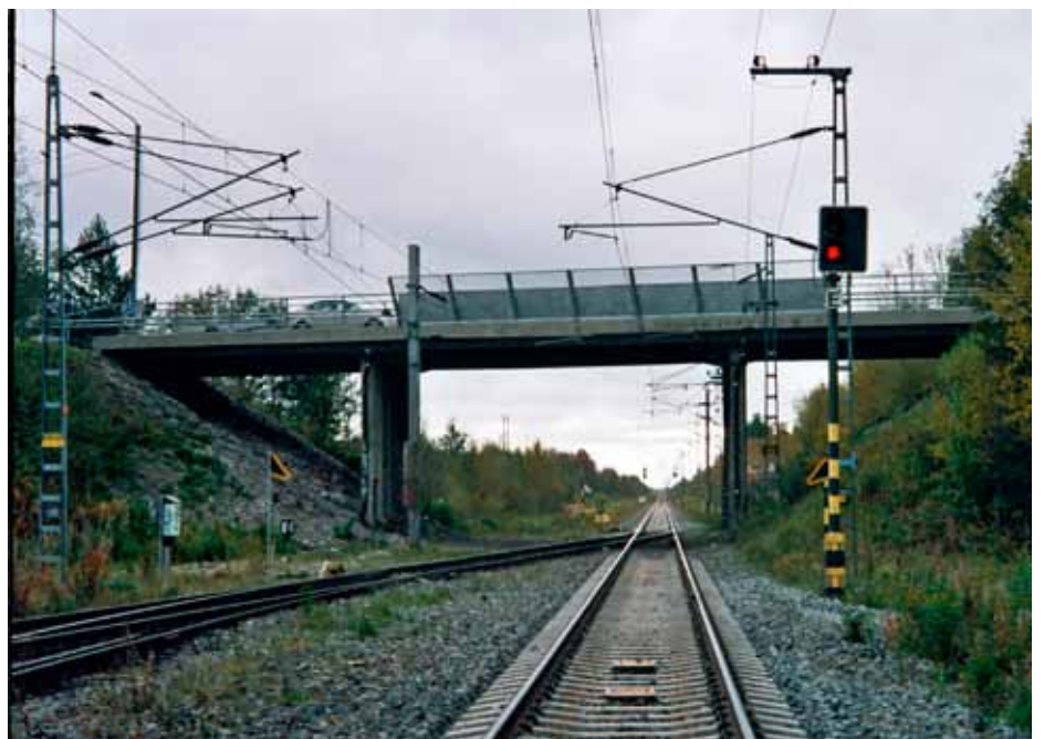
Kuva 3. Ahtaita silta-aukkoja on rataverkolla useita. Kuva Kempeleen ylikulkusillalta.
