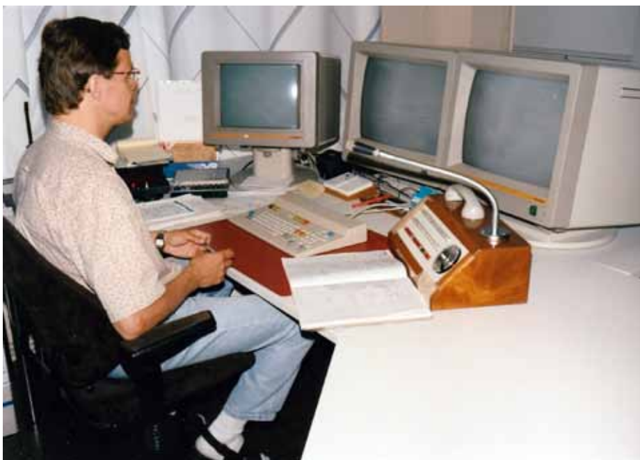
Kuva 5. Jyväskylän asetinlaitteen käyttöpiste vuonna 1991. Kuva Lassi Matikainen
