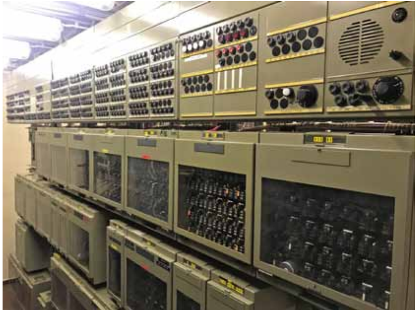
Kuva 2. Oulunkylän releryhmäasetinlaite. Kuva Tero Sorsimo
