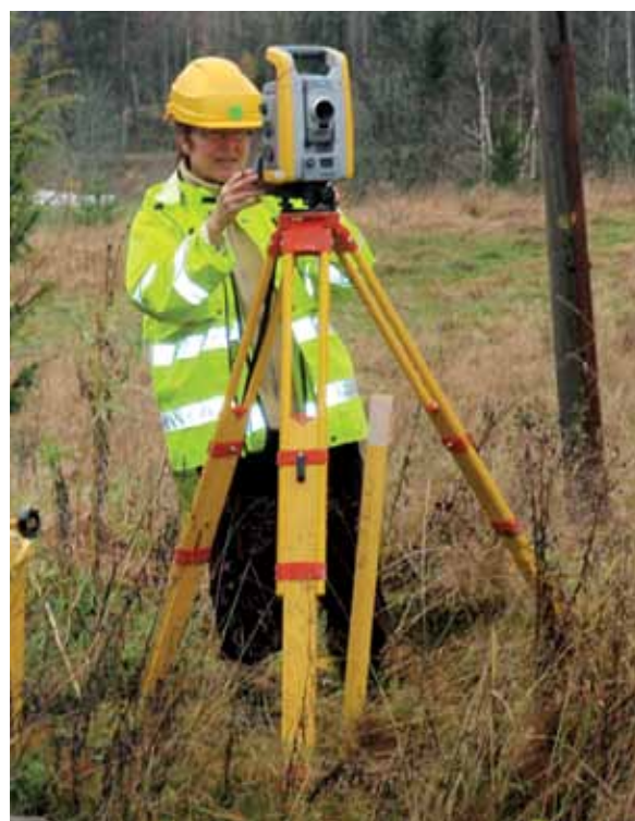
Kuva 5. Mittamies on asemoinut takymetrin suoraan kiintopisteen päälle.
