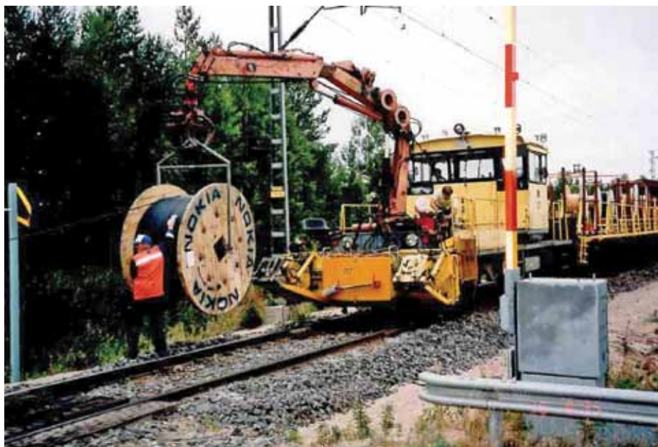
Telekaapeleita aurataan radan varteen, kuva 1990-luvun lopulta. Irja Koskelan arkisto
