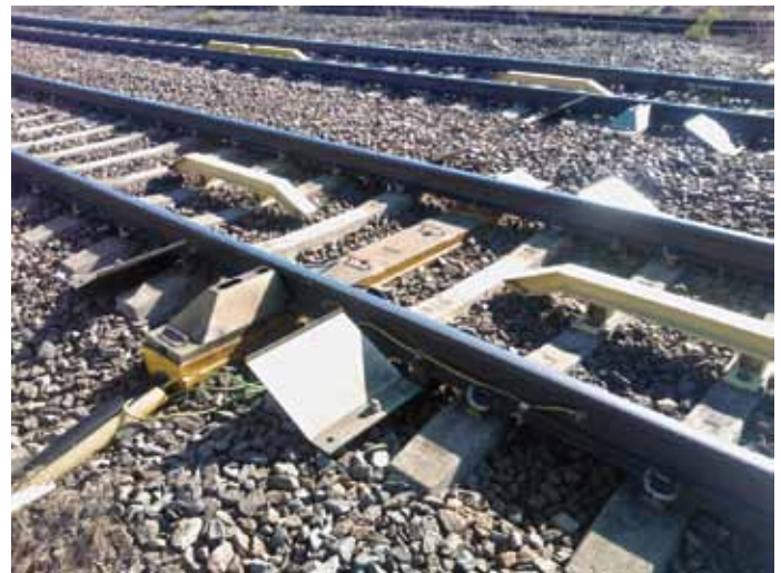
LAKU -järjestelmä liikkuvan kaluston jarru- ja laakerilämpötilan valvontaan
