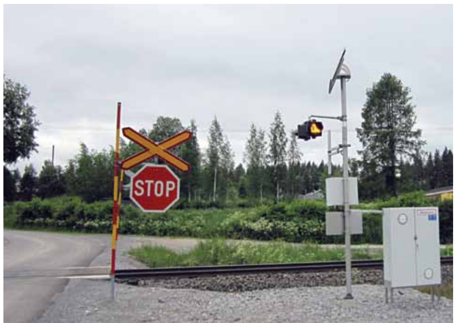
Kuva 1. Huomiolaitte Tähtiniemen tasoristeyksessä (Jet-Tekno Oy)
