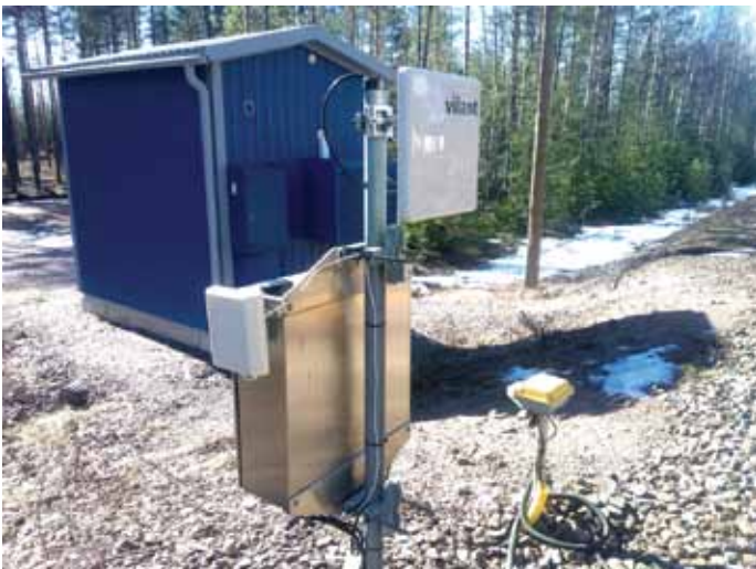
RFID -järjestelmä liikkuvan kaluston vaununumeron selvittämiseksi
