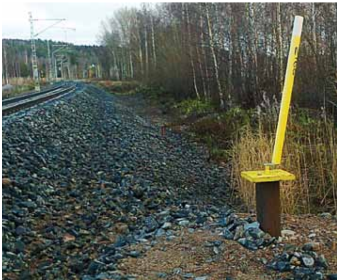
Kuva 3. Pehmeiköalueella kiintopisteen alle on lyöty teräsputki-paalu, mikä ulottuu kovaan pintaan saakka (paikoin jopa 10 metriin).
