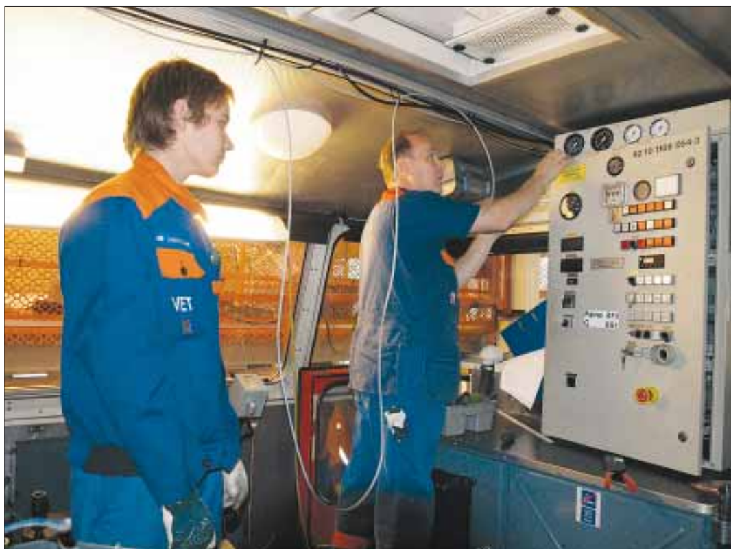
GSM-R-laitteiston asennusta tehdään Hyvinkään konepajalla.
