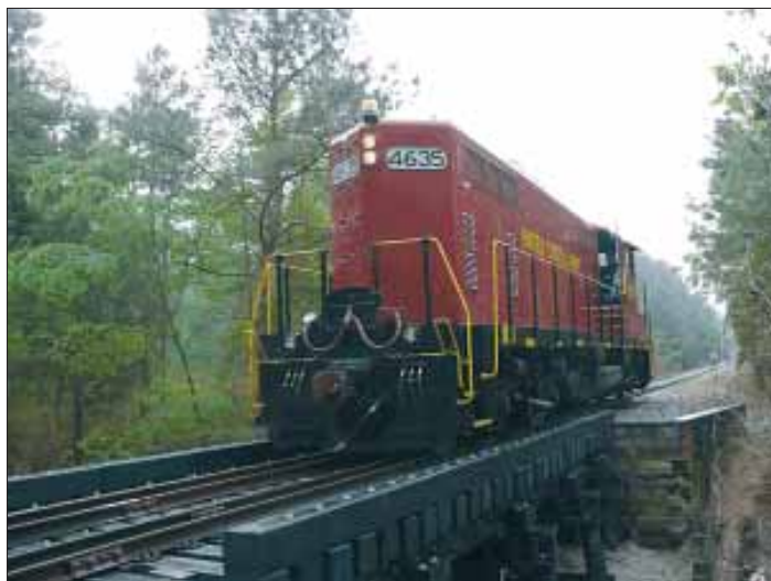
Yhdysvalloissa rakennettu muovisilta on uusi innovaatio (kuva: Parsons Brinckerhoff)
