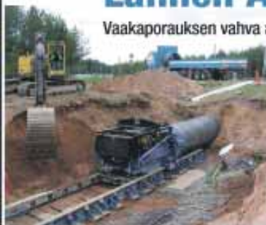
Työntöporausta American Augers 72-1200NG koneella, DN1600 asennus.
