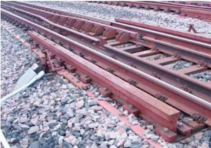
Kuva 4. Kiskonliikunta ja sepelinkatkaisulaite Luhdanmäen ratasillassa. Kuva Janne Wuorenjuuri
