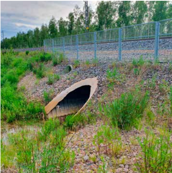
Kuva 8. Putkisillan kaide Uusiojan ratasillassa.
