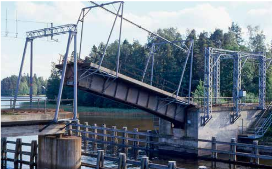
Kuva 3. Päivärannan läppäsilta laskeutuu. Kuvassa oikealla nähdään läppäsillan avaamisen ajaksi sivuun kääntyneet ajojohtimen kannatinorret. Kuva: Markku Nummelin. Kuopio, 14.9.1985.
