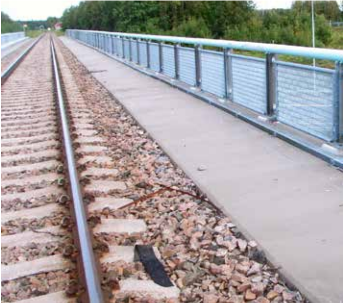
Kuva 11. Hyvä esimerkki muunlaisesta kaiteesta Kyläjoen alikulkusillassa.
