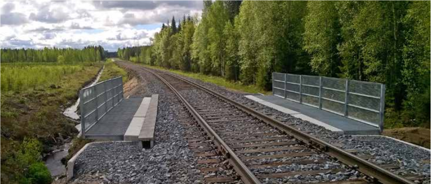
Kuva 9. Wuorenuuren ratasillalle asennetut uudet kaiteet, huoltokäytävät ja kulmatukimuurielementit.
