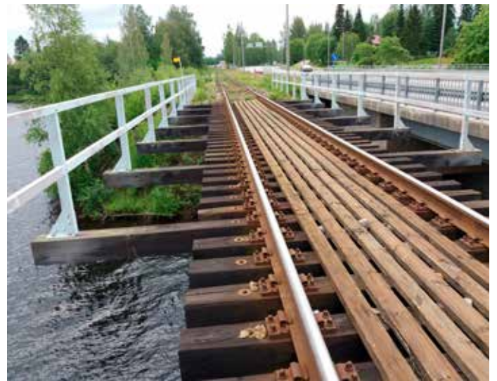
Kuva 4. Kaiteet kiinni ratapölkkyissä Palavansalmen ratasillassa.
