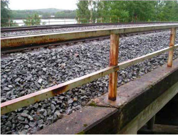
Kuva 5. Reunapalkkiin upotetut kaiteet Rauhalan alikulkusillassa.
