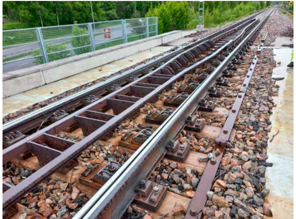
Kuva 2. Halssilan alikulkusilta, Jyväskylä, kiskonliikuntalaite. Kuva Janne Wuorenjuuri
