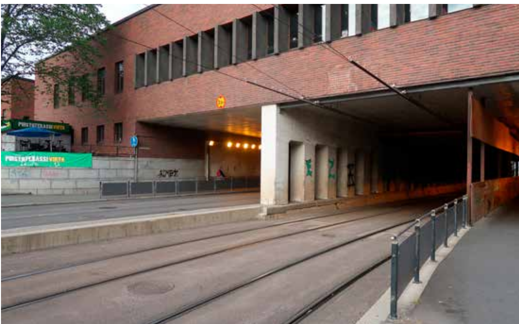
Kuva 6. Raitiotien ajojohtimen ja kiintoajojohtimen liittymäkohta Tampereen henkilöratapihan alittavassa alikulkutunnelissa. Kuva kirjoittajan. Tampere, 18.8.2023.
