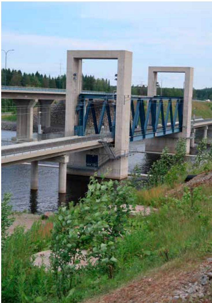
Kuva 4. Tikkalansaaren vuonna 2011 valmistunut ja Päivärannan läppäsillan korvannut nostosilta Kuopiossa. Kuva kirjoittajan. Kuopio, 19.6.2019.
