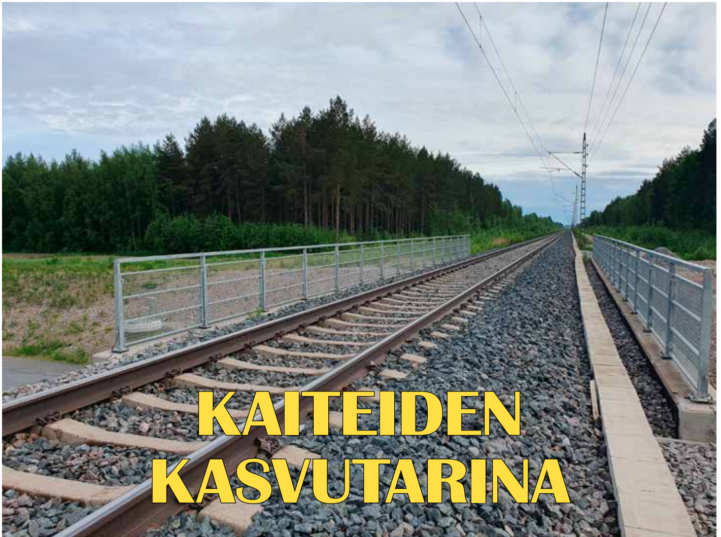
Kuva 1. Kaiteet parantavat turvallisuutta rautatiesilloillakin (Tuuliharjan alikulkusilta).
