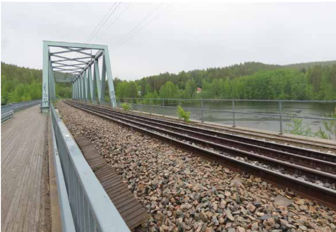
Kuva 4. Sillalla on rautatien lisäksi jalankulkureitti ulokkeella.
