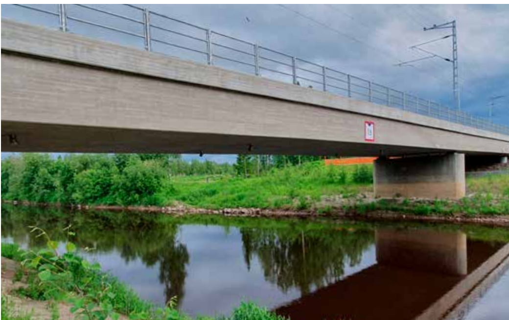
Kuva 12. Uusi kaide sopii myös isoihin siltoihin, kuten Temmesjoen ratasillassa.
