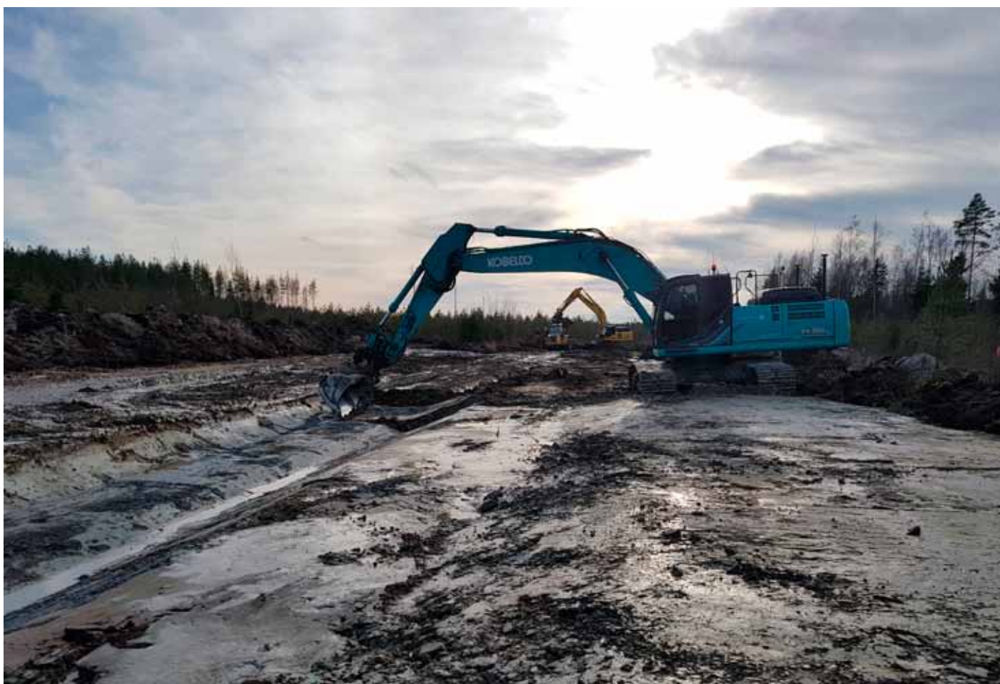
Kuva3. Vesijohdon rakennustyöt käynnissä lokakuussa 2017. Kuva Anssi Viiru, Ramboll CM Oy
