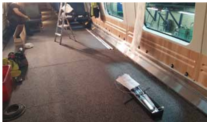
Kuva 7. Ekstra-maketti käynnistyi lattiamaton asennuksella.
