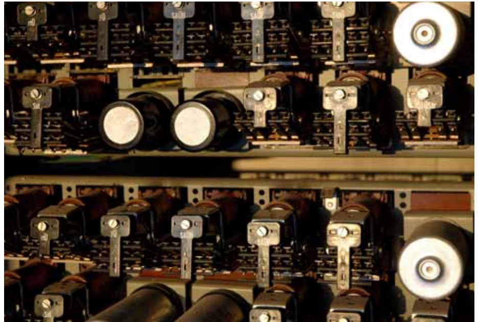
4. Kaikki Siemensin relepohjaiset suojastusjärjestelmät perustuvat K50-turvallaitereleeseen. Niin myös Tuomiblock. Kuva: Tero Sorsimo
