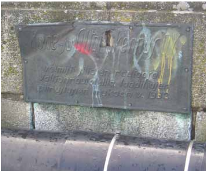
Kuva 2. Sillan tuessa on kiinni vähän kärsinyt laatta sillan rakentamisen ajoilta.
