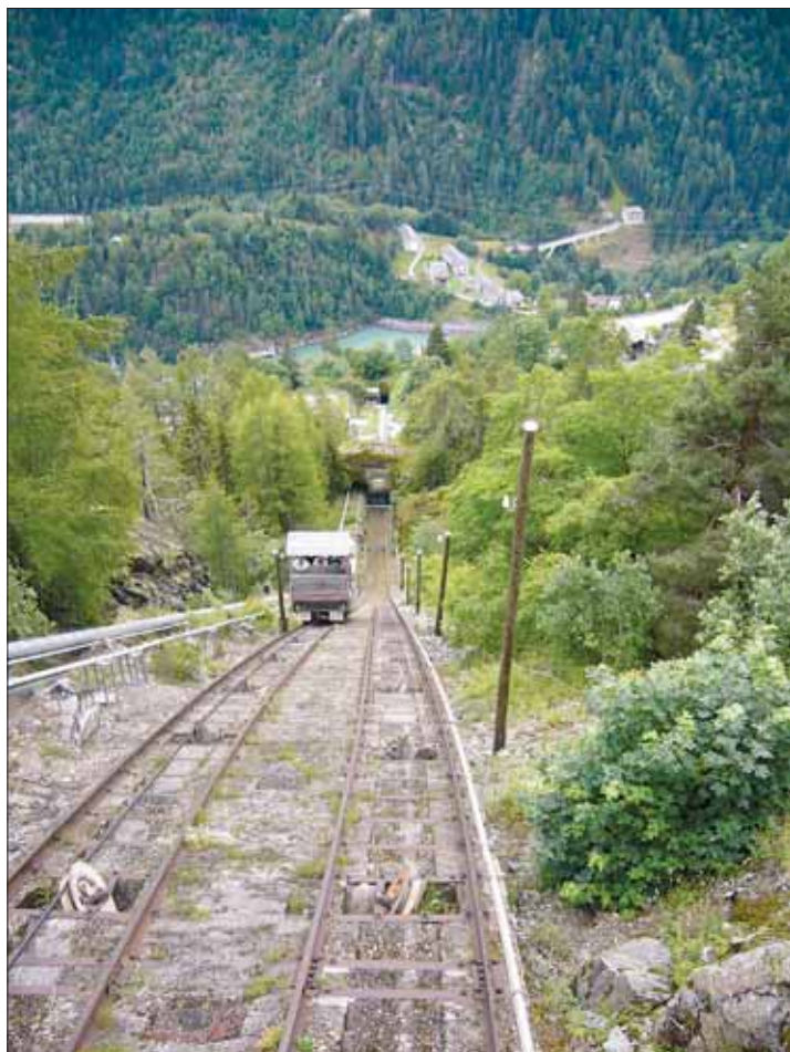
Eri suuntiin matkaavat vaunut kohtaavat ohitusraiteella. Radalla on myös tunneleita.
