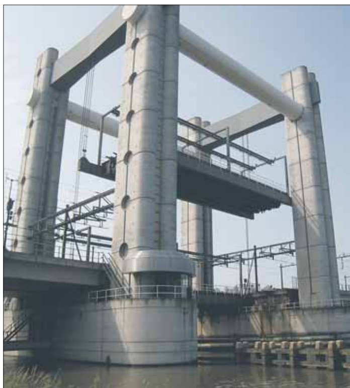
Kuva 6. Sillan kumpikin kaksiraiteinen sillalohko voidaan nostaa erikseen.
