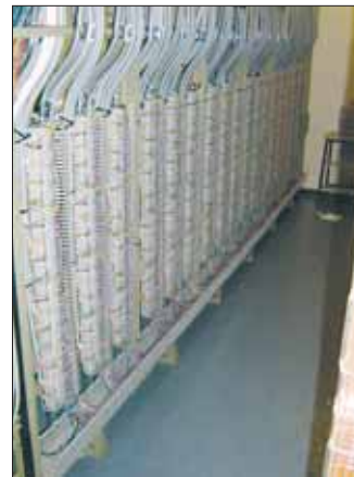
Riihimäen asetinlaitteen ja ESKOn kytkentärajapinta.
