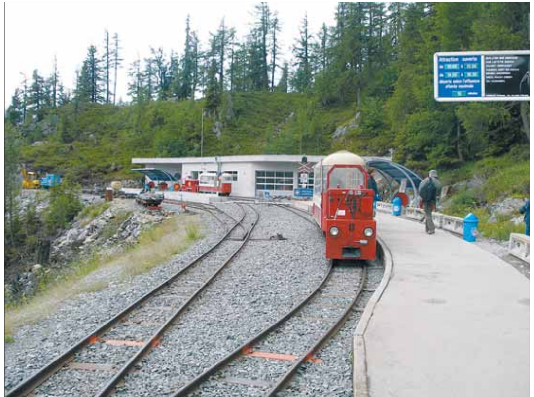
Kapearaidejunan varikko ja pääteasema Château d'Eau.
