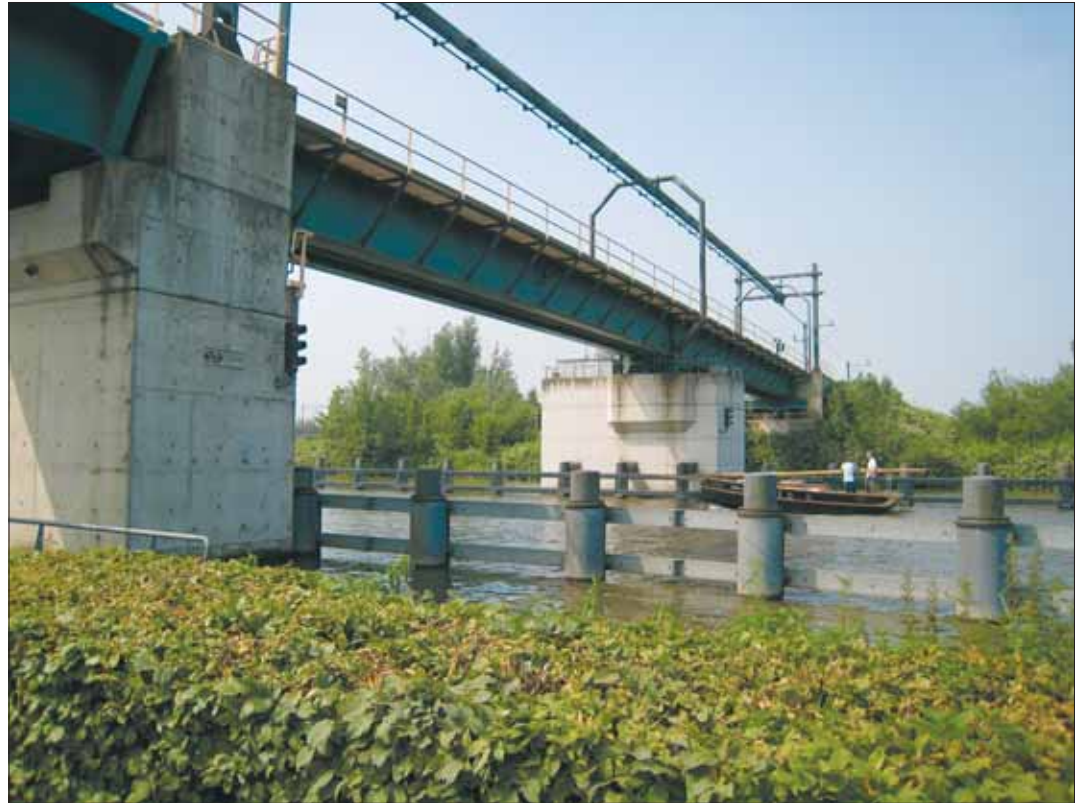
Kuva 7. Ajolanka on kiinnitetty järeään teräsputkeen.
