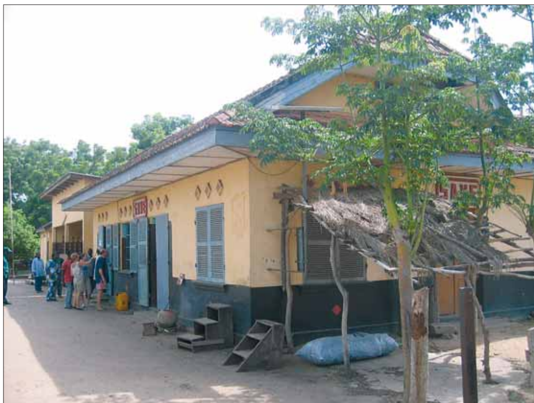
Viime vuosisadan vaihteessa rakennetut asemat olivat yllättävän hyvässä kunnossa.
