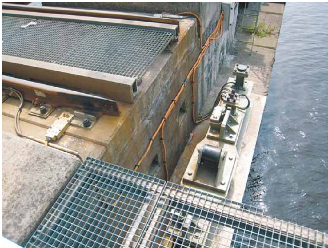
Kuva 5. Silta on varustettu sillan kontrollointijärjestelmällä.
