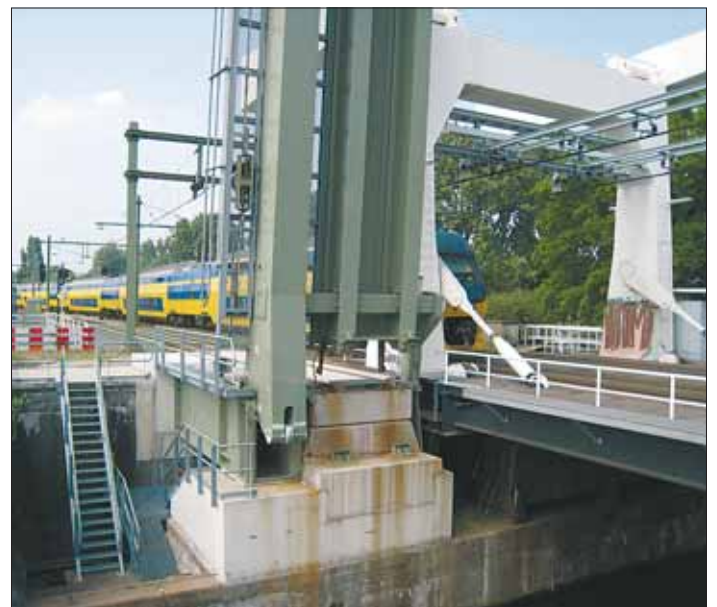
Kuva 4. Silta avataan vain yhdellä hydraulisylinterillä, joka on nivelöity reunassa olevan palkin alapäähän.
