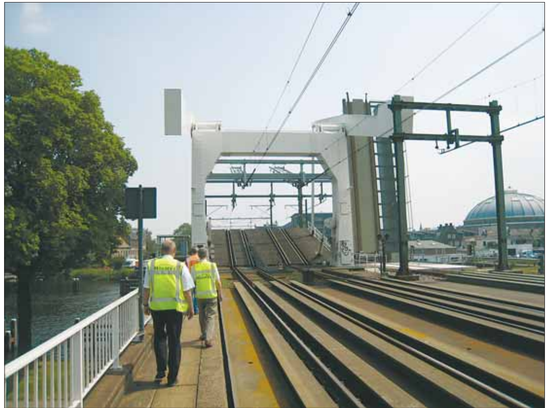
Kuva 3. Yksiraitainen silta aukiasennossa, kaksiraitainen avautumassa.
