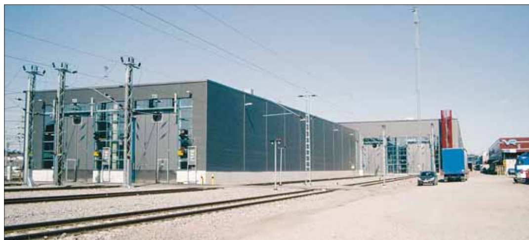
Pendolino-halli etelästä katsottuna. Kahdesta vasemmalla olevasta ovesta junat ajetaan pesukoneen läpi huoltohalliin, oikealla kauempana kaksi ovea vie suoraan huoltohalliin.
