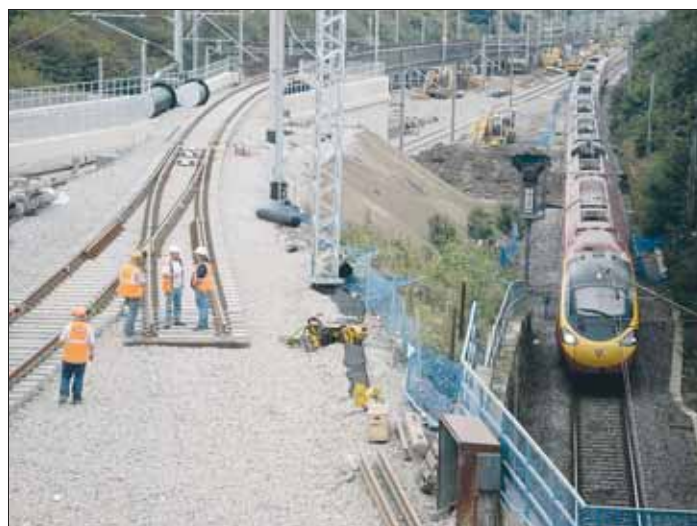
Kuva 4. Vaihteen RN340 asentaminen
