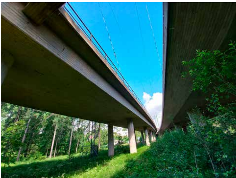
Kuva 3. Pohjoisille ja eteläisille raiteille on omat siltansa.
