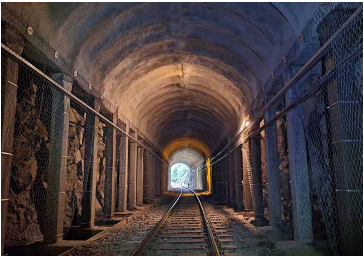
Kuva 5. Möykymäen tunnelin ahdas kehärakenne.
