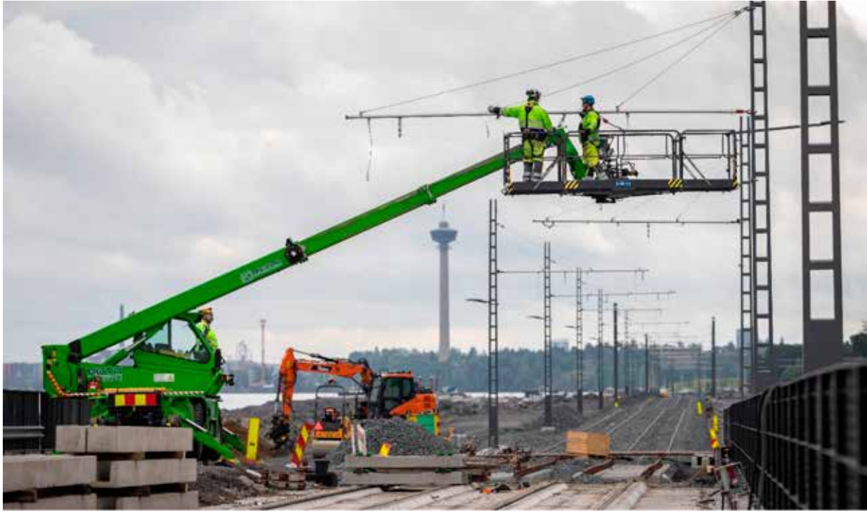
Kuva 3: Loppuvuonna on tehty muun muassa raitiotien ratasähköistystöitä Näsisaarella. Näsinneula siintää horisontissa. Jonna Mattila / Raitiotieallianssi
