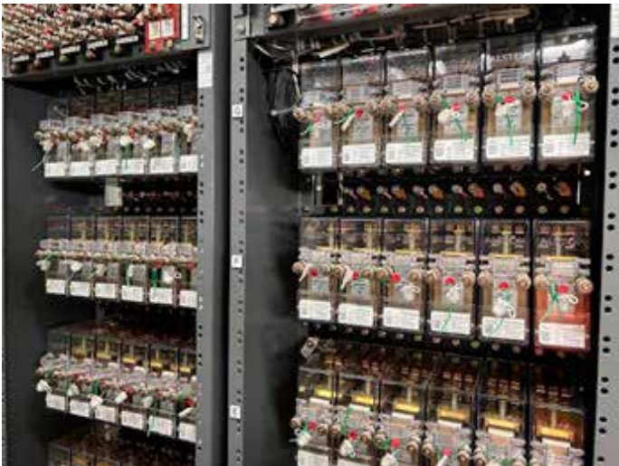
Kuva 9. Toronton metron asetinlaitereleistä. Releet toimivat tässä asetinlaitteessa asetusosina.
