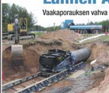
Työntöporaus American Augers 72-1200NG koneella, DN1600 asennus.
