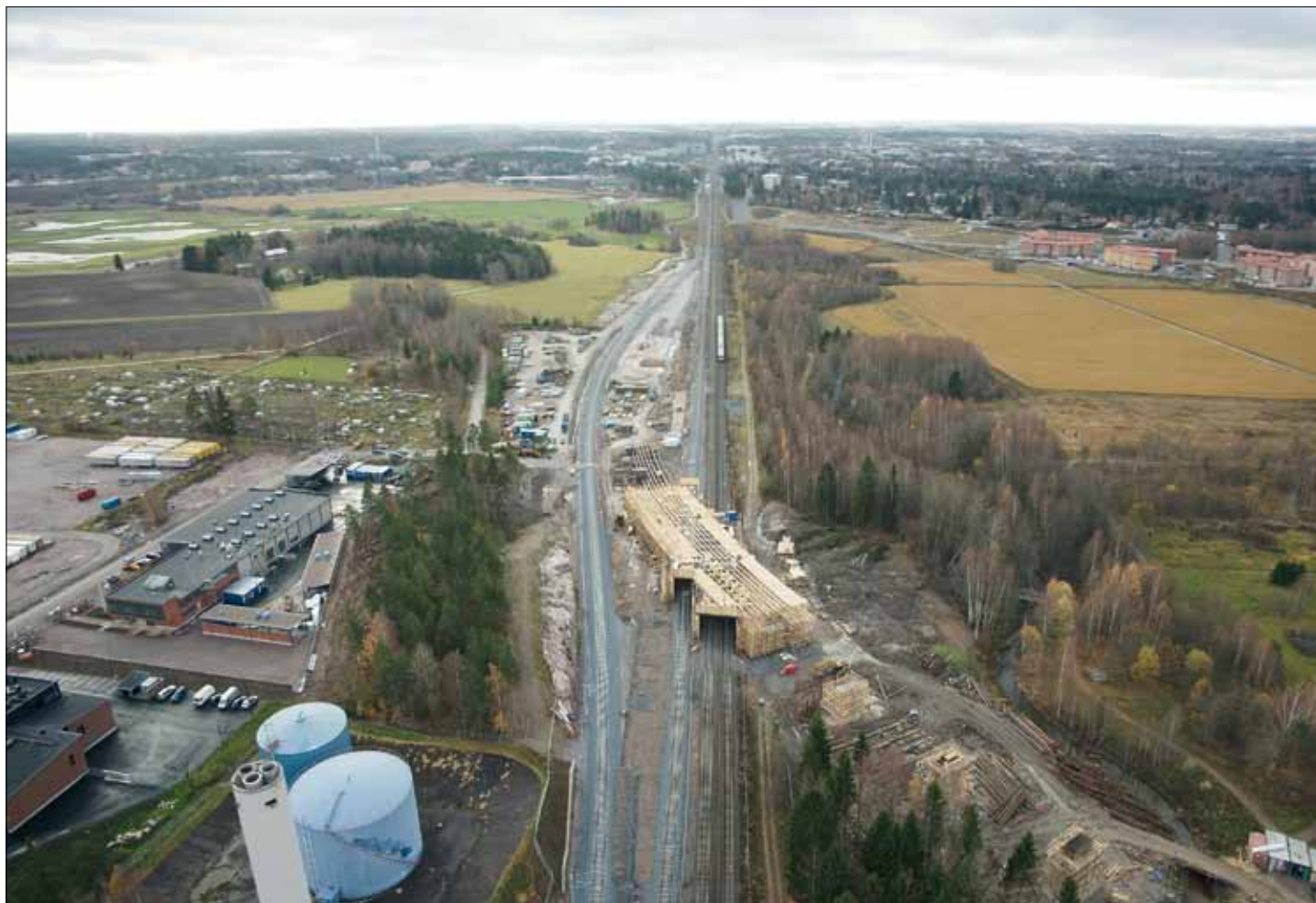
Koivukylän rautatieristeyssiltaa rakennetaan junaliikenteen keskellä.
