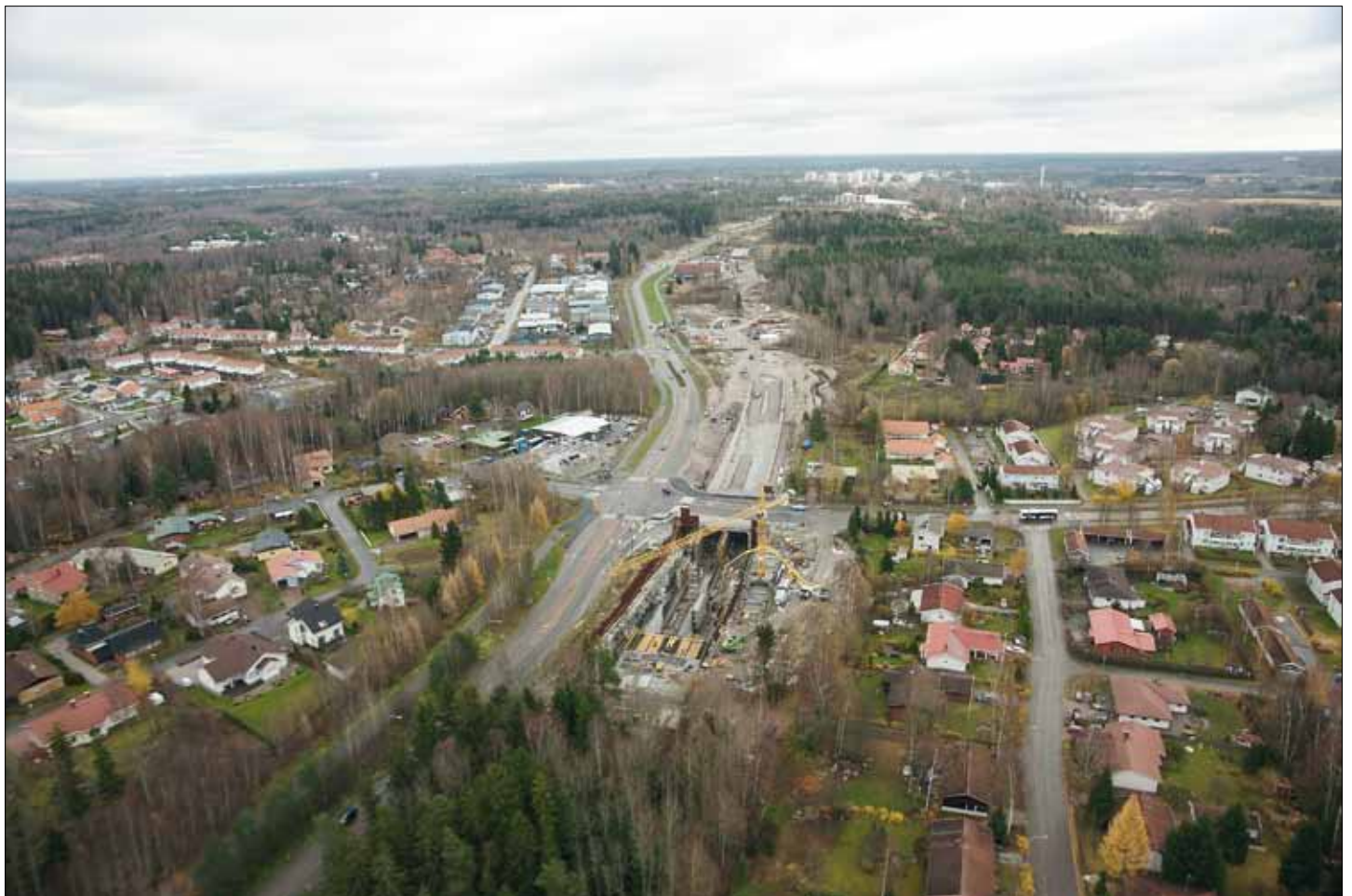
Itäinen suuaukkotyömaa ja MRU 4 Ilolassa.
