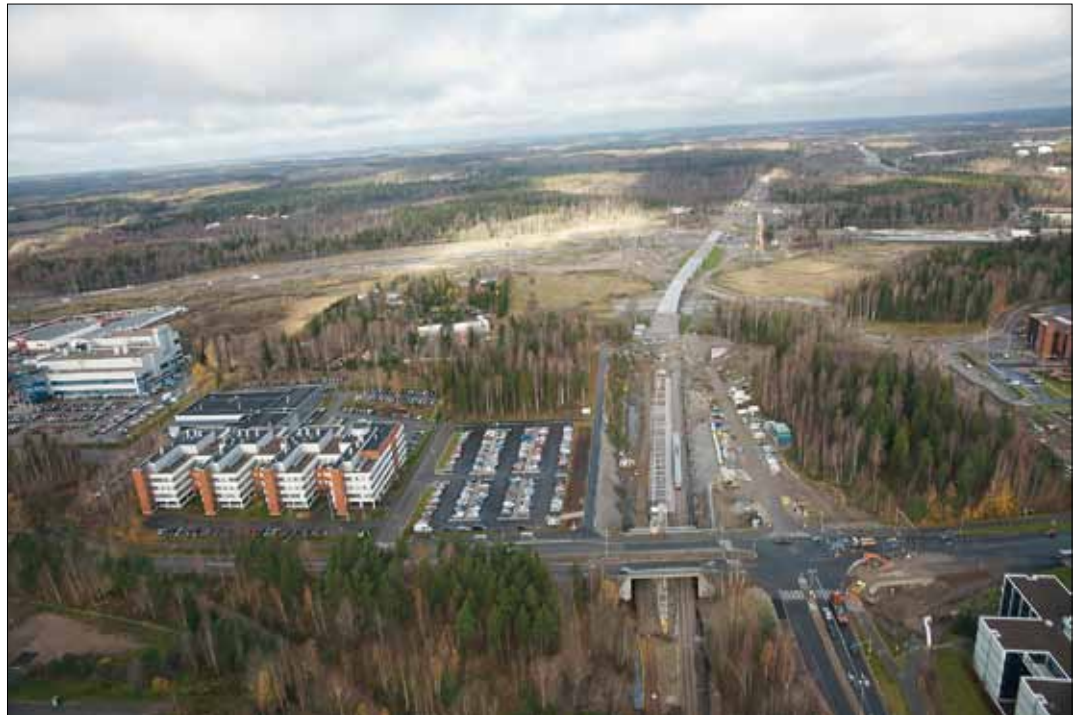
Vantaankosken asema kunnostetaan Kehäradan asematasolle.
