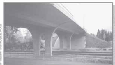
Kuivattujen siltojen korjaus, Äänekoski
