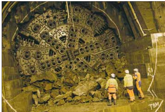
Hallandsåsin tunneli puhkaistiin tunneliporakoneella (kuva BV).
