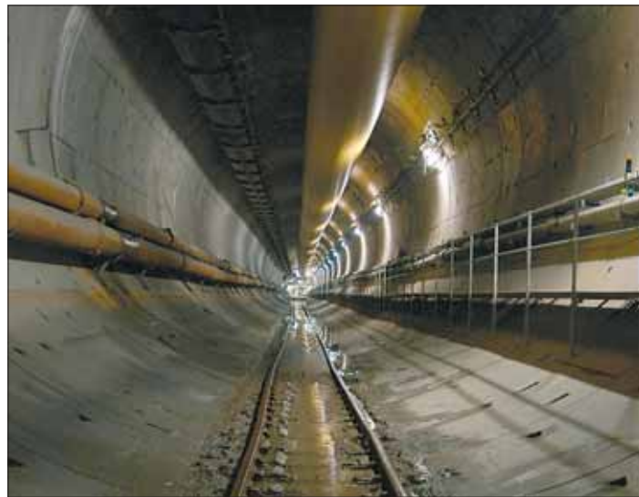
Hallandsåsin tunneli on jouduttu vuoraamaan tiiviillä betonielementtikerroksella (kuva BV).
