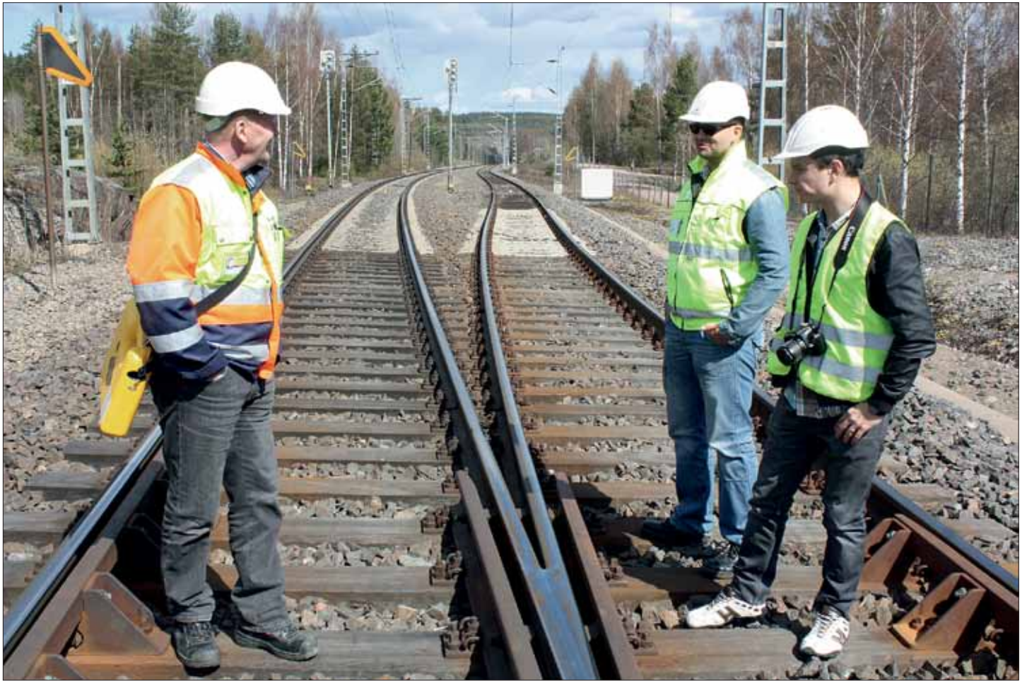
TERA-tutkimuksiin kuuluu myös runsaasti kenttätöitä. Oikealla Riku Varis TTY:stä ja Tuomo Viitala Liikennevirastosta tutkivat vaihteen risteyksen kuntoa keväällä 2012.
