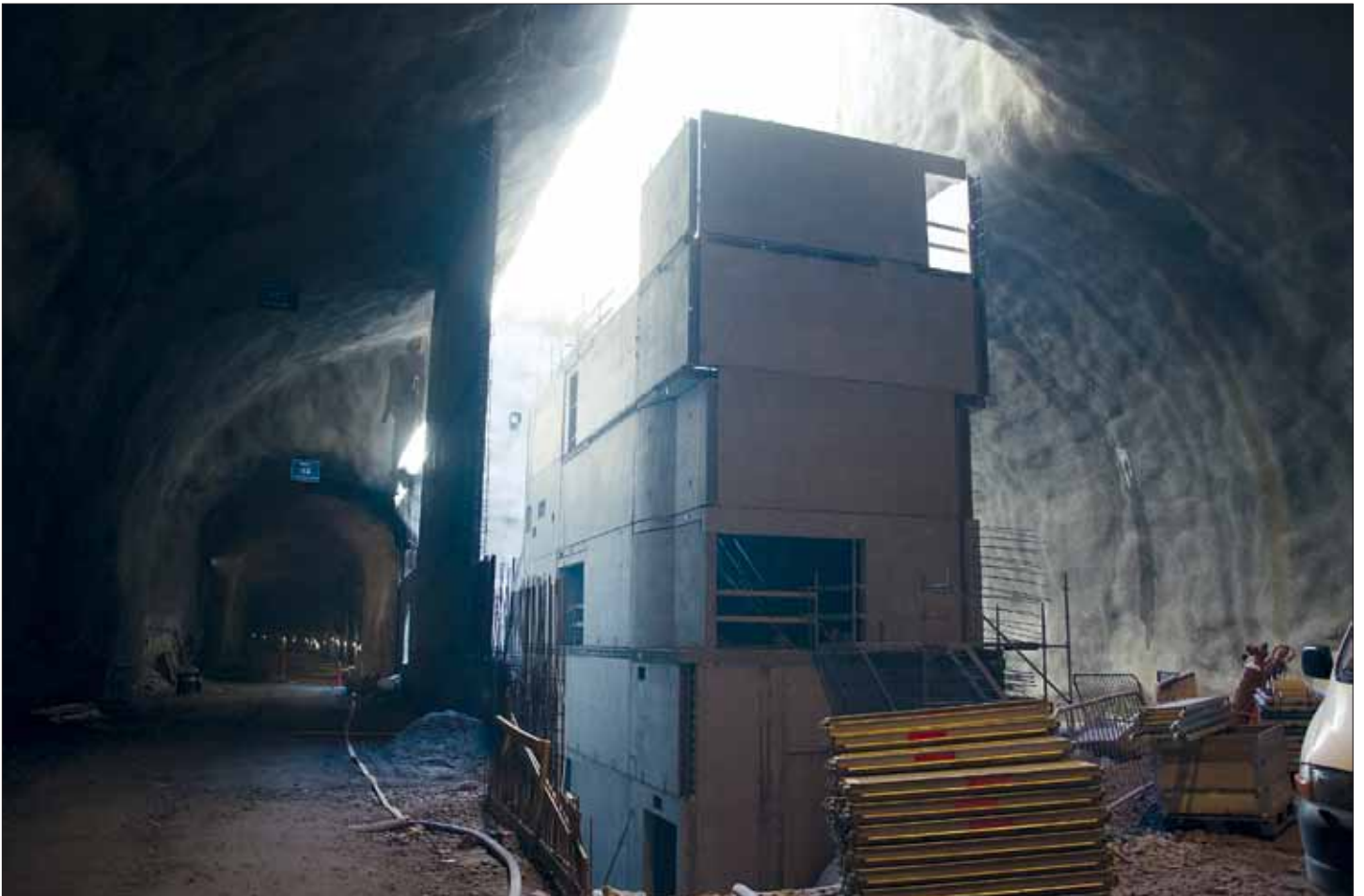
Aviapoliksen aseman porrasmousut rakentumassa.
