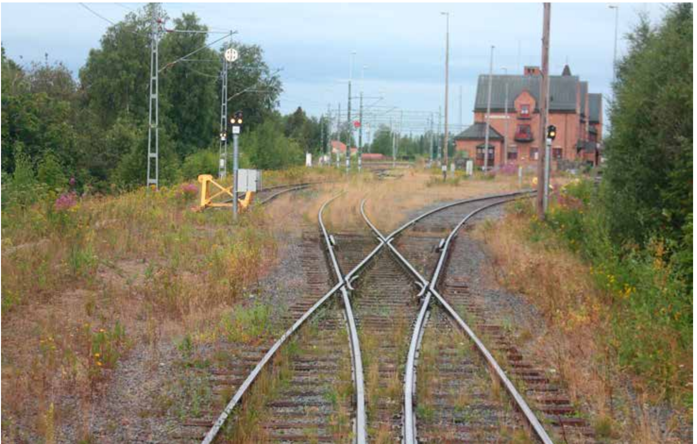
Haaparannan ratapihan itäpää. Vasemmalle vie 1435 mm raide, jolla puolella on myös käytössä oleva Ruotsin 15 kV sähköistys. Oikealle vie 1524 mm raide, jonne on suunniteltu toteutettavan 25 kV sähköistys. Kuva Markku Nummelin
