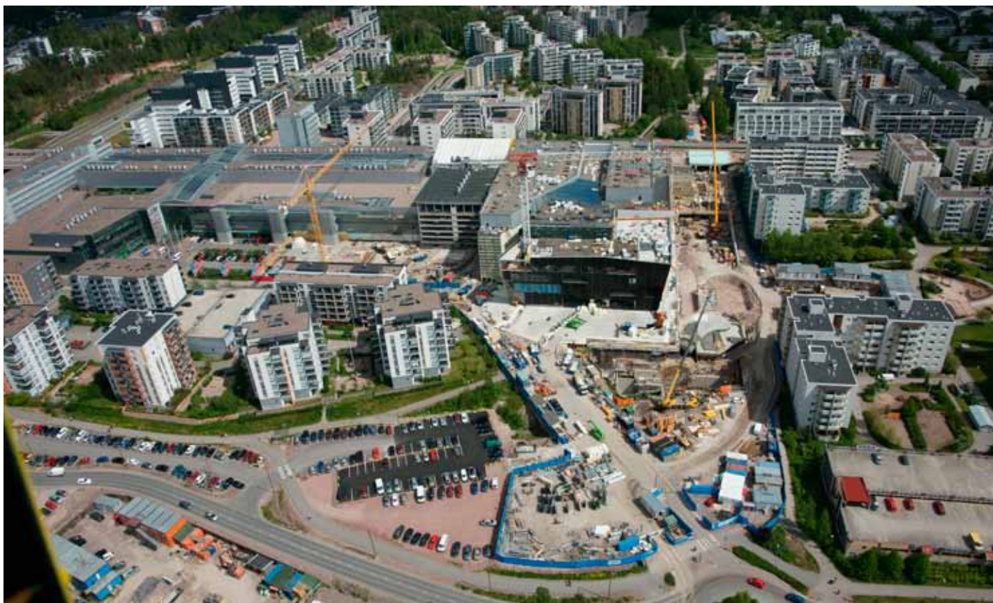
Ilmakuva Matinkylästä kesäkuussa 2015. Ison Omenan laajennus ja Matinkylän metrokeskus valmistuu kesällä 2016. Laajennuksessa sijaitsee myös liityntäbussiterminaali, josta on yhteys metroon ja pysäköintilaitokseen. Kuva: Länsimetro.
