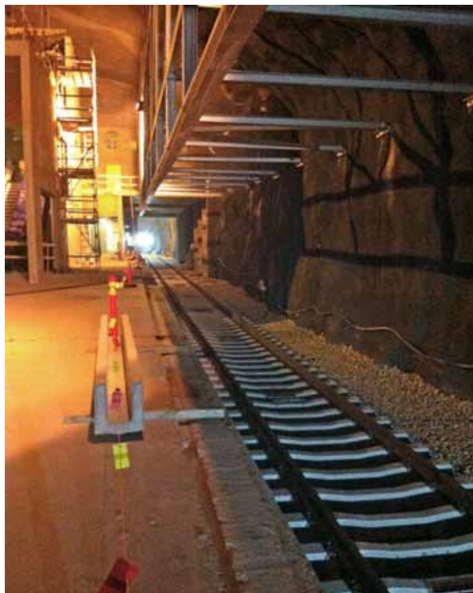
Kiskoasennus Niittykummun asemalla elokuussa 2015. Kuva: Aarno Huovinen.
