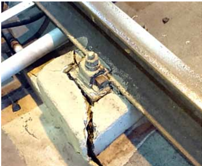
Kuva 5. Uudelleen pinnoitettu korrosoitunut raidepilari.
