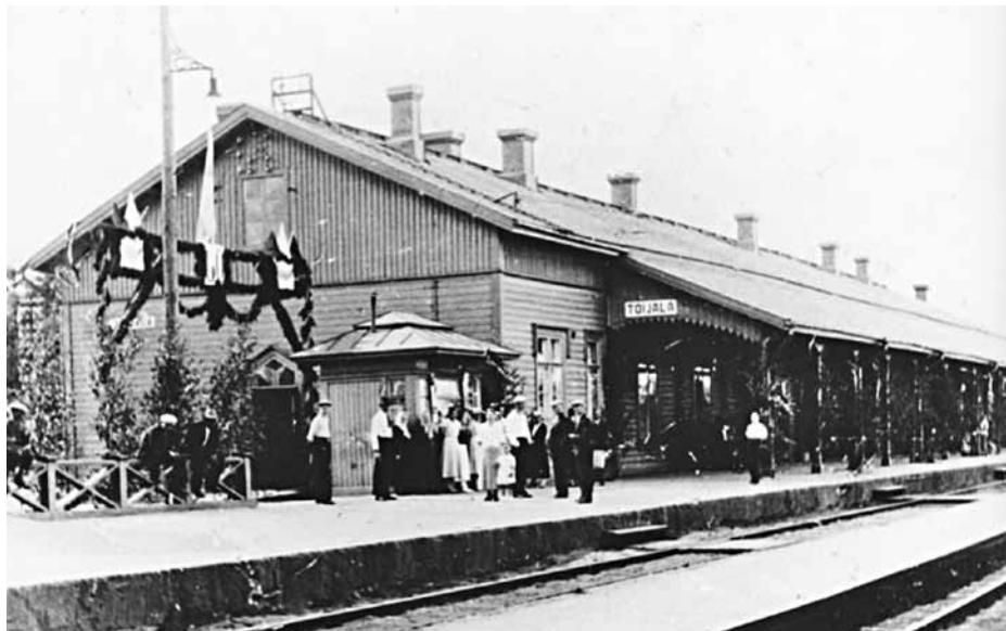
Rautatien tulon 60-vuotisjuhlaa vietettiin näytävästi 24.6.1936. Pääjuhla oli kylän urheilukentällä, mutta luonnollisesti myös asema oli koristeltu.
