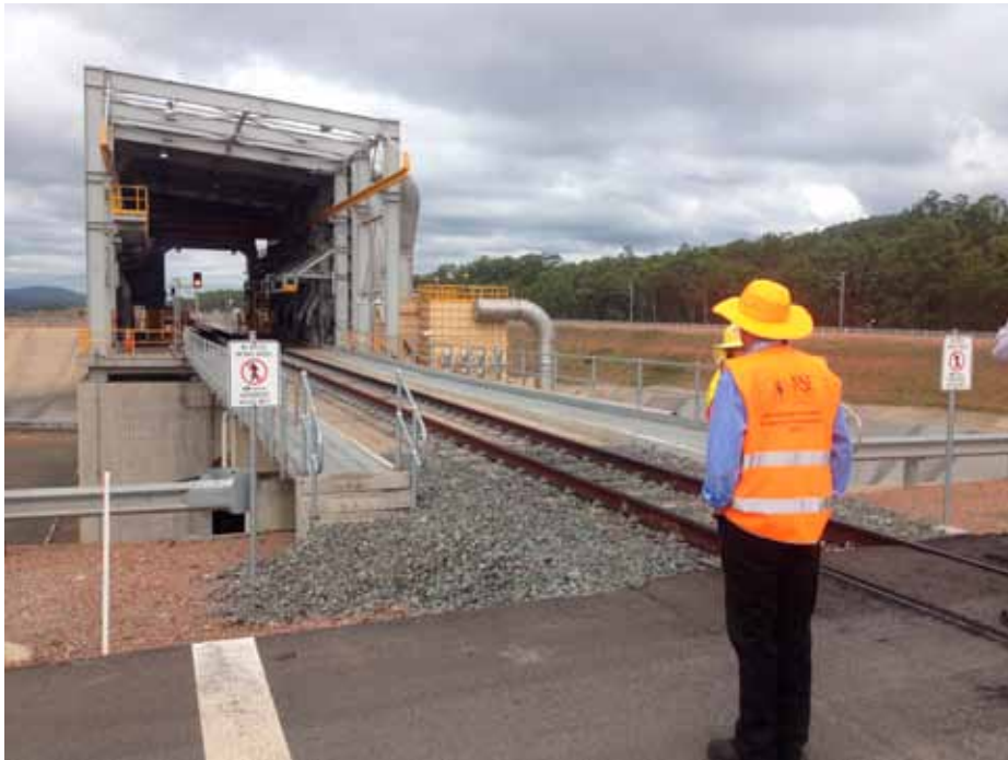
Hiilen purkausasema Wiggins Islandilla. Tästä hiilen matka satamaan jatkuu maanalaisella hihnakuljettimella.
