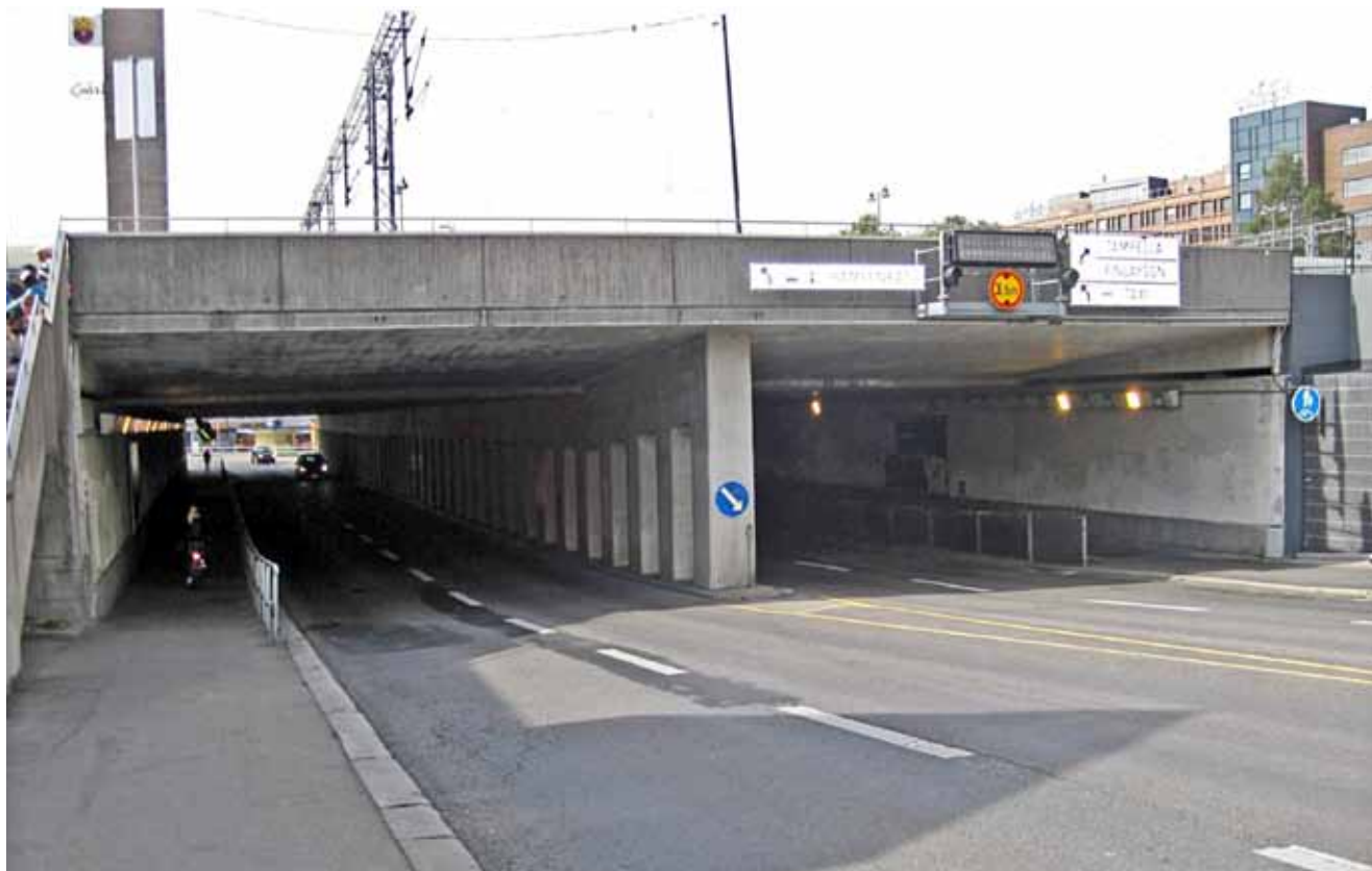
Silta-aukot Tammelasta päin katsottuna ja levitys itäreunalla vuodelta 1989. (Kuva Janne Wuorenjuuri)
