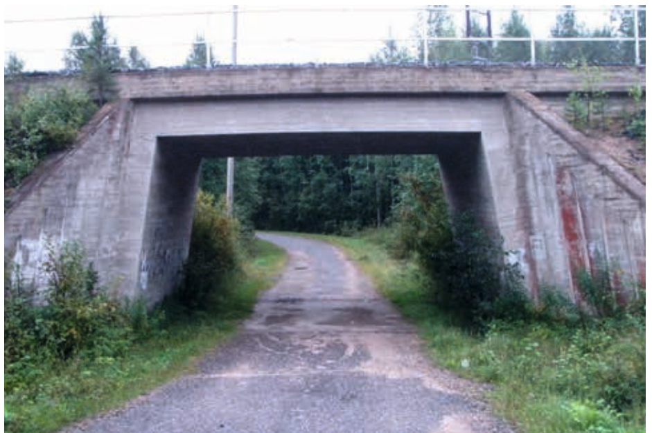
Kuva 10. Rovaniemellä Nivavaaran alikäytävä rakennettiin siirtämällä 1982.
