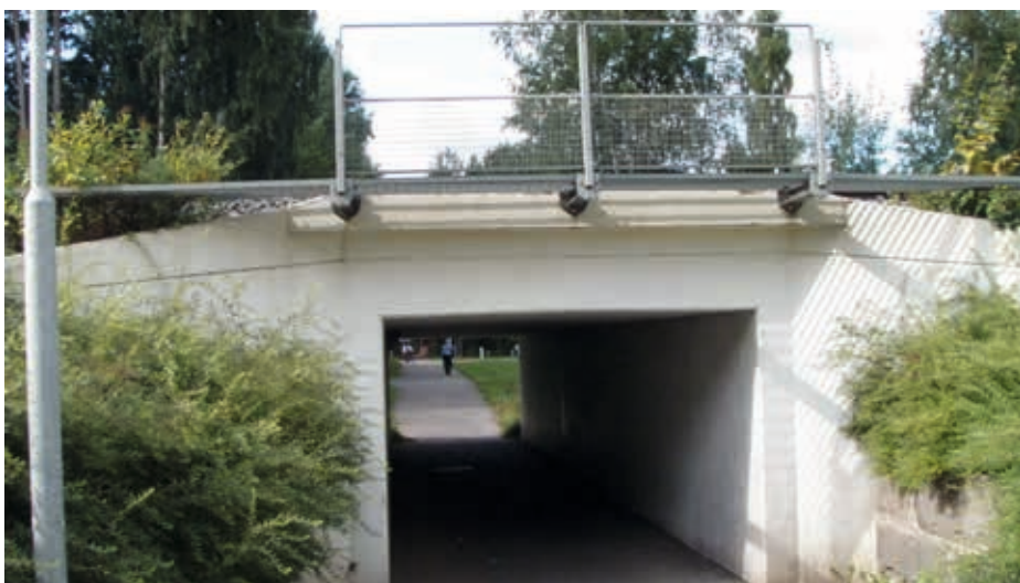
Kuva 6. Hyvinkäällä Paavolan alikäytävä rakennettiin 14 metrin apusiltojen alla vuonna 1972.
