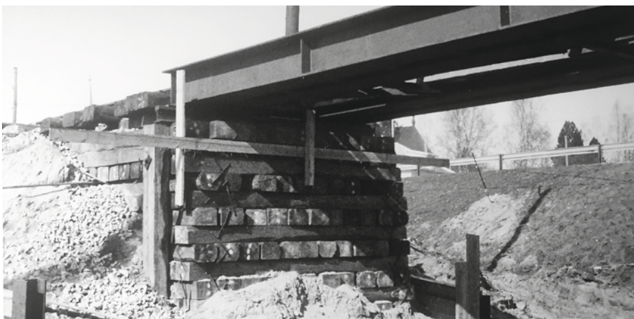
Kuva 4. Keuruulla apusilta, pölkkyristikko ja laakerikisko maatuella (kirjoittajan kuva-arkisto).
