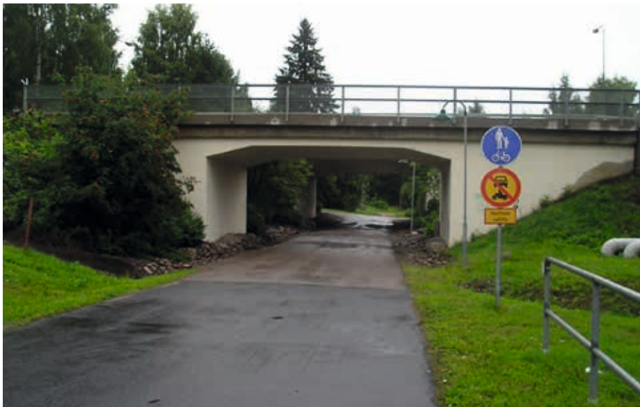
Kuva 5. Keuruun alikäytävä valmiina.
