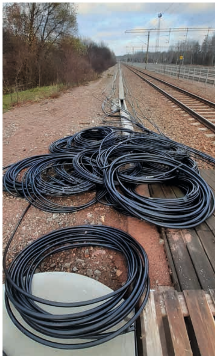
Kaapelinedon jäljiltä kaapeleita kerällä odottamassa kaivoon vientiä.
