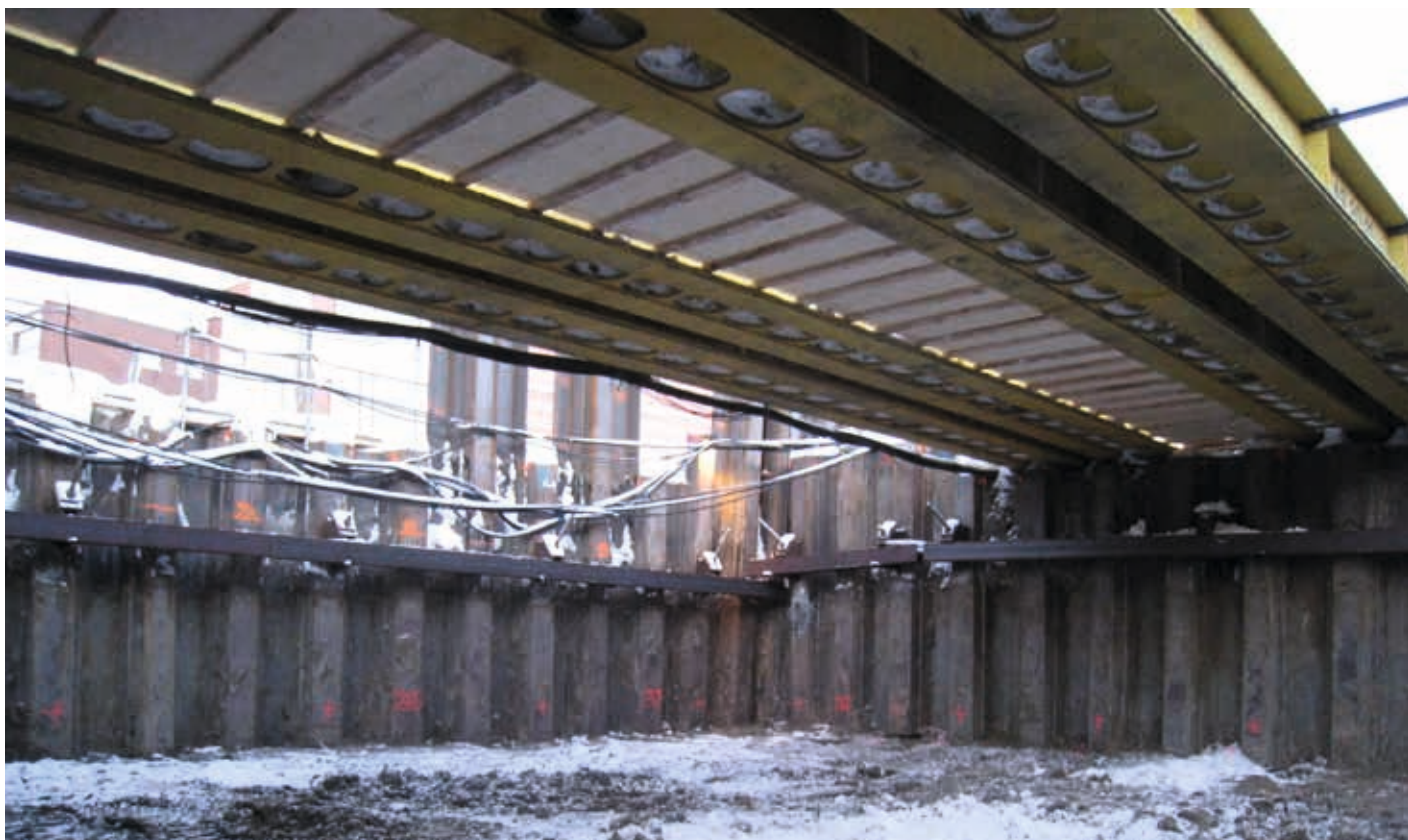
Kuva 11. Tampereella Rongankadun alikäytävän kaivanto apusiltojen alla keväällä 2011 (kuva Swecon kuva-arkisto).
