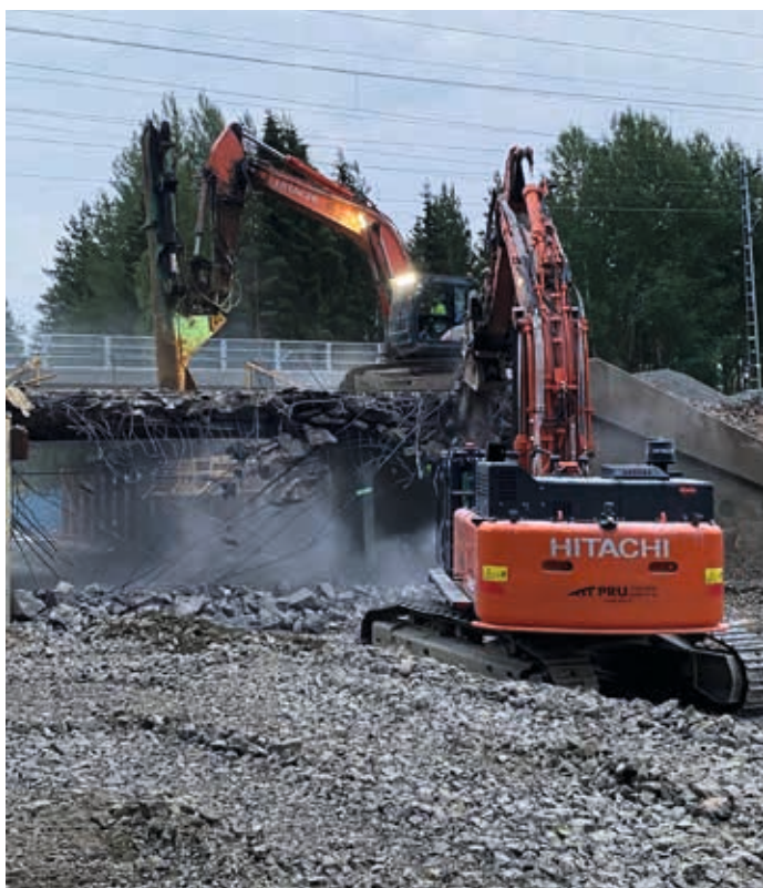
Vanhan sillan purku on käynnissä.
