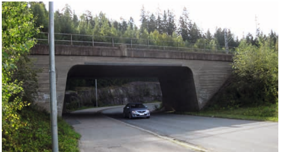
Kuva 9. Tampereella Rukkamäen alikulkusilta rakennettiin apusiltajonon alla.
