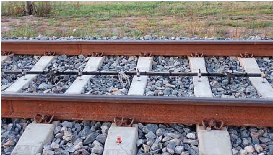
Kuva 1. Kairatankoihin tukeutuva suora siirtymämittaus koekohteella km 98+430. Kuva Heikki Luomala.
