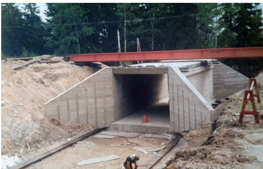
Kuva 7. Nokian Nahkolan alikäytävän työmaa vuona 1979 (kirjoittajan kuva-arkisto).
