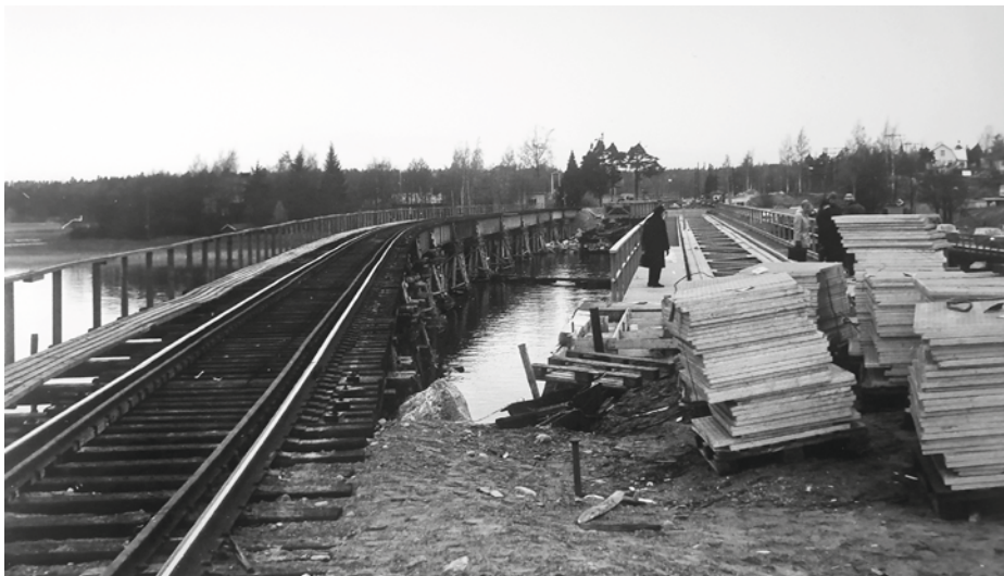
Kuva 2. Pohjan kääntösillan rakentamisen takia tehtiin meren päälle väistöraide (kirjoittajan kuva-arkisto).
