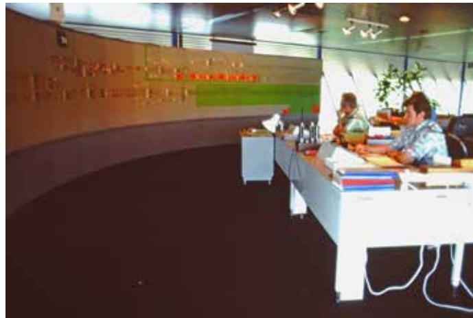
Kuva 5. Liikenteenohjaustyö käynnissä vuonna 1975. Kauko-ohjausalueet eroteltiin taulussa aluksi vihreällä ja punaisella pohjaväriillä. Martinlaakson rata punaisella. Sen yläpuolella miehitetty Pitäjänmäki, josta saatiin vain ilmaiset. Tulevat Malmi ja Tikkurila vihreällä. Oulunkylän katsottiin kuuluvan Helsinkiin, vaikka oli DUS-kauko-ohjauksessa. (Lassi Matikainen)
