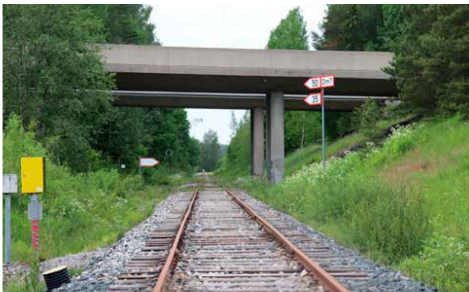
Maanpäällisten ratojen vaihtoehdossa itärata ylittäisi nykyisen Porvoon museorautatien moottoritiesiltojen rinnalla niiden pohjoispuolella (kuvassa siltojen takana), ja keskustan haara tulisi siltojen ali vanhan radan kupeessa (kuvan vasemmassa reunassa) jatkuena tulevalle lähiliikenneasemalle. Kuva Markku Nummelin
