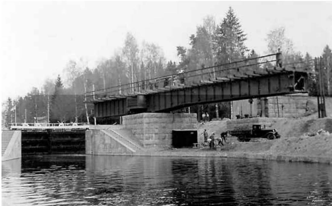
Kuva 2. Rautatiesillan rakentaminen Taipaleen kanavan yli vuonna 1935.
