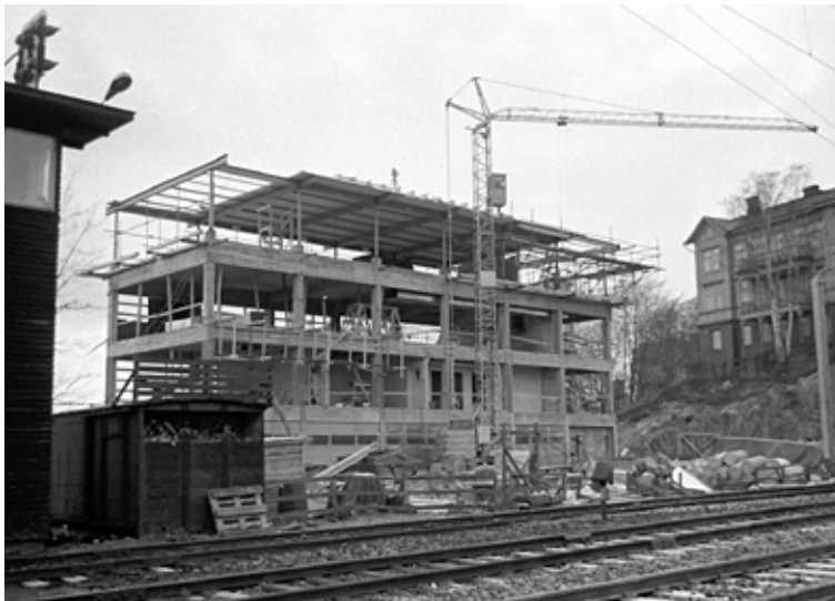
Kuva 2. Asetinlaiterakennus rakenteilla 1973. (Tapio Keränen)
