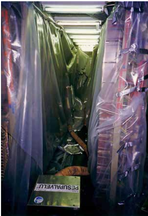
Kuva 9. Vuoden 1992 tulipalon jälkeisiä suojauksia relehuoneessa. (VR)
