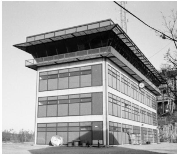
Kuva 3. Valmis rakennus keväällä 1975. Asetinlaitteen asennustyöt ovat käynnissä. (Tapio Keränen)
