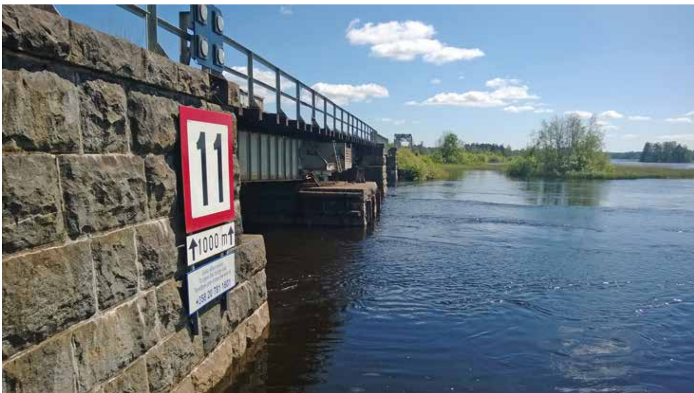
Kuva 5. Silta on hyvässä kunnossa tällä hetkellä.
