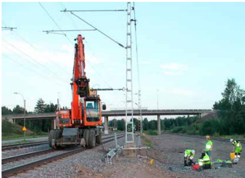
Kuva 2. Sähköratapylväsperustuksen koekuormitus käynnissä Inkeröissä. (Kuva: Terran kuva-arkisto)
