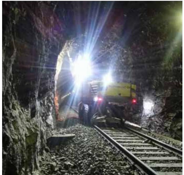
Tunnelin kalliointojen konerusnausta kiskopyöräkaivinkoneella.
