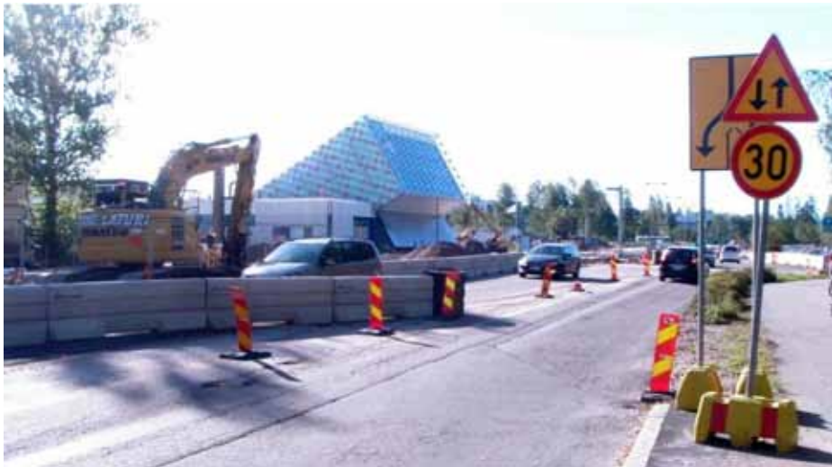
Kuva 2. Voisiko digitaalisuus lisätä turvallisuutta ja sujuvuutta työmaalla? (Kuva Janne Wuorenuuri)
