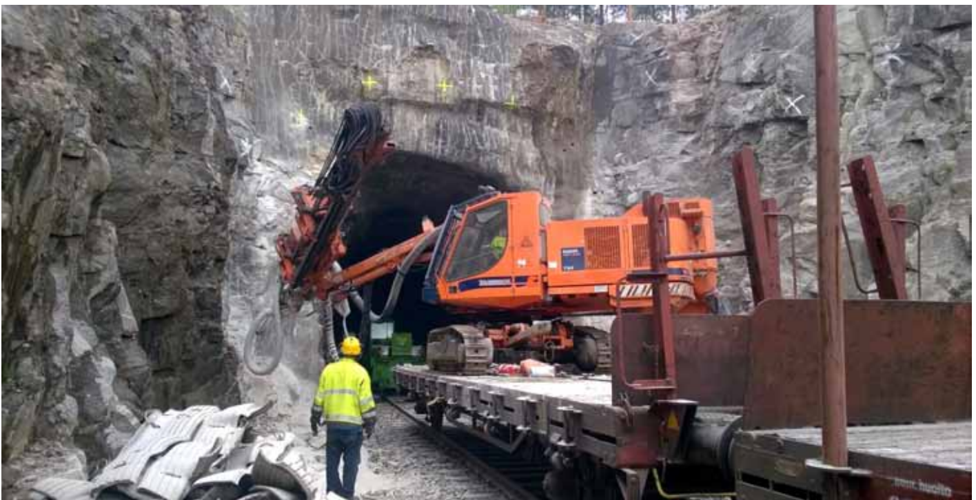
Kallion injektointireikien porausta Kangasvuoren eteläisellä suuaukolla.
