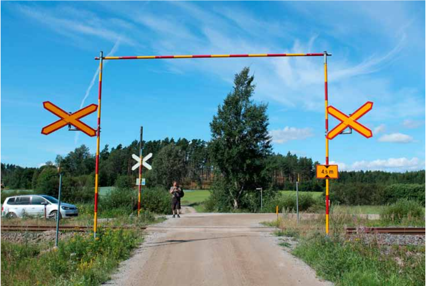
Tasoristeysten havaittavuutta on paikoitellen parannettu portaalirakenteilla. Kuva Kalle Renfeldt
