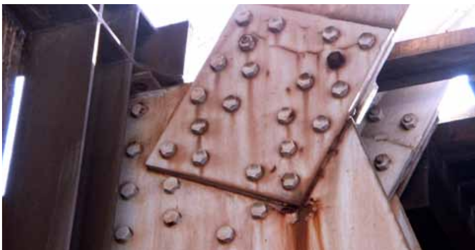
Kuva 6. Siltojen ”itkevät” liitokset vaati- vat erikoisosaamista.
