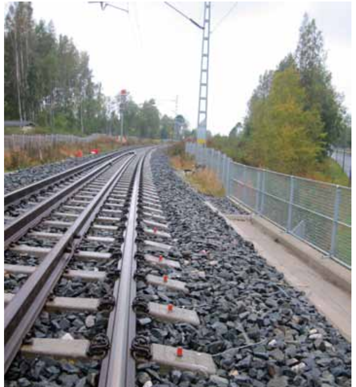
Kuva 1. Kiihtyvyyssanturit asennettuna ratapölkkyihin joustomittausta varten.
