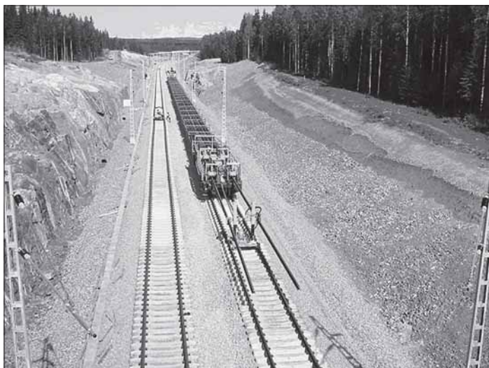
Kuva 1. Kiskotus työntömenetelmällä
