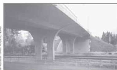
Kuivandersekan ylläpito, Äänekoski
