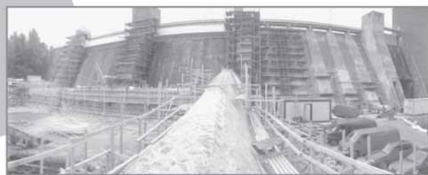
Hämeen vesivoimalaitoksen betonirakenteiden saneeraus, Hämeenlinna
