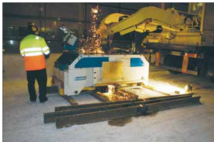
Seminaarilaisilla oli mahdollisuus tutustua leimuhitsaukseen illan pimetessä.
