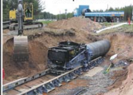
Työntöporausta American Augers 72-1200NG koneella, DN1600 asennus.
