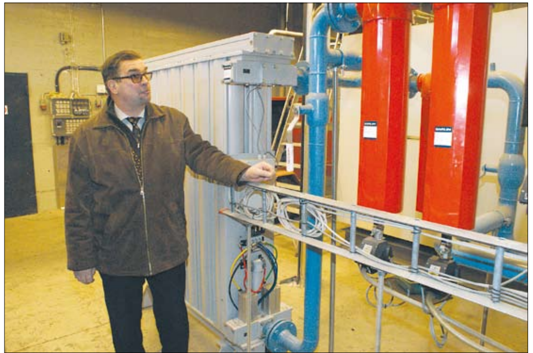
Reijo Raja-aho selvittää, kuinka märkä, paineistettu ilma tulee ensimmäiseen säiliöön, josta se suodatuksen kautta etenee kuivaukseen. Toisen suodatuksen kautta se siirtyy seuraavaan säiliöön josta se edelleen lähtee verkostoon.
