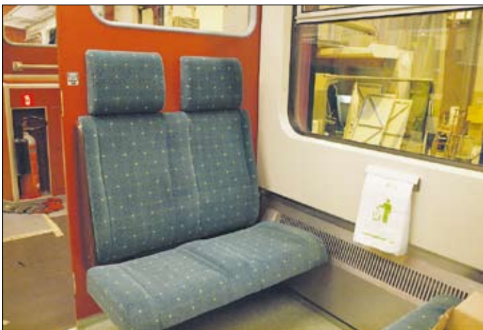
Kuvissa Eil-vaunujen uutta väri-ilmettä. Sisäkuva on otettu peruskorjauksen loppuvaiheessa. Siksi suojapaperit ovat vielä lattialla.
