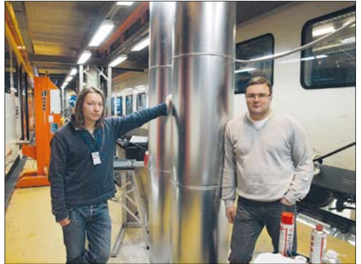
Verstpäällikkö Toni Harju (oik.) ja sähkötyönjohtaja Tomi Löf ovat hyvin tyytyväisiä sulatusjärjestelmän tuloksiin.
