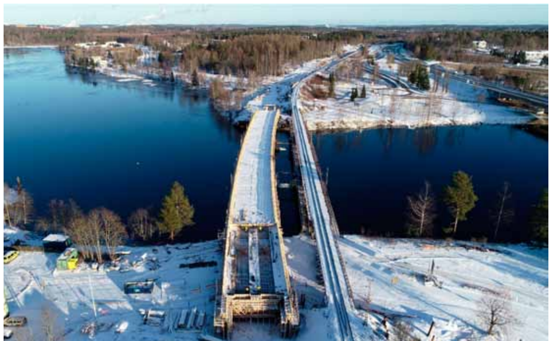
Mansikkakosken ratasillan työmaa. Kuva Visa Korhonen, Welado Oy
