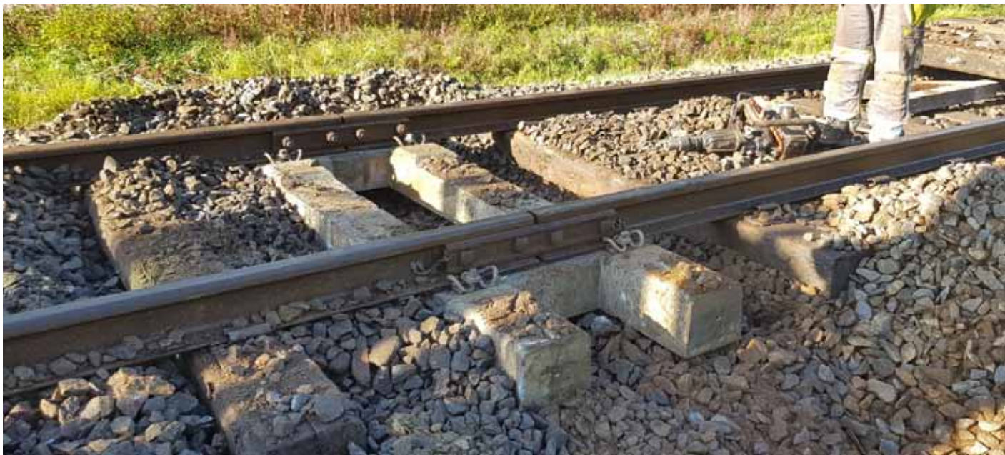
Kuva 2 Kehäpölkkyntuennusta Pori-Mäntyluoto-rataosalla syksyllä 2019
