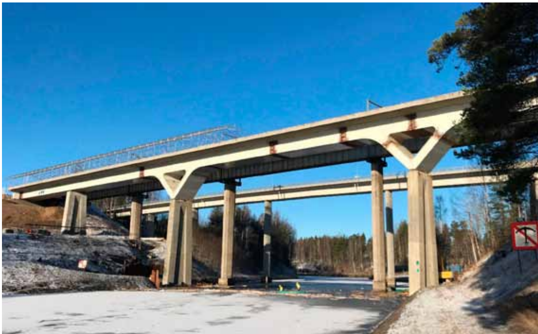
Saimaan kanavan ratasil- tatyömaa aurinkoisessa talvisäässä (20.2.2020). Kuva Joonas Hämäläinen, Väylä
