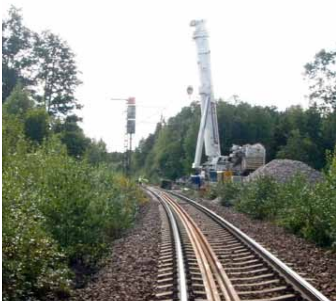
Kuva 4. Vanhan ratasillan purku alkamassa vuonna 2013.
