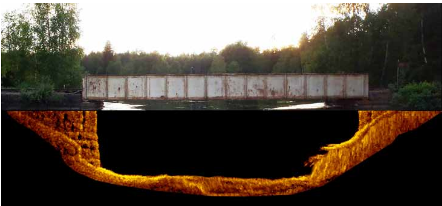
Kuva 3. Osolankosken ratasillan kaikuluotauskuva (VRT Finland Oy, Sillan erikoistarkastusraportti 2012)
