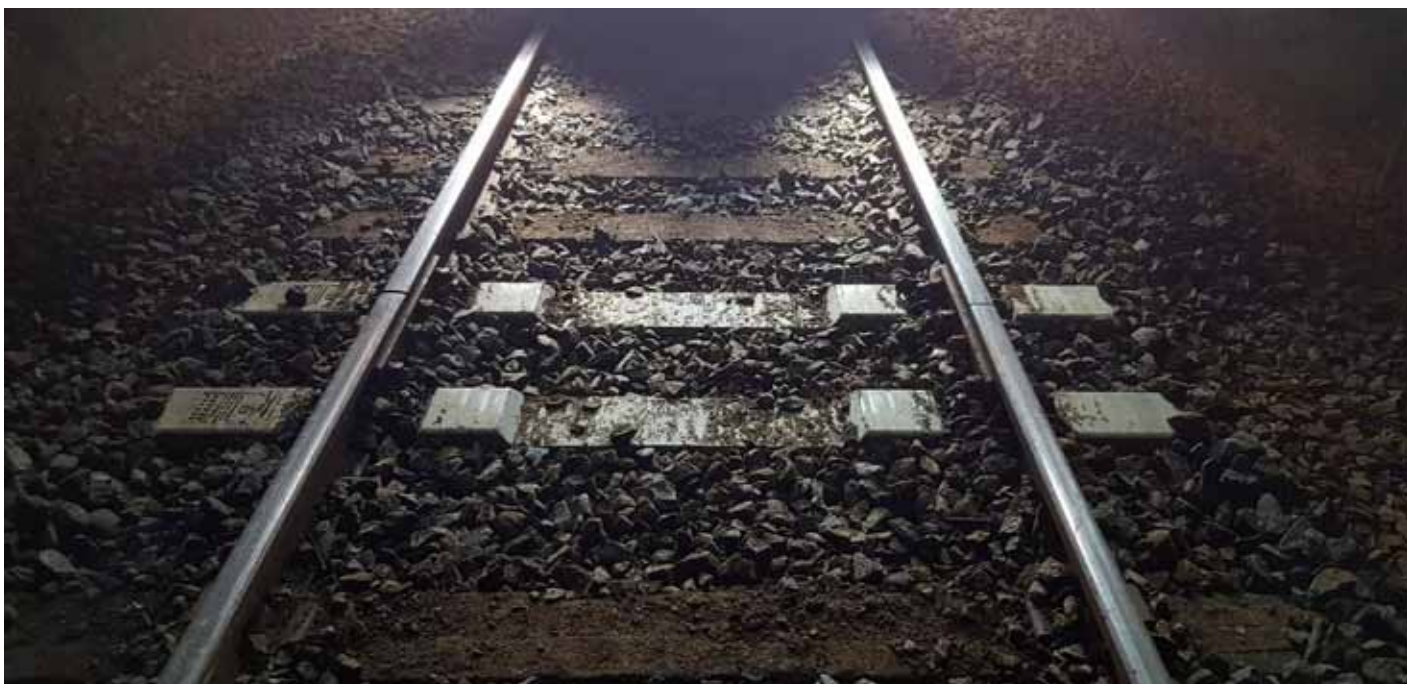
Kuva 3 Tuettu kehäpölkky Pori-Mäntyluoto -rataosalla
