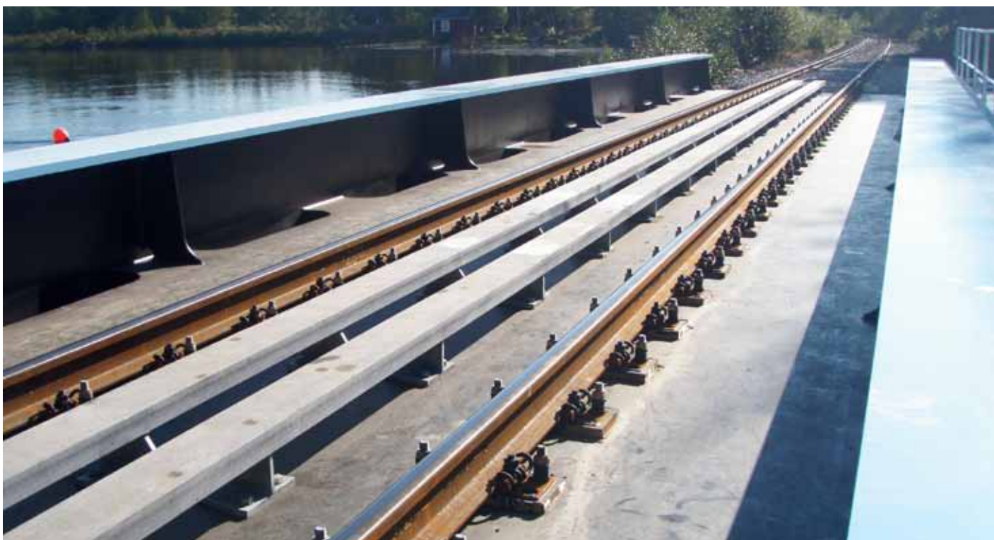
Kuva 5. Uudessa sillassa kiskot ovat kiinni teräsrakenteessa.
