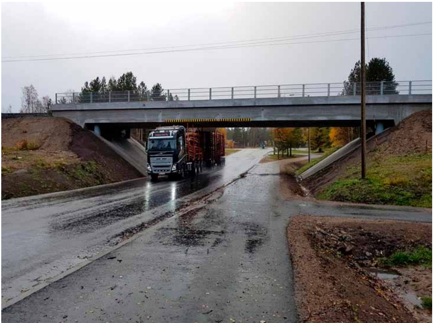
Uudelleen valettu ja liikenteelle otettu Kostamontien alikulkusilta. Kuva: Juhan Tyrväinen.
