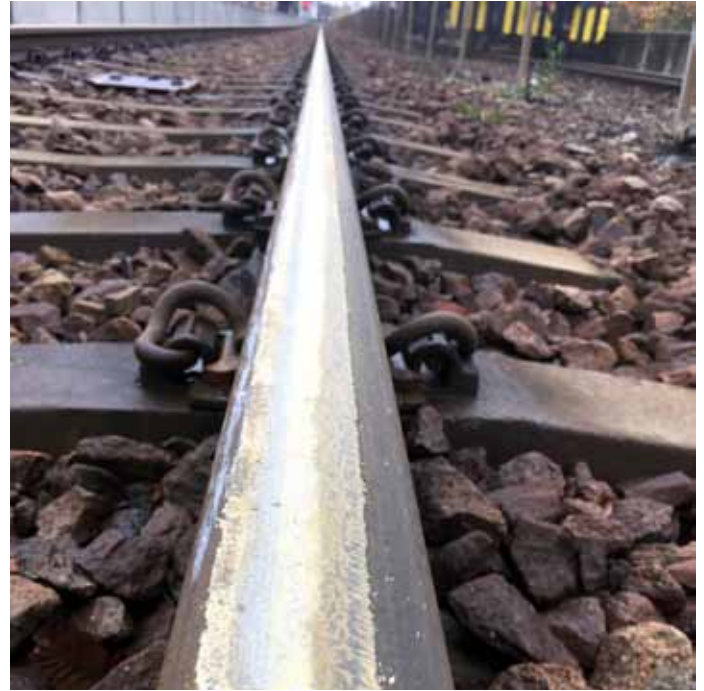
Kiskon kulkupinnalle levitettyä kitkageeliä. Kuva VR Track Sweden.
