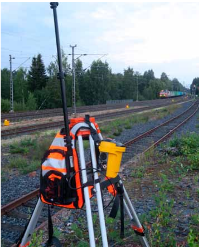
Juna ohittamassa työmaan Järvelässä. Kuva: Teijo Saalasti.
