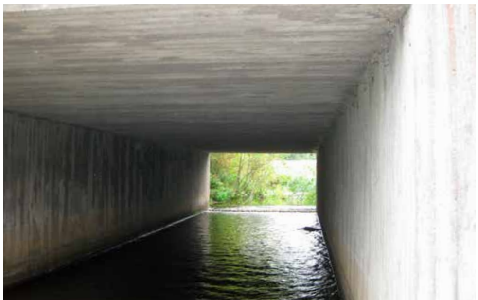
Kuva 3. Aukkomitta on pienentynyt alkuperäisestä sillasta.
