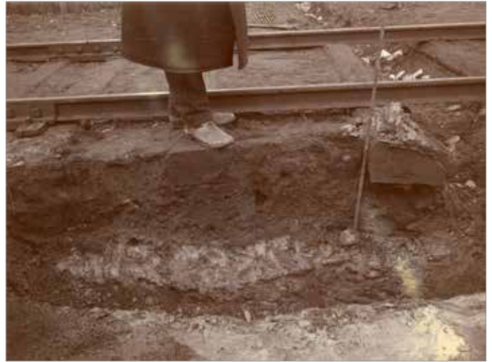
Ratapenger on kaivettu routapaikassa auki ja raiteen alla näkyy tanakka savikerros. Valitettavasti tämän valokuvan kuvausaika ja -paikka eivät ole tiedossa.
