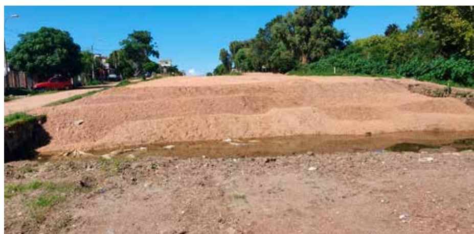
Kuva 3. Ratapengertä valmistumassa ennen radan päällysrakennetta
