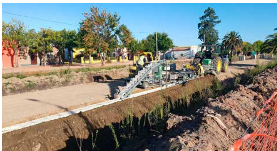
Kuva 11. Kaapelikanavan asennusta.
