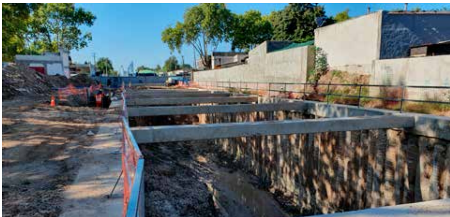
Kuva 8. Kaupungin keskelle rakennetaan kaksi ratakuilua, jolla päästään eroon useista tasoristeyksistä.
