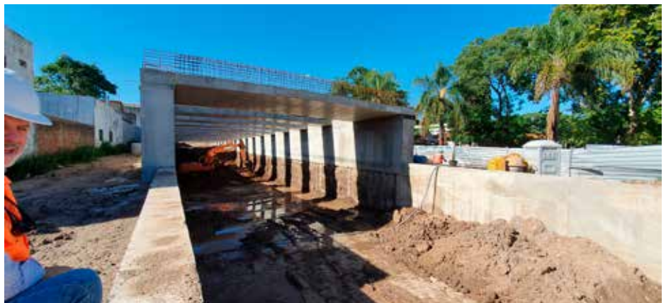
Kuva 8. Kaupungin keskelle rakennetaan kaksi ratakuilua, jolla päästään eroon useista tasoristeyksistä.
