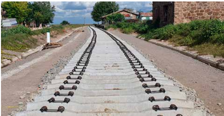
Kuva 10. La Cruzin asemalla/seisakkeella ratapälkkyt odottaa kiskoja.
