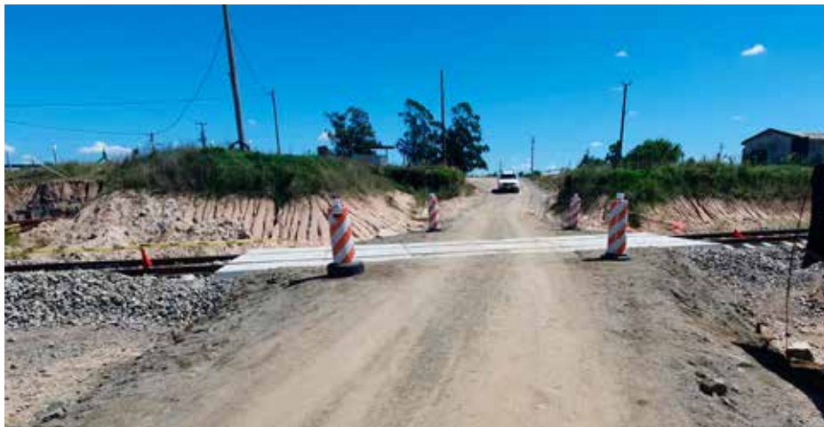
Kuva 2. Ensimmäiset tasoristeyskannet on asennettu.
