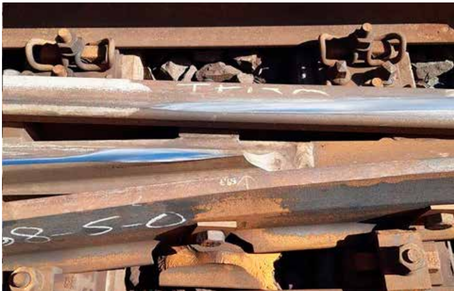
Kuva 2. Vaihteen V461 vastakiskorakenteen murtuma huhtikuulta 2020. Kuva: Olli Outinen
