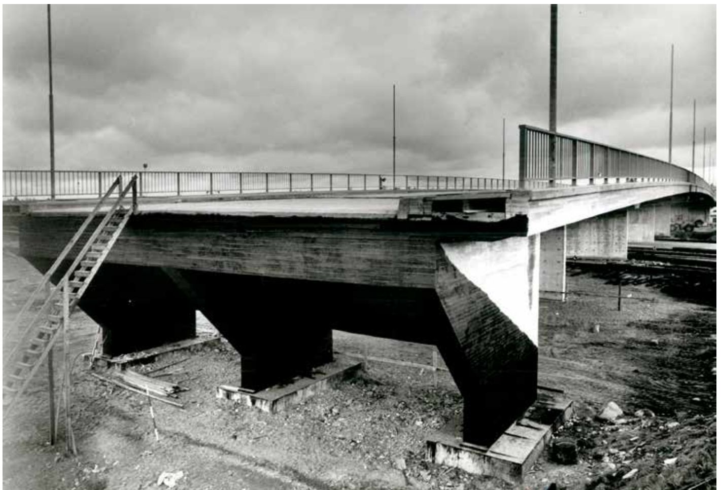
Kuva 2. Pieksämäen uusiin ylikulkusilta rakentuu muuttuvan ratapihan yli vuonna 1970 (Kuva Sweco Infra & Rail Oy, arkisto).
