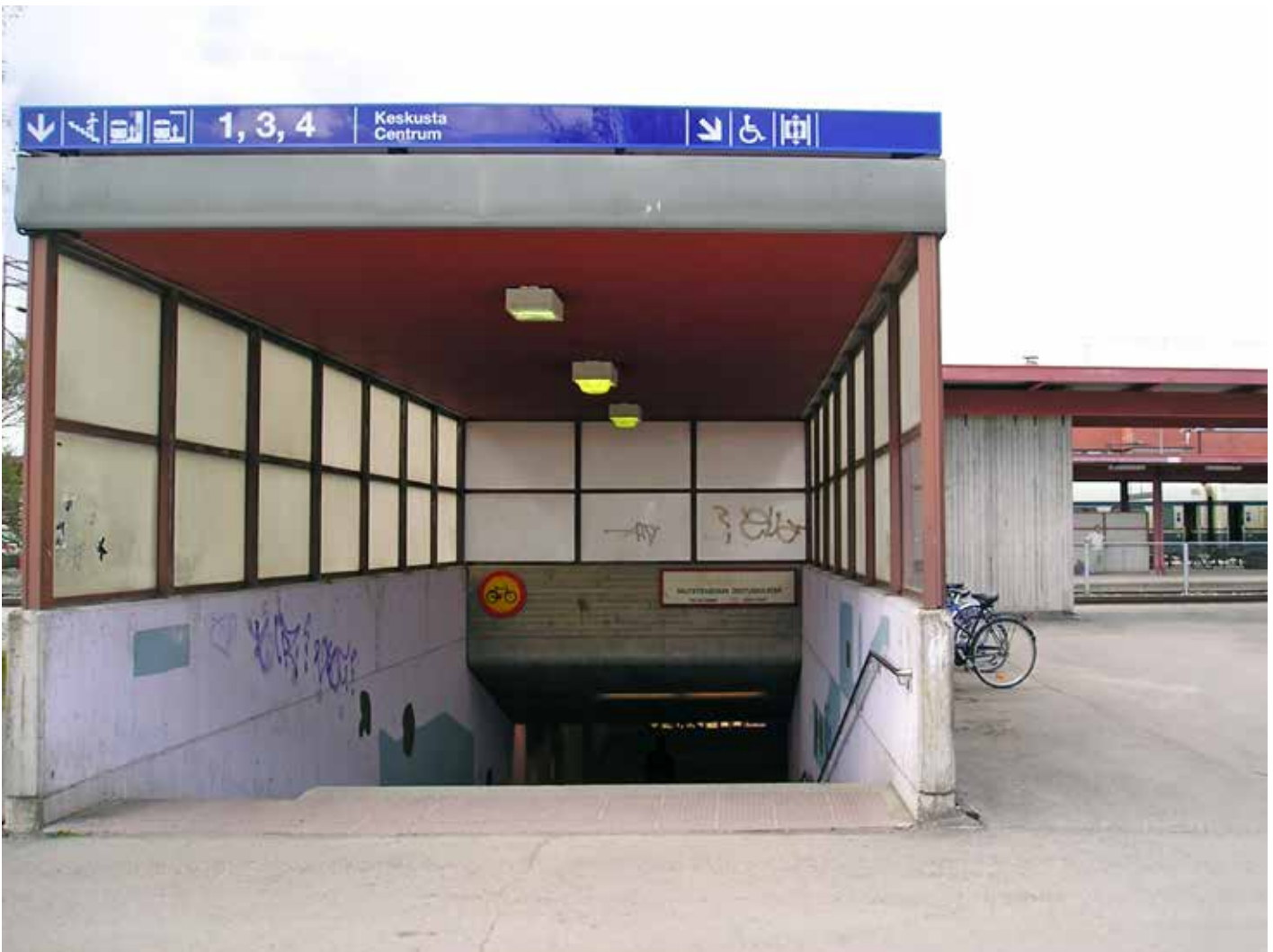
Kuva 4. Asematunnelin porraskäytävä harkitaan uusittavan luiskiksi. Kuva: Janne Wuorenuuri
