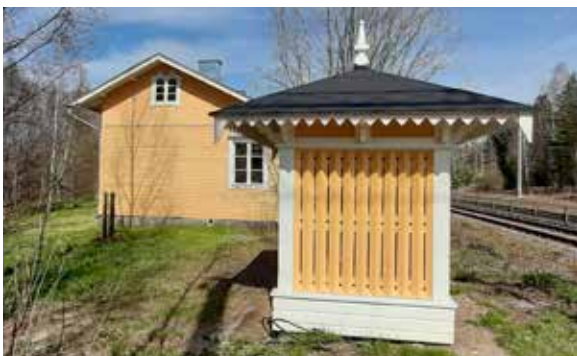
Hikiän vanhalla piirustuksella rakennettu kaivo
