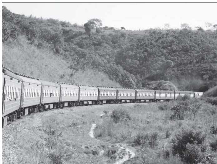
Vaunuista katkaistiin sähköt päivän ajaksi, joten tunneleiden kohdalla hyttiin lankesi säkkipimeys.
