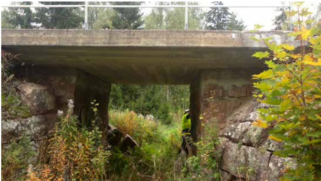
Kuva 4. Ali-Vekkosken alikulkusillan kansi on vaihdettu vuonna 1975.
