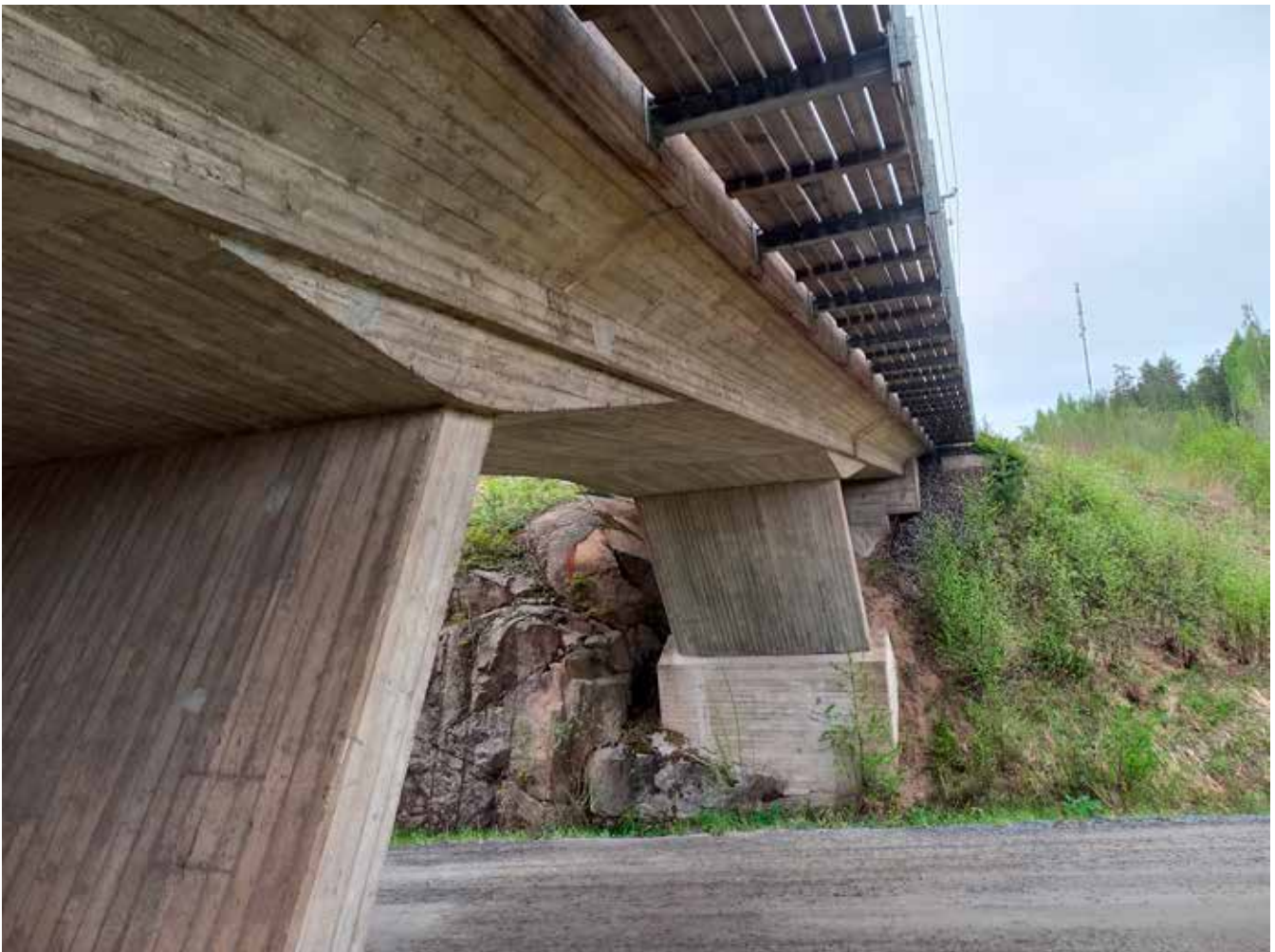
Kuva 1. Rajakankaan alikulkusillassa ympäristösuunnittelu on osana korjaussuunnittelua
