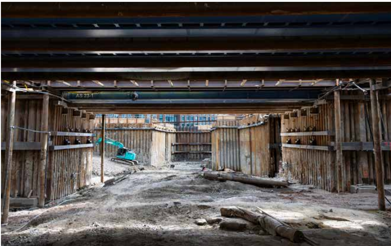
Raitiotietunnelin työmaata pääradan alla Tikkurilan aseman kohdalla 5.8.2026. Kuva: Jussi Laukkanen, Vantaan kaupunki.
