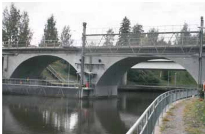
Kanavan turvallisuusvälpät, jotka poistettiin vuonna 2011.
