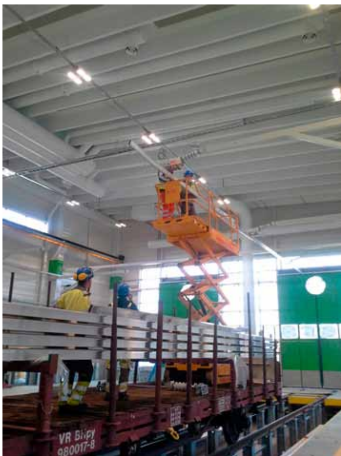
Kiintoajojohtimen asennus junahallissa.
