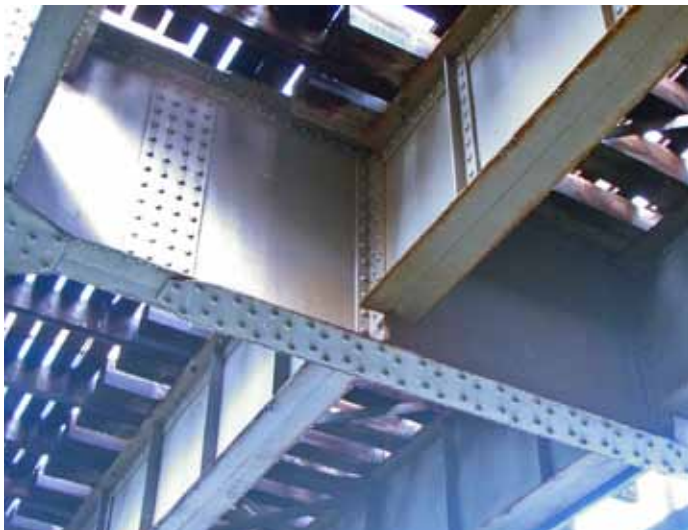
Kuva 4. Kiskojen alla olevat pituuskannattimet ovat toistaiseksi kunnossa.
