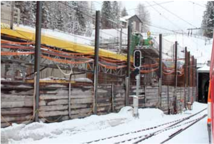
Albula II-tunnelin rakennustyömaa Predassa. Juna sukeltaa juuri vanhaan tunneliin. Kuva Markku Nummelin
