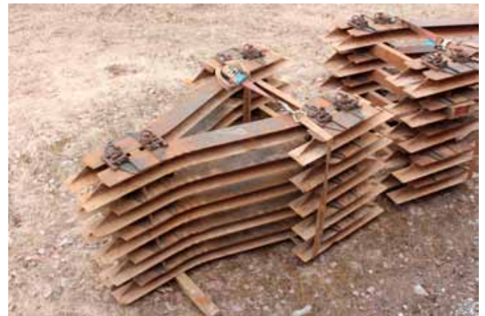
Y-pölkkyjä odottaa rataa laittoon MGB:llä. Kuva Markku Nummelin
