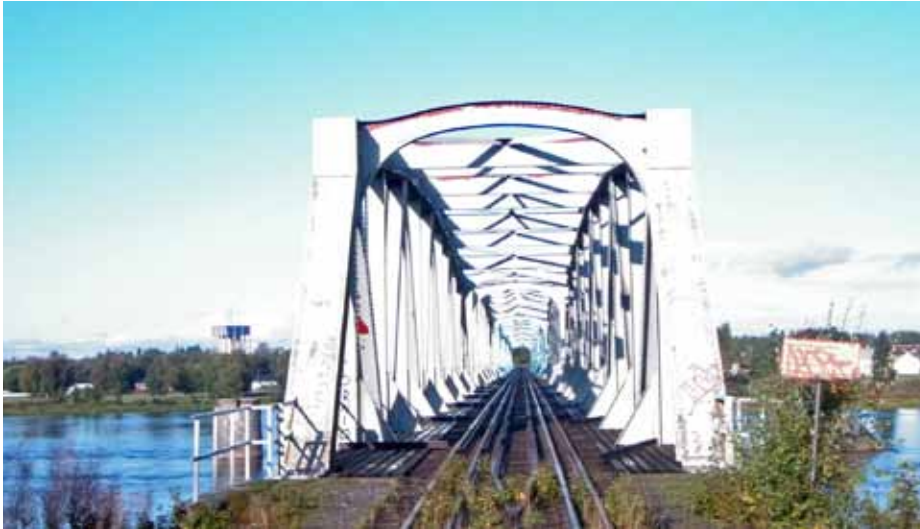
Kuva 2. Sillalla on sekä Suomen että Ruotsin raiteet suojakiskojen lisäksi.
