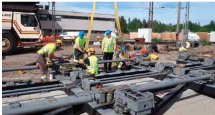
Käyttötankojen asennus
