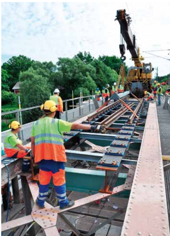
Paimion ratasillan korjaus.
