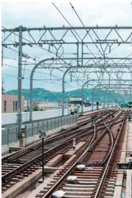
Modernia kiintoraidetta vaihteineen Keihan-yksityisrautatiellä Kioton ja Osakan välillä.
