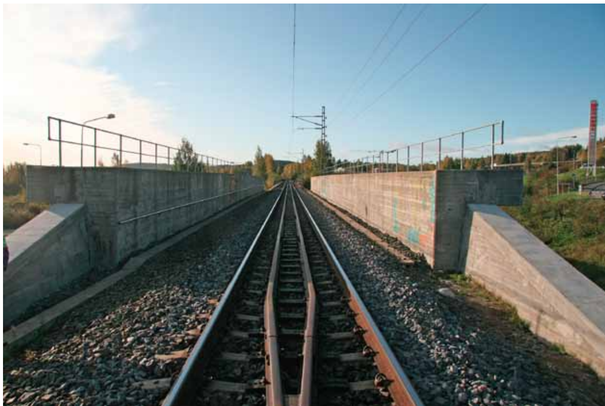
Kaukalopalkkisilta on tyypillinen rautateille tarkoitettu siltatyyppe, jonka suunnittelussa yhdistyy silta-, geo-, ja ratatekniikka työtapasuunnitelmiseen.
