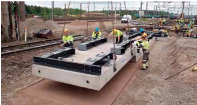
Jarrun perustuselementin asennus
