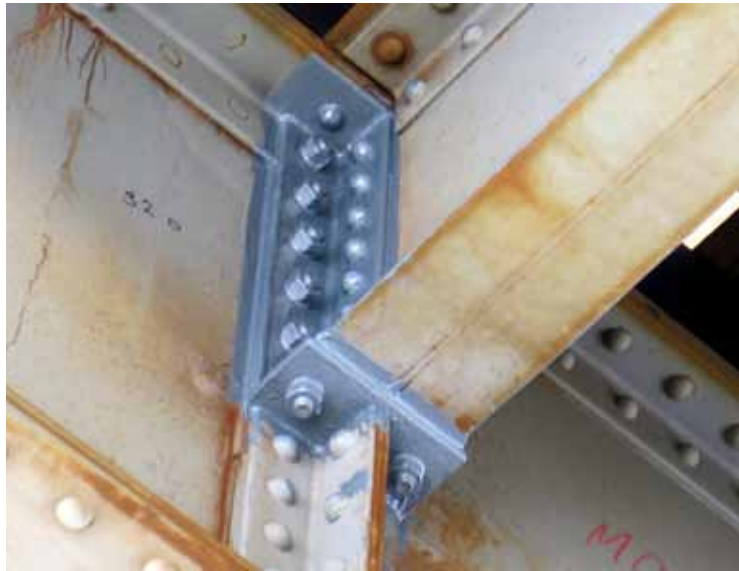
Kuva 7. Rikkinäiset liitokset raiteen alla vahvistettiin uusimilla niitit.
