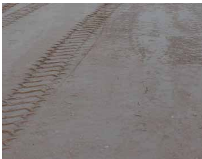
Kuva 3. Heikosti tiivistyvistä materiaalista rakennetun kerroksen pinta jää löyhäksi ja työkoneiden tai ajoneuvojen jäljet näkyvät pinnalla selkeästi (vasen kuva). Hyvin tiivistyvistä materiaalista rakennetun kerroksen pinta on kova ja kiinteä (oikea kuva).
