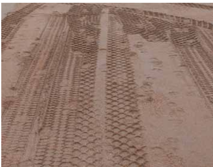
Kuva 3. Heikosti tiivistyvistä materiaalista rakennetun kerroksen pinta jää löyhäksi ja työkoneiden tai ajoneuvojen jäljet näkyvät pinnalla selkeästi (vasen kuva). Hyvin tiivistyvistä materiaalista rakennetun kerroksen pinta on kova ja kiinteä (oikea kuva).
