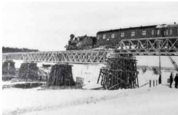
Kuva 5. Väliaikainen silta koekuormituksessa (Kuva Valtion Rautatiet 1937–1962 -kirja).
