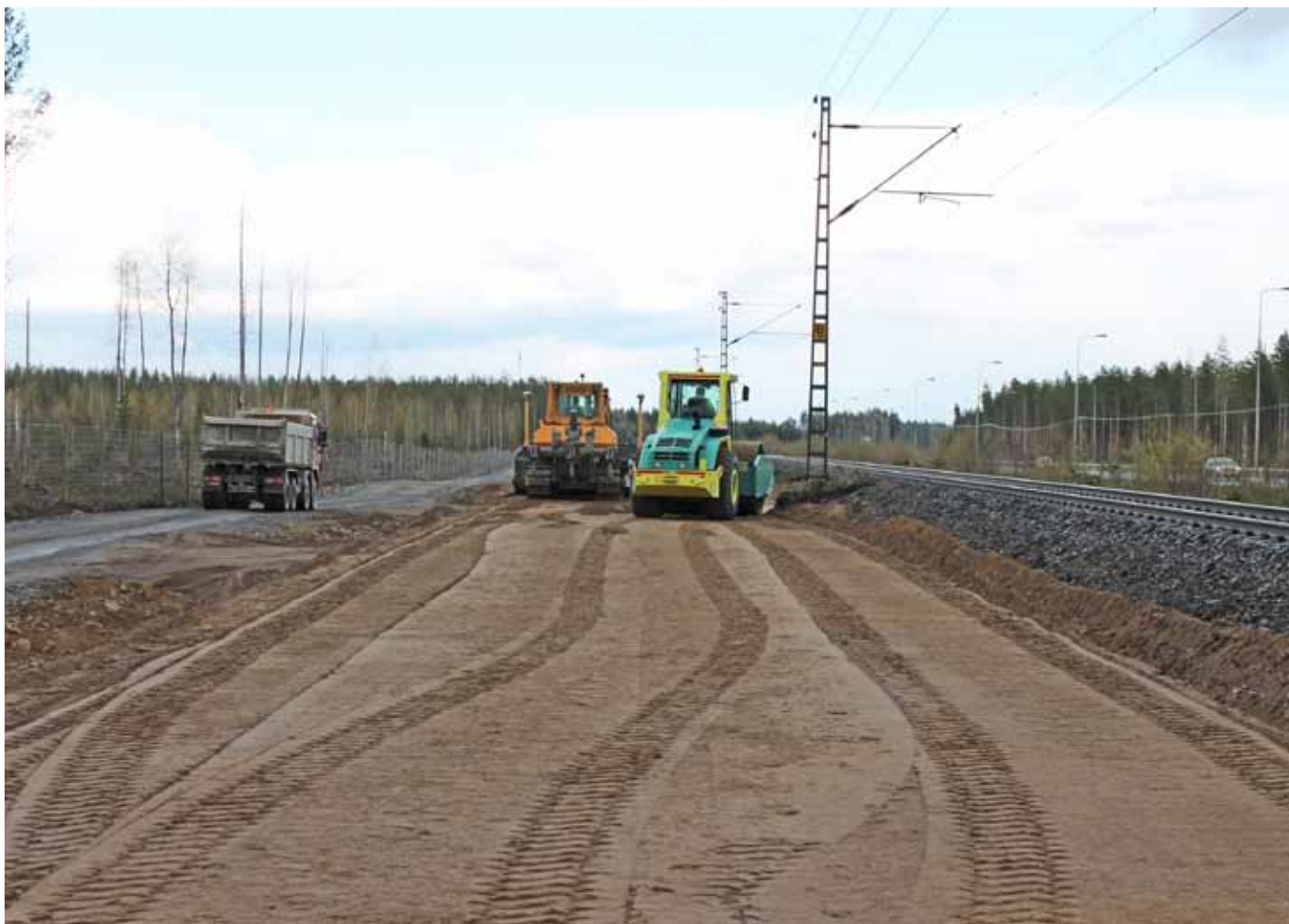
Kuva 4. Eristyskerroksen rakentaminen käynnissä LuIma-hankkeella.
