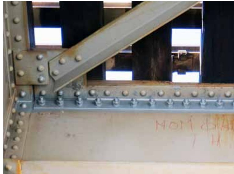
Kuva 8. Raiteen alla olevia laippoja vahvistettiin osin vuonna 2013.
