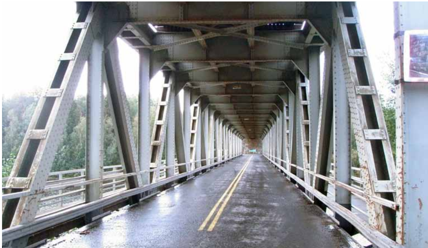
Kuva 2. Maantiekansi rautatien alla.
