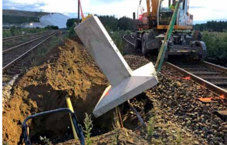
Pylväsperustuksen asennusta Siilinjärvi–Ruokosuo rataosalla. Kuva Pekka Pulli
