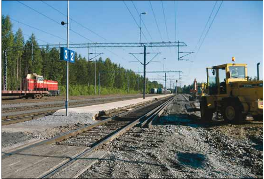
Jämsän ratapihahremontti on osa Jyväskylänradan perusparannustyötä. Ratatöistä vastaa Ratahallintokeskus.
