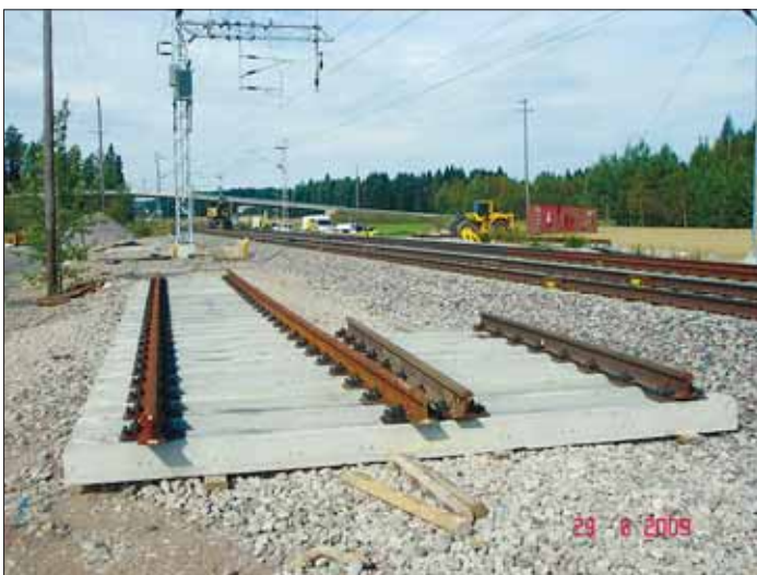
1:18 vaihteen takajatkos koottuna radan sivussa Iitin Saunamäessä la 29.8.2009.
