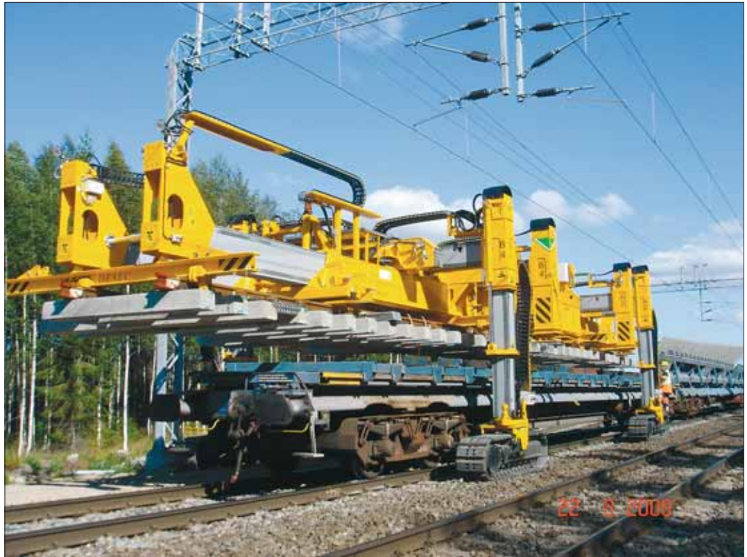
TL -70 nostaa 1:18 vaihteen kielelementtiä vaihteenkuljetusvaunusta.
