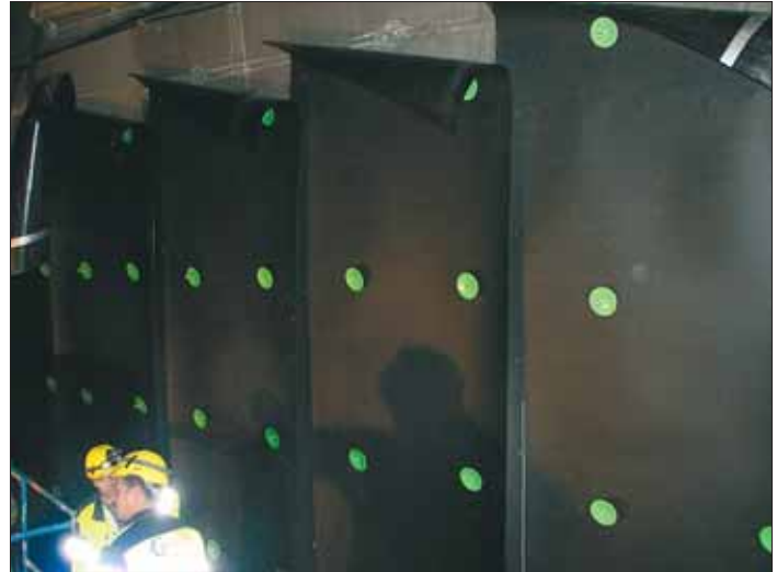
Asennetut membraanikaistat ennen aluslevyjen kiristämistä ja saumojen hitsausta.
