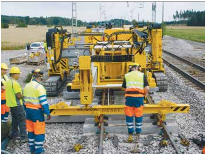
Risto Englund passaa 1:18 vaihteen kielelementtiä paikalleen Iitin Saunamäessä la 29.8.2009.
