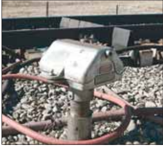
Kuva 3. Pyörrien lämpötila-ilmaisin, Kanada
