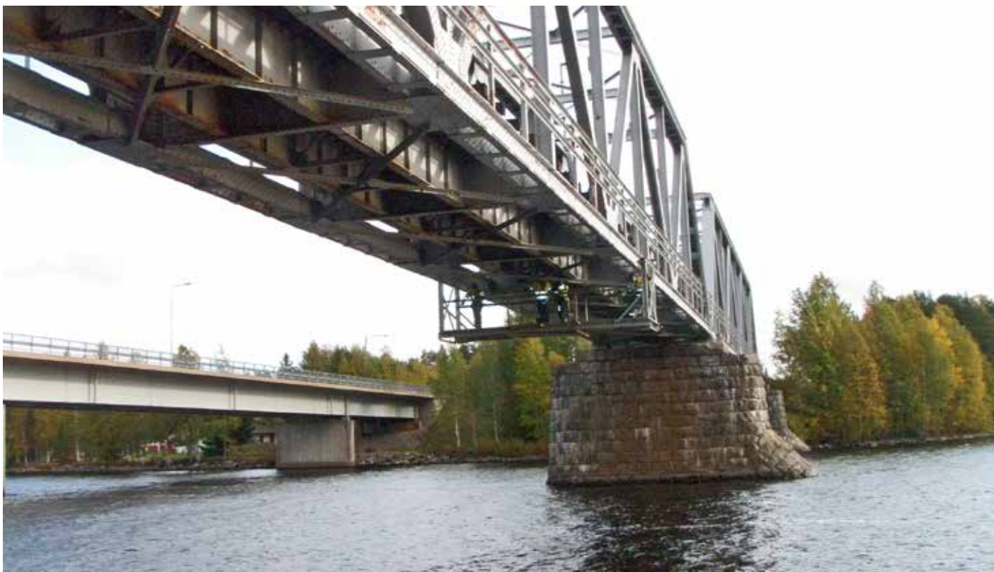
Kuva 4. Sillan huoltokori kunnostettiin tarkastuksia varten.
