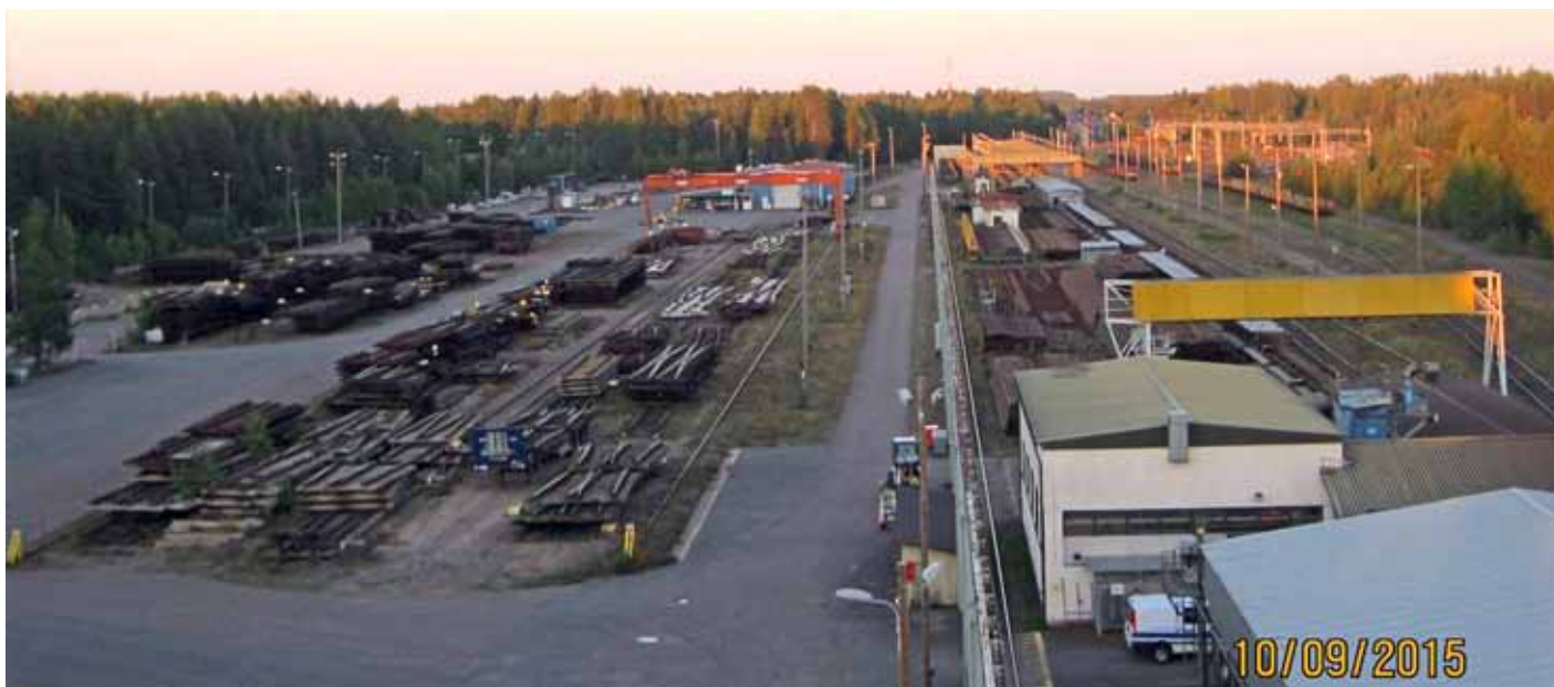
Kuva 2. Näkymä Vossloh Rail Services Finlandin isosta nosturista Kaipiaisissa: Vasemmalla Vossloh Cogiferin tuotantotilat ja purettavia kierrätysvaihte-elementtejä, oikealla kiskohitsaamon tuotantolinjaa ja linjan päässä valmisvarasto.
