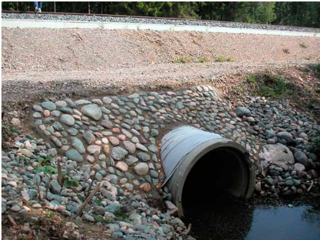
Kuva 4. Rummun pään viimeistely parantaa veden virtausta rumpuun.
