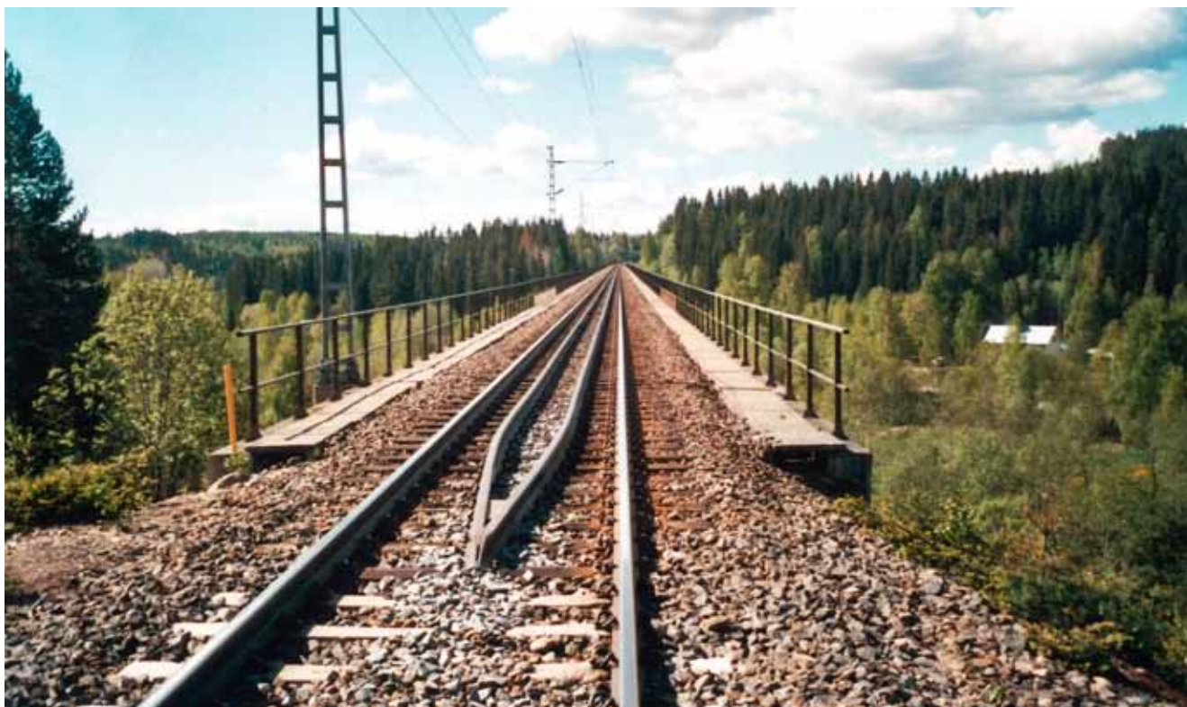
Kuva 3. Pitkä silta ylittää maaston korkealla .
