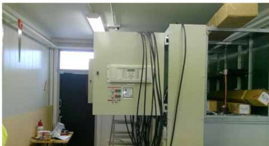
Kuva 10 ja 11. Ylivieskan 25kV:n kojeisto- ja suojareleasennuksia.
