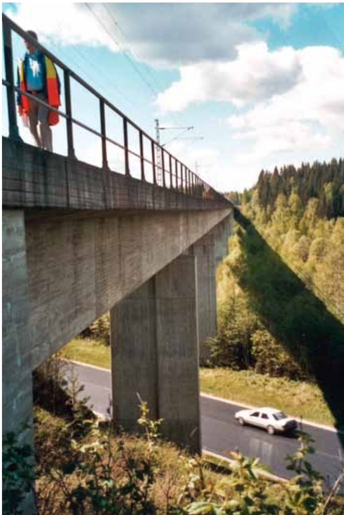
Kuva 2. Valtatie 9 alittaa sillan Savipohjassa Korpilahdella.
