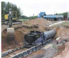
Työntöporasta American Augers 72-1200NG koneella, DN1600 asennus.
