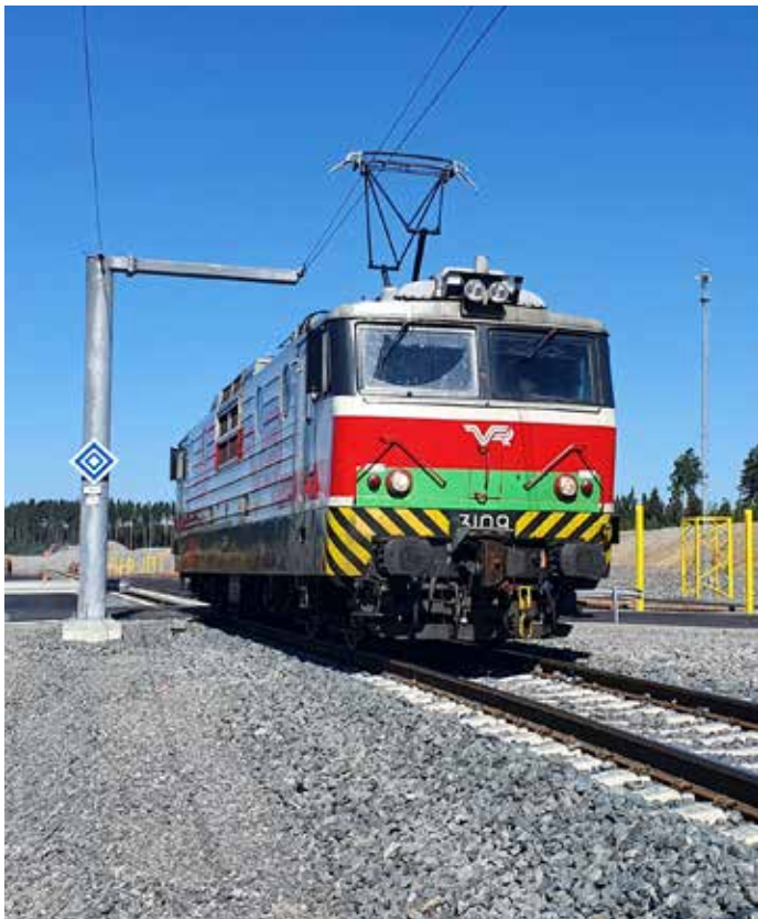
Ennen kuormaustoiminnan aloitusta sähköradan toimivuus varmistettiin koeajolla.
