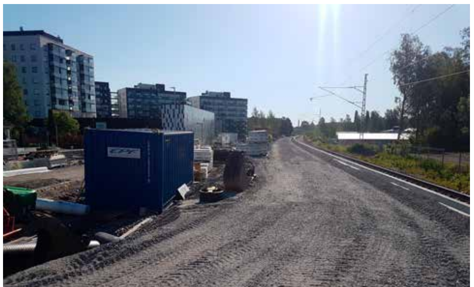
Laiturielementit asennettiin kevään ja alkukesän aikana. Kuva Antti Uotila.
