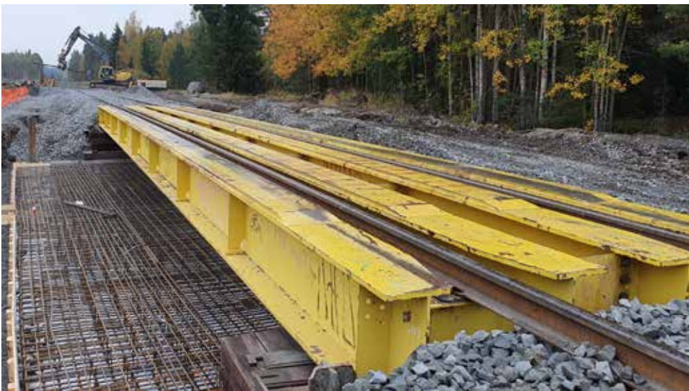
Apusiltaa hyödynnettiin paalulaatan rakentamisessa
