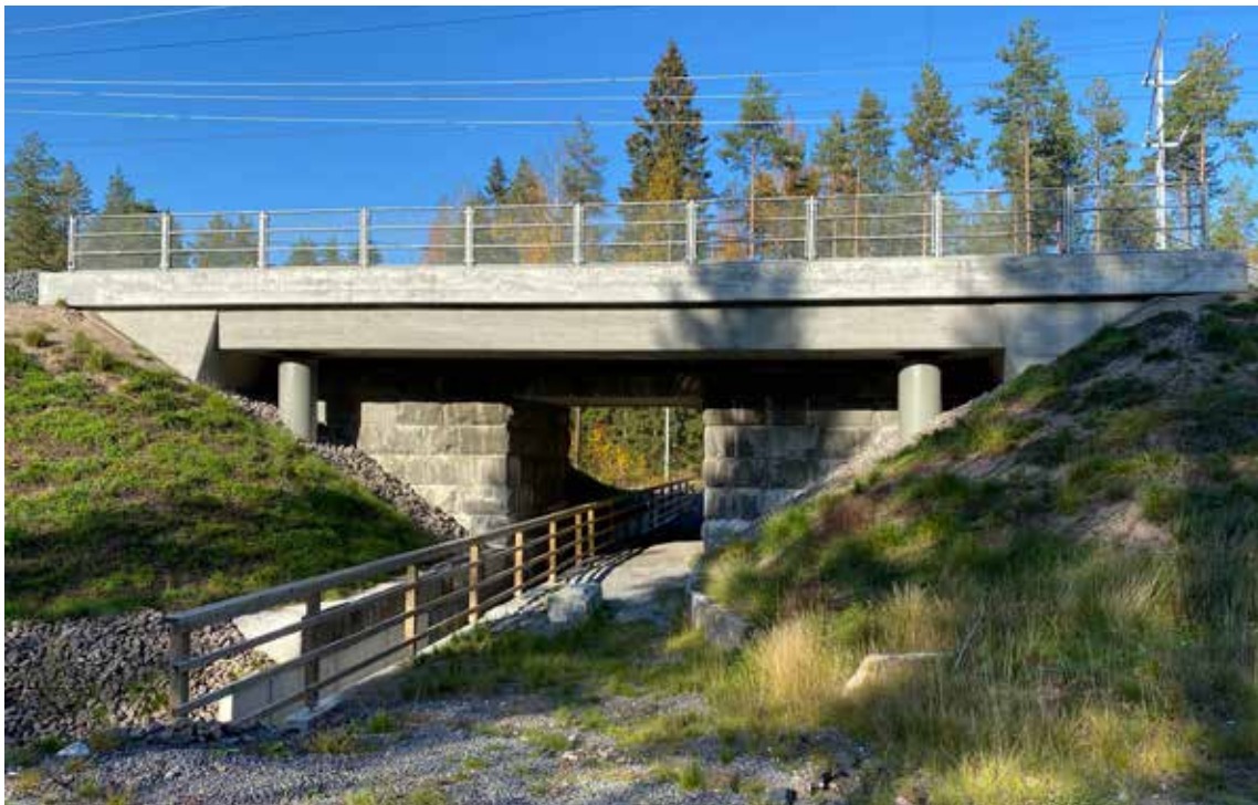
Maantiealikäytävän (Karjasilta) vanhan sillan historialliset kiviset maatukirakenteet ovat selvästi nähtävissä uuden rakenteen alta.
