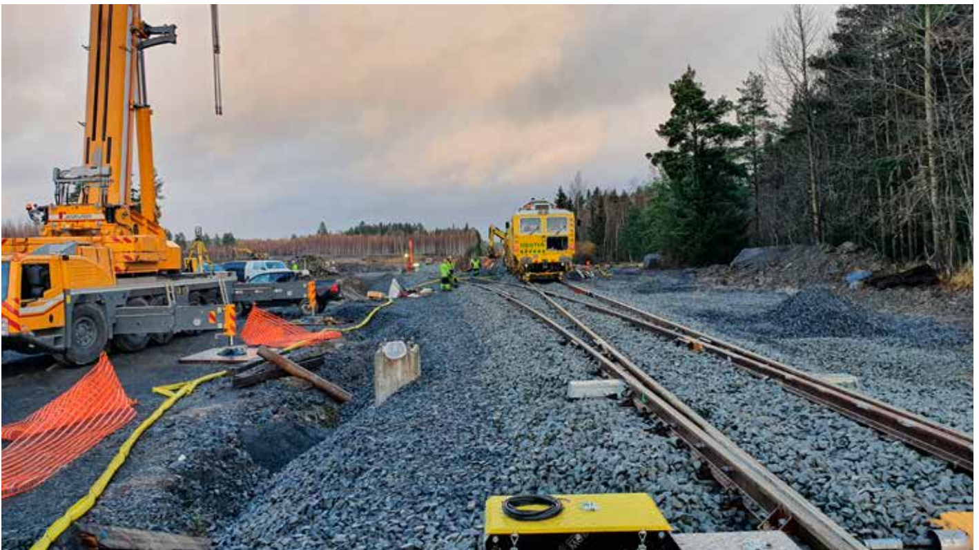
Toijala - Valkeakoski radalta erka-neva vaihde asennettiin paalulaatan päälle.
