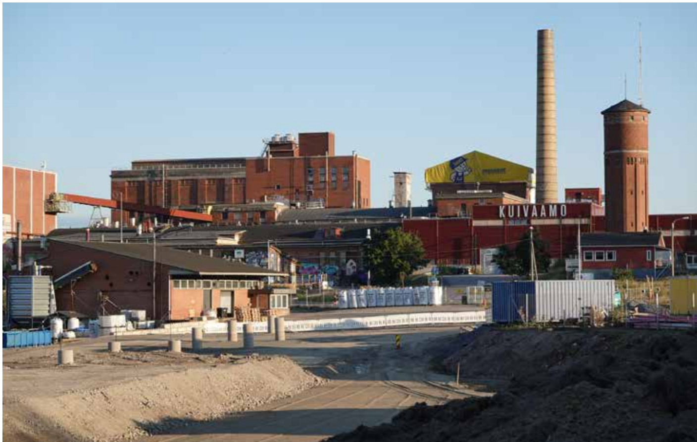
Raitiotien 2B-osuudelle rakennettiin painopenger tulevan raitiotielinjauksen kohdalle ennakkoon. Raitiotie tulee kulkemaan purettavan Kuivaamo-rakennuksen kohdalta vanhan tehdasalueen läpi. Kuva: Jukka Heinonen Raitiotieallianssi
