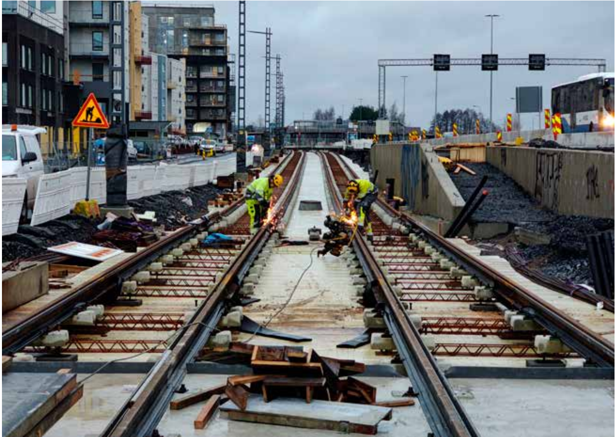
Rantatiellä vuoden aikana on tehty jo huomattavat osuudet raitiotien päällysrakennetta. Kuva: Antti Kiviniemi, Raitiotieallianssi.
