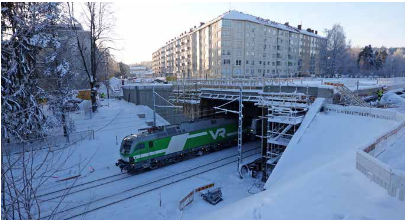
Sepänekadun uusi silta on yli kaksi kertaa leveämpi kuin vanha. Sillassa myös hyödynnetään poikkeuksellista rakennetta. Rautatie kulkee sillan ali, raitiotie ja katu sillan päältä. Kuva: Jukka Heinonen, Raitiotieallianssi.
