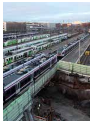
Helsingin Kaisantunnelin rakennustyömaata. Kuva Markku Nummelin, 24.11.2021
