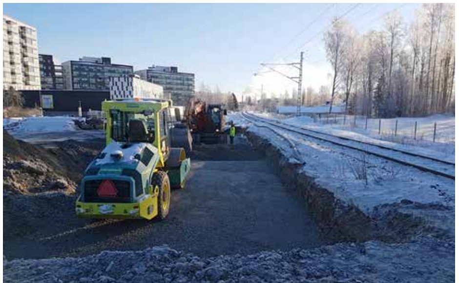
Rakennustöitä tehtiin myös talvella. Kuva Antti Uotila.
