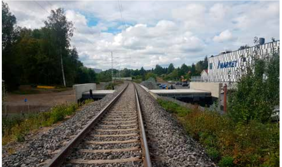
Valmis Vanamon alikäytävä ja tilanne ennen seisakkeen rakennustöiden aloittamista. Kuva Antti Uotila.
