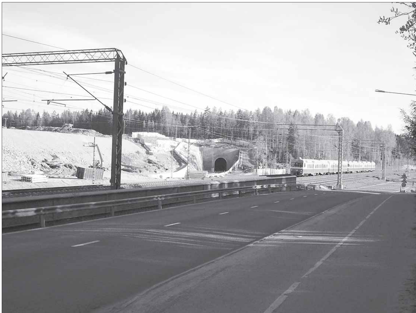
Vuosaaren rata Savion suuaukolla. Rata on lähes valmis vastaanottamaan ensimmäisen junan syksyllä 2008.
