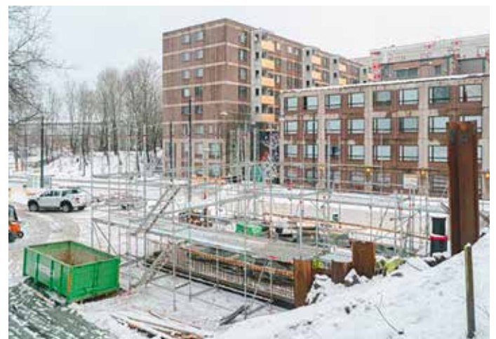
Pasilan sähkönsyöttöasema rakenteilla.
