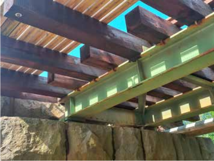
Kuva 3. Siltapalkit ovat nykyään hyvässä kunnossa.
