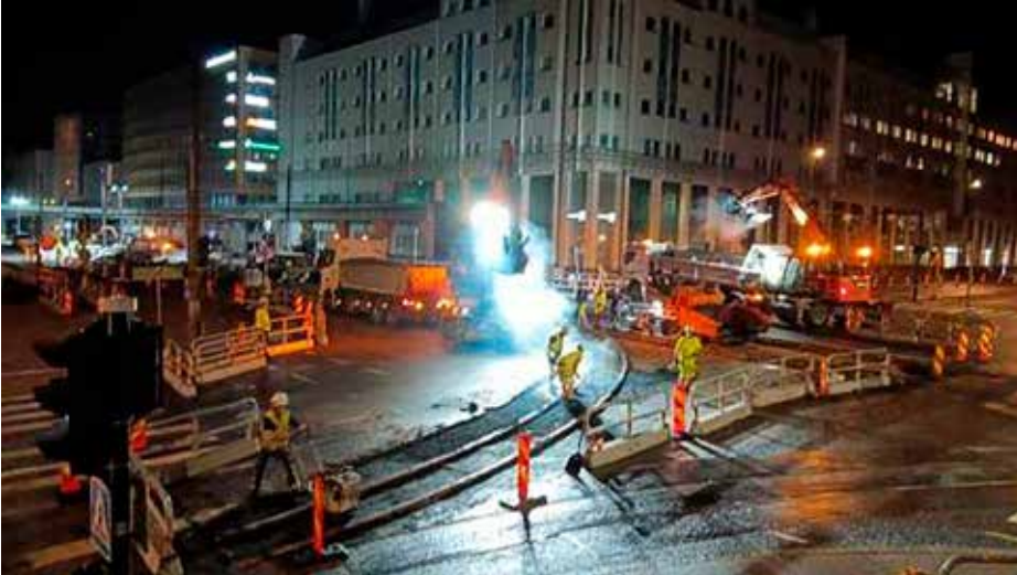
Ratapihantien kiskotustöitä tehtiin yöaikaan.
