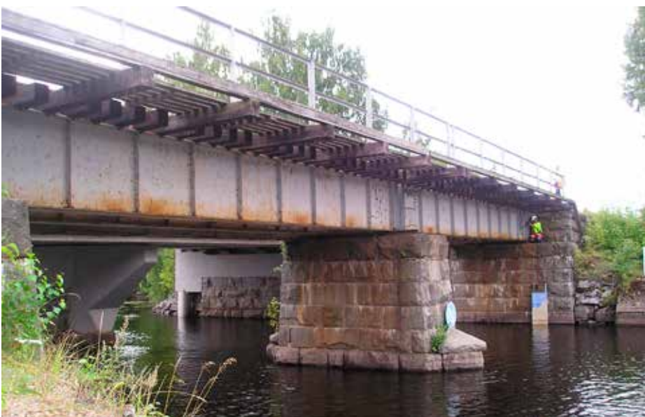
Kuva 2. Mäntän radan merkittävin silta on Virtasalmen ratasilta.
