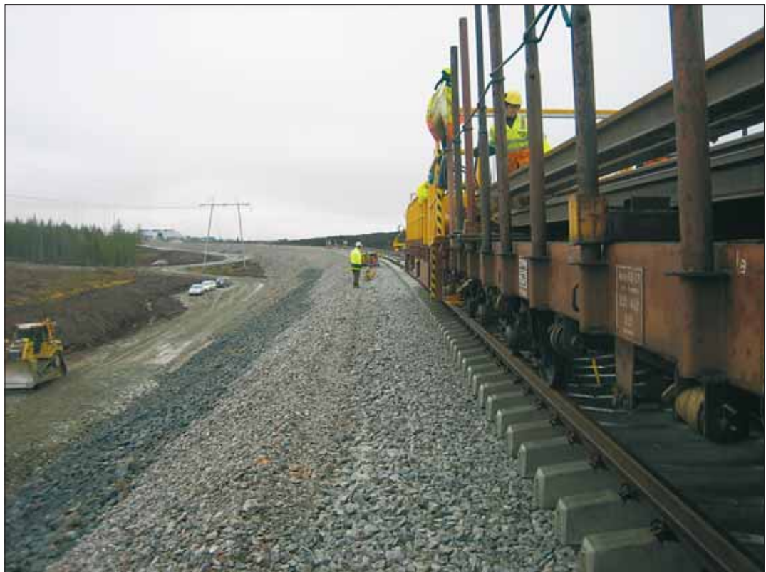
Kiskotustyö käynnissä Talvivaaran tulokaarella, kuva 14.10.2008.
