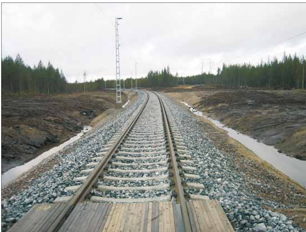
Lintusuon tasoristeys, radan päällysrakenne valmis, kuva 21.10.2008.
