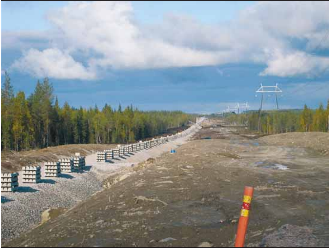
Ratapölkkyt jaettu ratalinjalle PI12000, kuva 11.9.2008.
