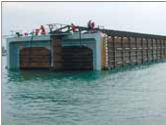
Marmaray-projektissa rakennetaan maailman syvimmälle upotettava koottava rautatie-tunneli.
