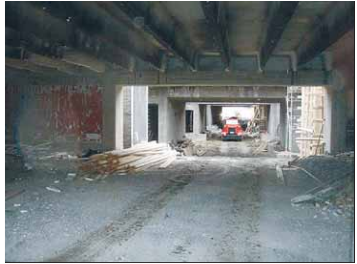
Syyskuussa 2007 oli jo valoa näkyvissä tunnelin päässä...
