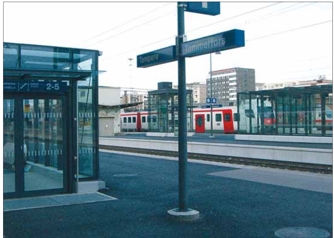
Matkustajalaitureilta pääsee nyt kulkemaan sujuvasti asemalle ja eri puolille kaupunkia hissien ja liukuportaiden ansiosta.
