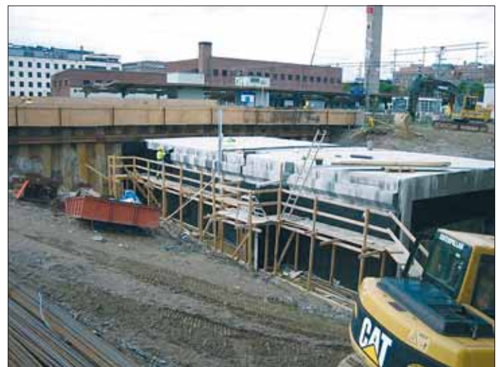
Seitsemäs betonilohko odottaa siirtämistään paikalleen.
