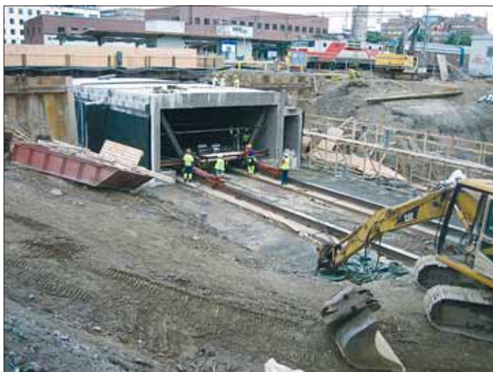
Seitsemäs betonilohko on siirretty paikalleen.
