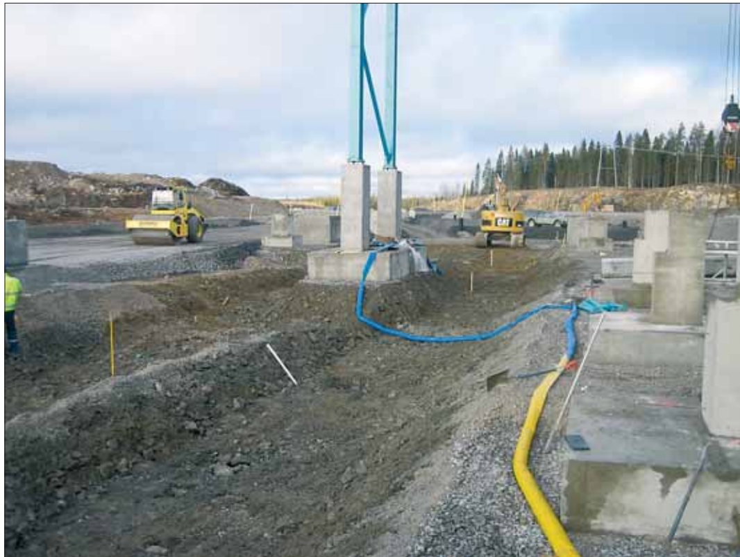
Talvivaaran ratapihan maanrakentaminen käynnissä, kuva 2.11.2008.
