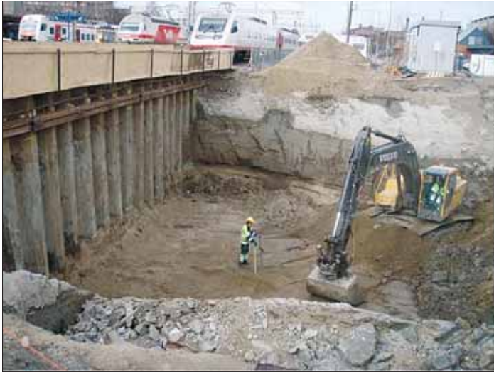
Kaivutyö: Kaivutyöt ovat käynnissä Matkakeskustunnelin itäpäässä.
