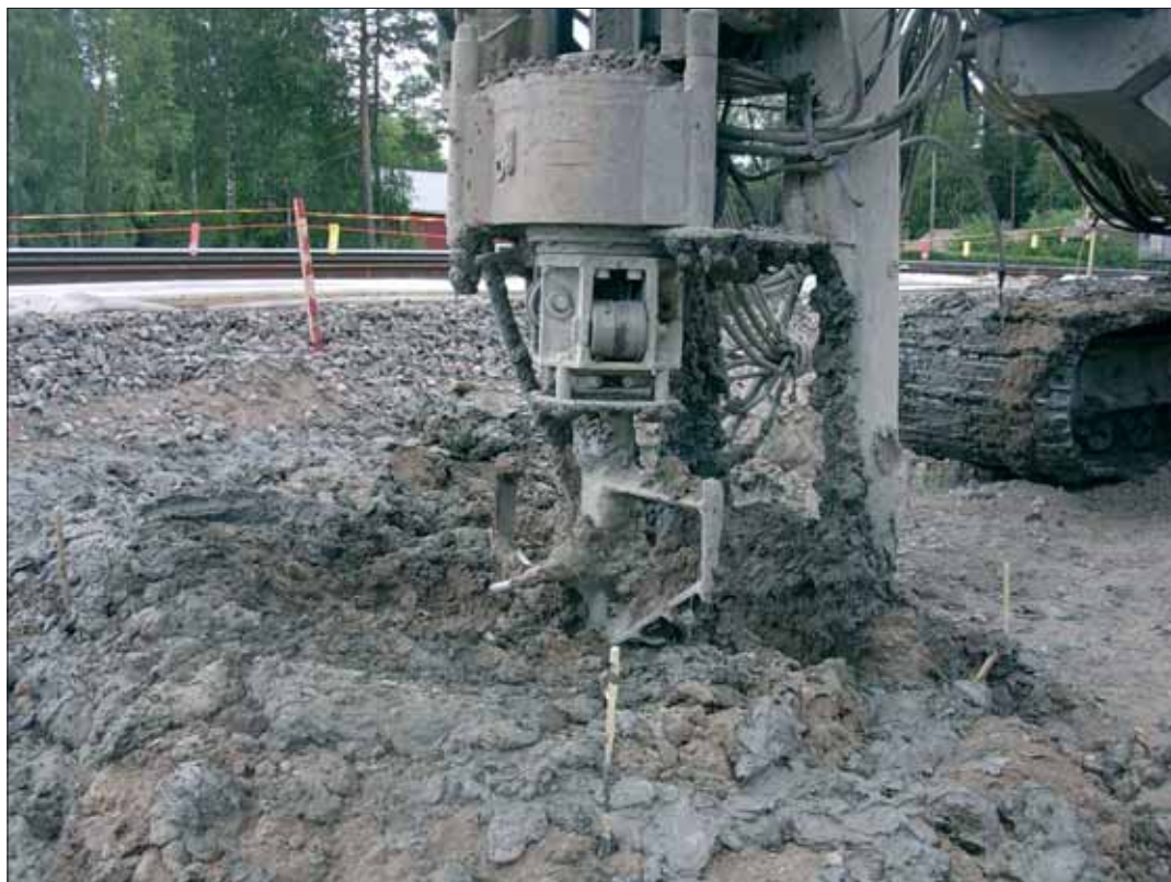
Pilaristabilointia Korialla. Kuva Tuomo Viitala.
