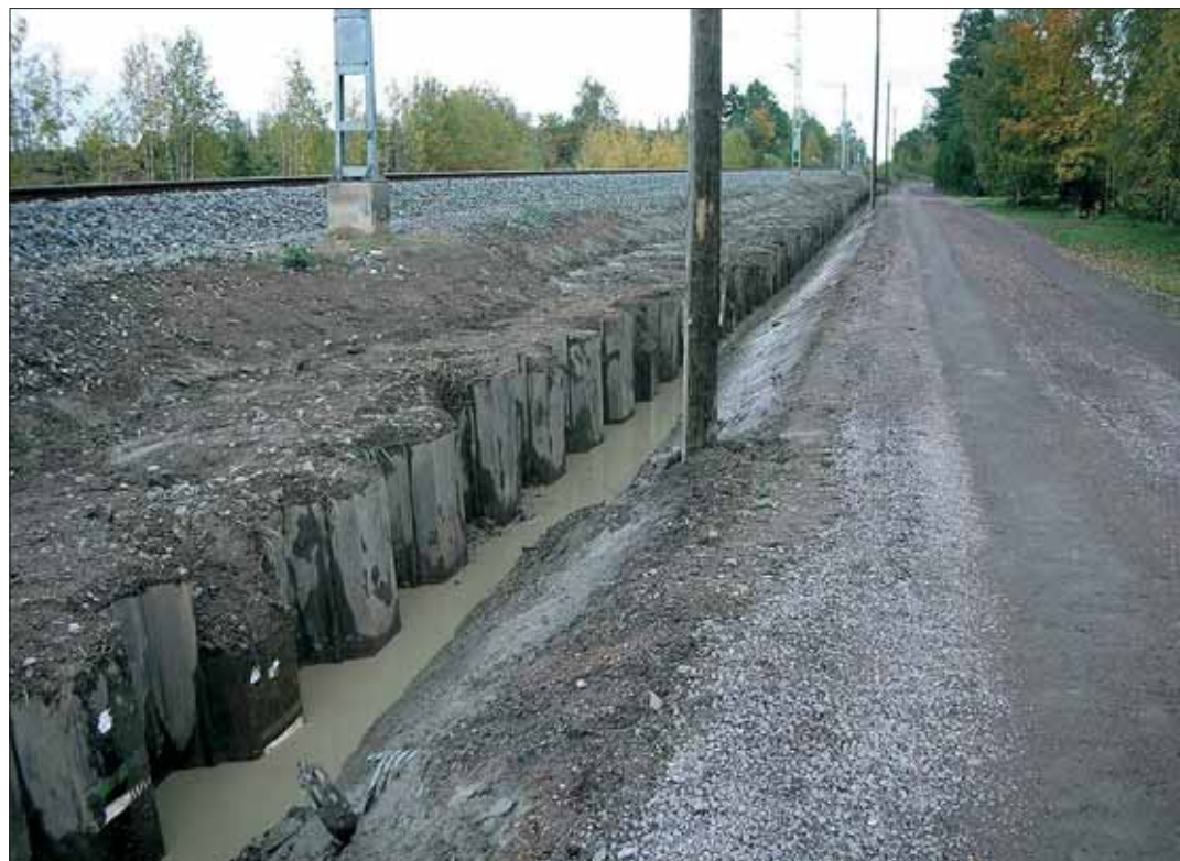
Valmista teräsponttiseinää Mellilässä. Kuva Erkki Poikolainen.
