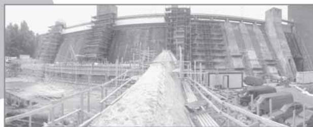
Hirvian vesimatalan betonirakenteen maarakentaminen. Kuva: J. Hyytiäinen
