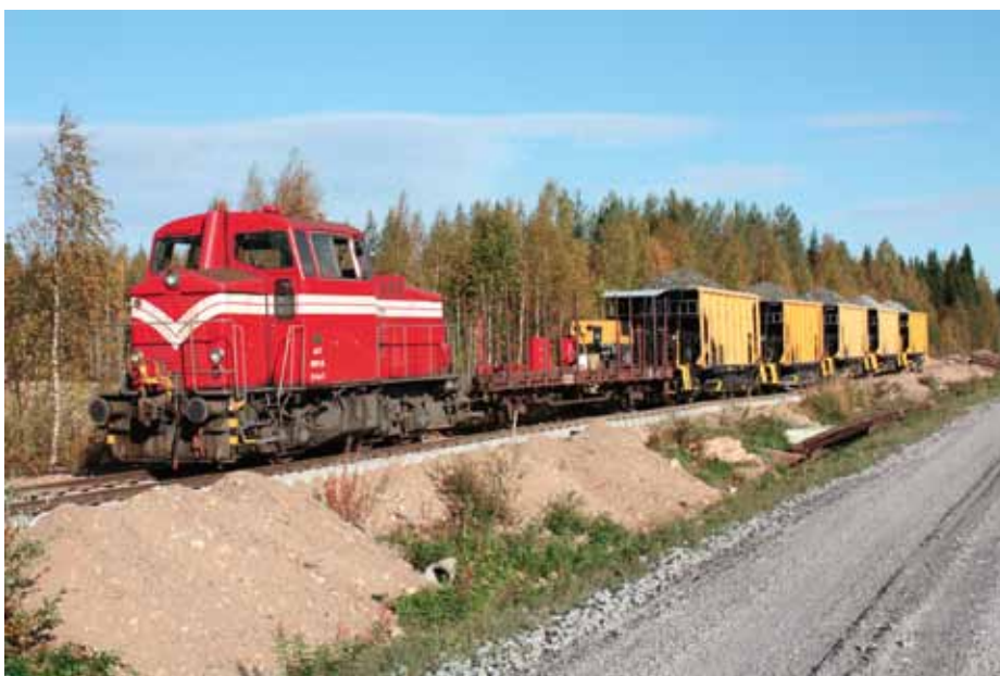
Nurmes-Vuokatti-rataosuuden peruskorjaus käynnissä. Kuva Markku Nummelin.
