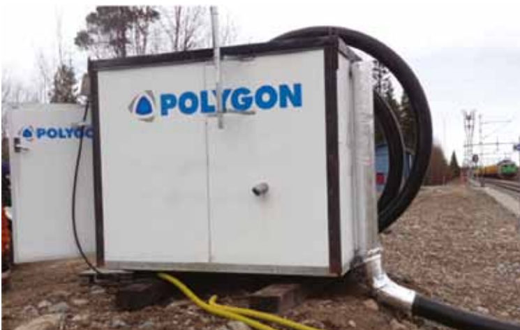
Vasemmalla ilman kuivaus- ja lämmitysjärjestelmän sisältävä kontti testiasennuskohteessa Holmforsissa. Kontin sisältämä ilman kuivain ja lämmityslaitteisto on oikeanpuoleisessa kuvassa.
