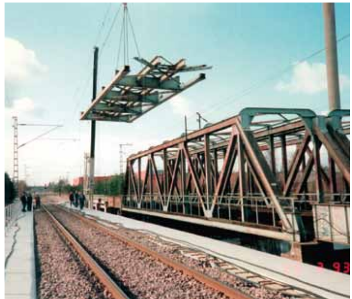
Kuva 2. Vanhojen terässiltojen purkutyöt vuonna 1993. Kuva VR Track arkisto
