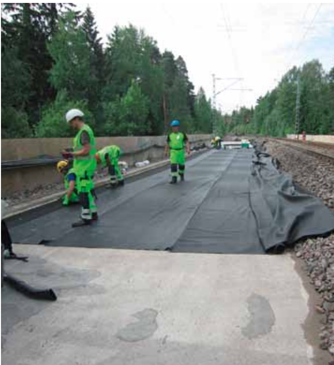
Kuva 1: Sillan vesieristystöitä Martinlaaksossa vuonna 2012. Kuva Jari Nieminen
