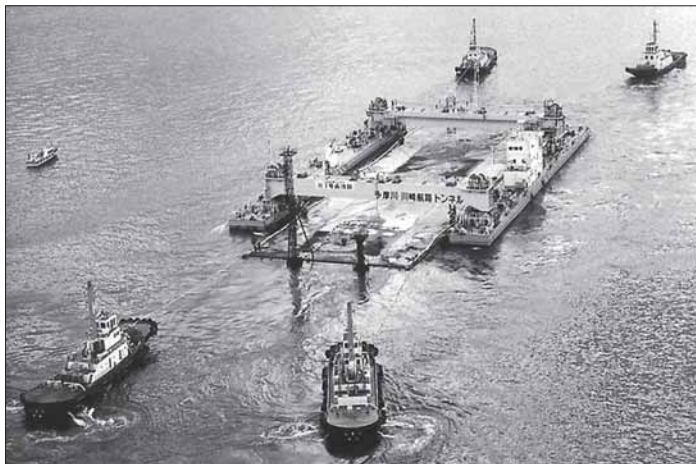
Tunnelielementtien upotus Bosporin salmeen vaatii suurta tarkkuutta.
