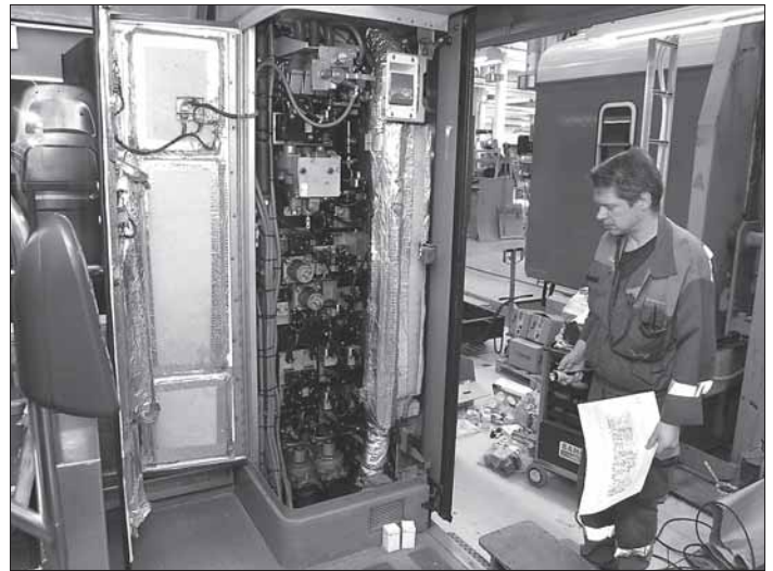
Vaunuasentaja Pekka Mäkinen huoltamassa paineilmaakeskusta.
