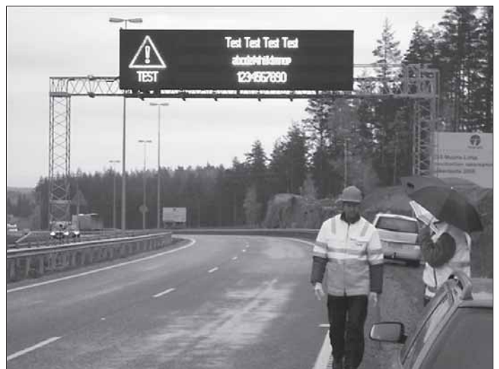
Esimerkiksi ajoradan yläpuoliset muuttuvat opasteet vaativat huolellisuutta työkalujen ja varaosien putoamisen estämiseksi. Etenkin silloin kun työskennellään liikenteelle auki olevan kaistan yläpuolella.
