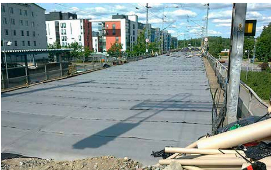
Kuva 4. Suojabetonin yläpinnan epätasaisuus tuli yllätyksenä työmaalla.
