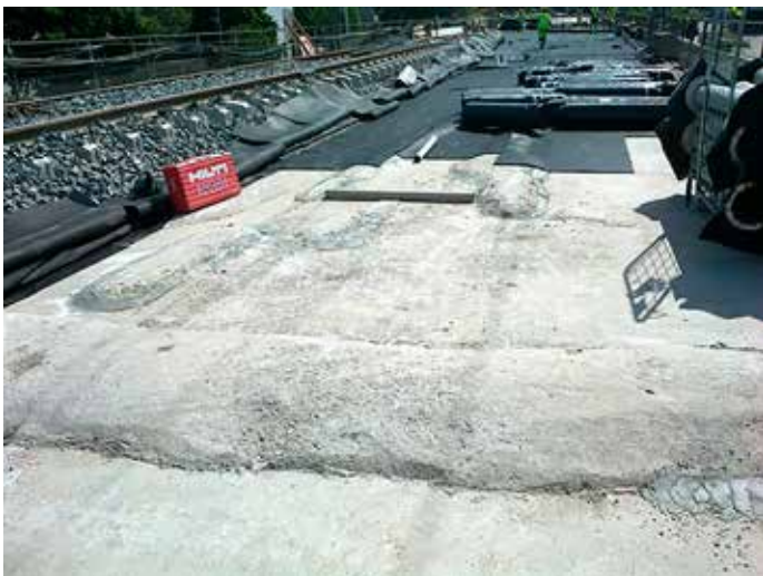
Kuva 4. Suojabetonin yläpinnan epätasaisuus tuli yllätyksenä työmaalla.
