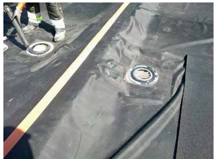
Kuva 6. Syöksytörmien tiivistys.
