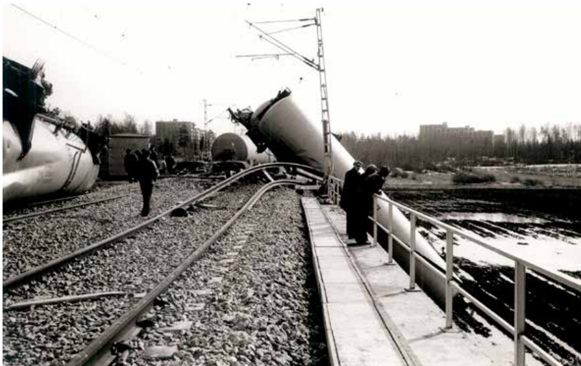
Kuva 2. Sillalta suistunut juna (Kuva, Sweco Finland Oy arkisto).
