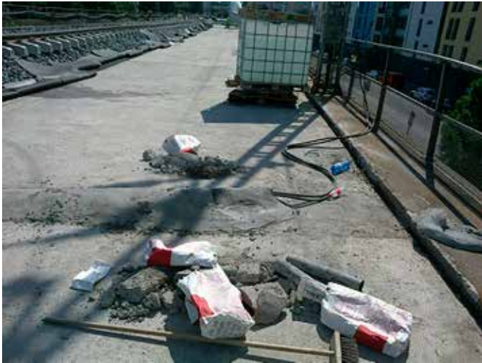
Kuva 3. Vanhassa suojabetonissa olevat ”kakut” ja kaapelit.
