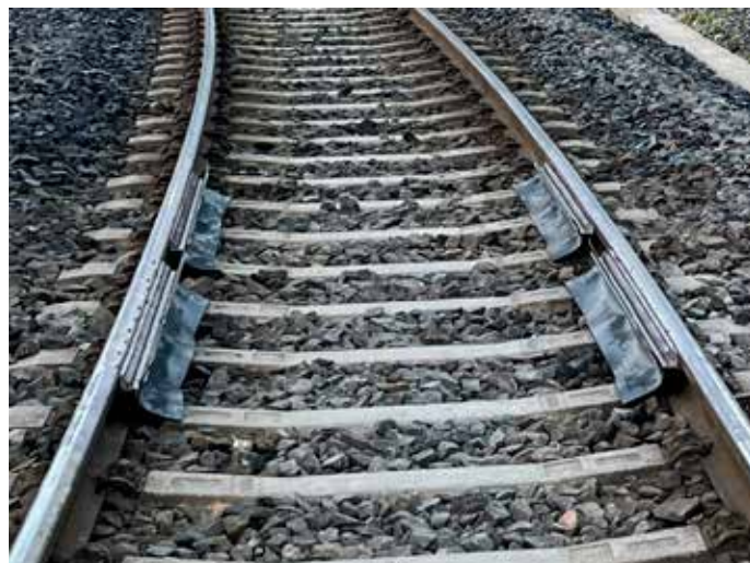
Kuva 3: Kuva annostelukentästä suojineen
