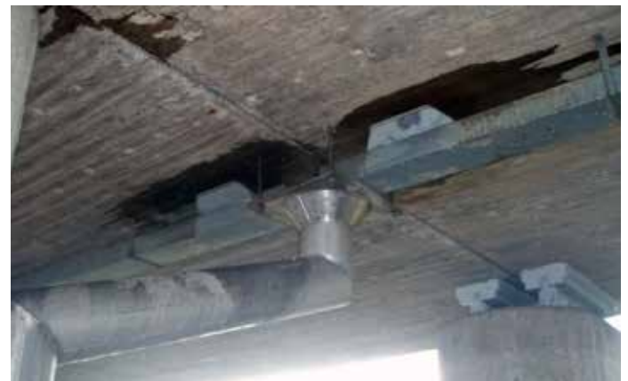
Kuva 5. Sateen jälkeen uuden vesieristyksen alta pääsi vettä vuotamaan pahoin.
