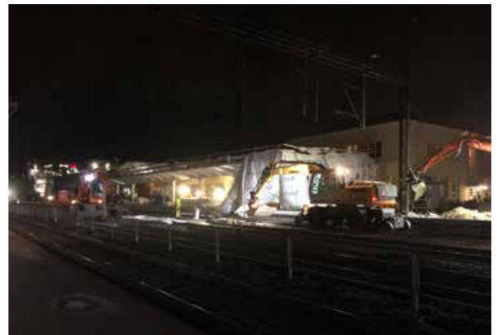
Kuva 1a. Ratatyö Riihimäen asemalla (kuva: T. Sotavalta).
