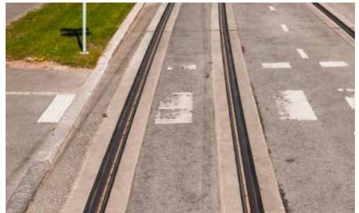
Kuvat 2 ja 3. QTrack-kiintoraiderakenteen asennusta Tampereella ja sekä kuva lopullisesta pinnasta [Kuva Tampereen raitiotieallianssin kuvapankki]
