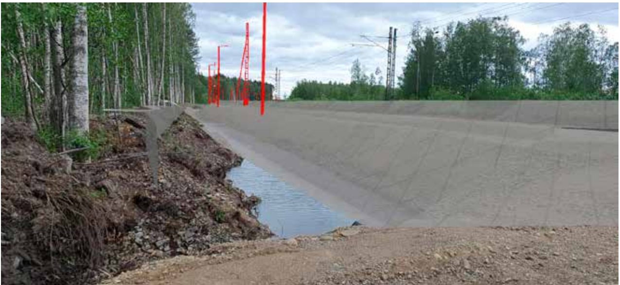
Kuva 5. Väyläviraston aluerajan tarkastelu työmaalla.
