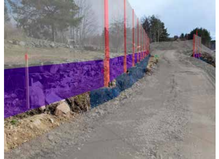
Kuva 4. Uuden meluseinän ja huoltotien linjauksen tarkastelu toukokuussa 2022.
