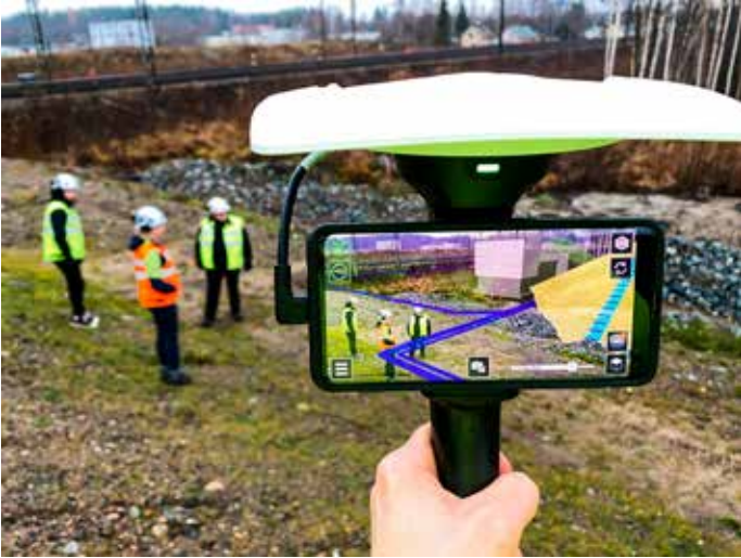
Kuva 2a. SiteVision -laitteen käyttöä Joensuun ratapihahankkeella (Kuva Jetro Matilainen).
