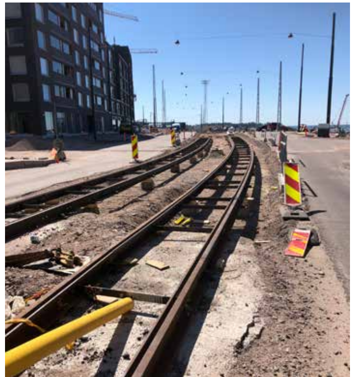
Kuva 3. Ratikka kiskojen rakentamista Kalasatamassa (kuva: T. Sotavalta).
