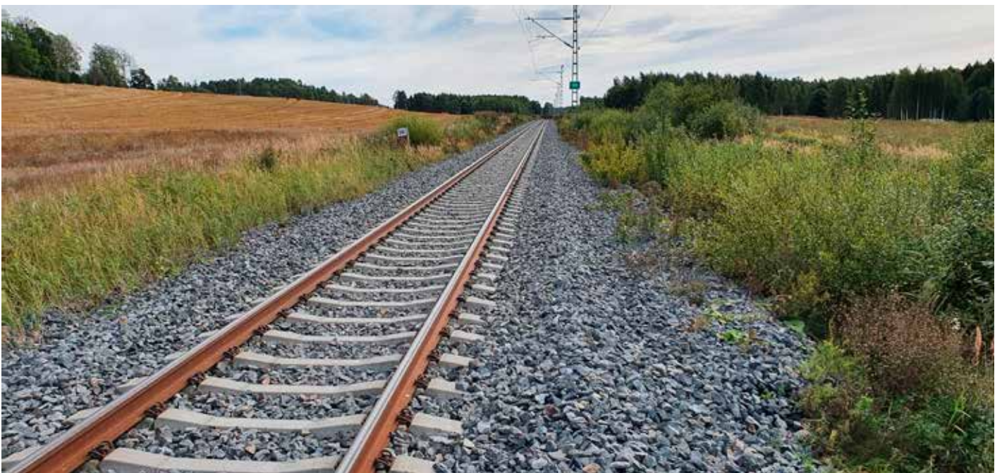
Kuva 1. Rantaradalla sijaitseva kohde, jonka kuivatus voisi toimia paremminkin. Ongelmia on jo perustason kuivatuksessa, ojat ovat vesakoituneet umpeen ja niiden syvyys on liian pieni.
