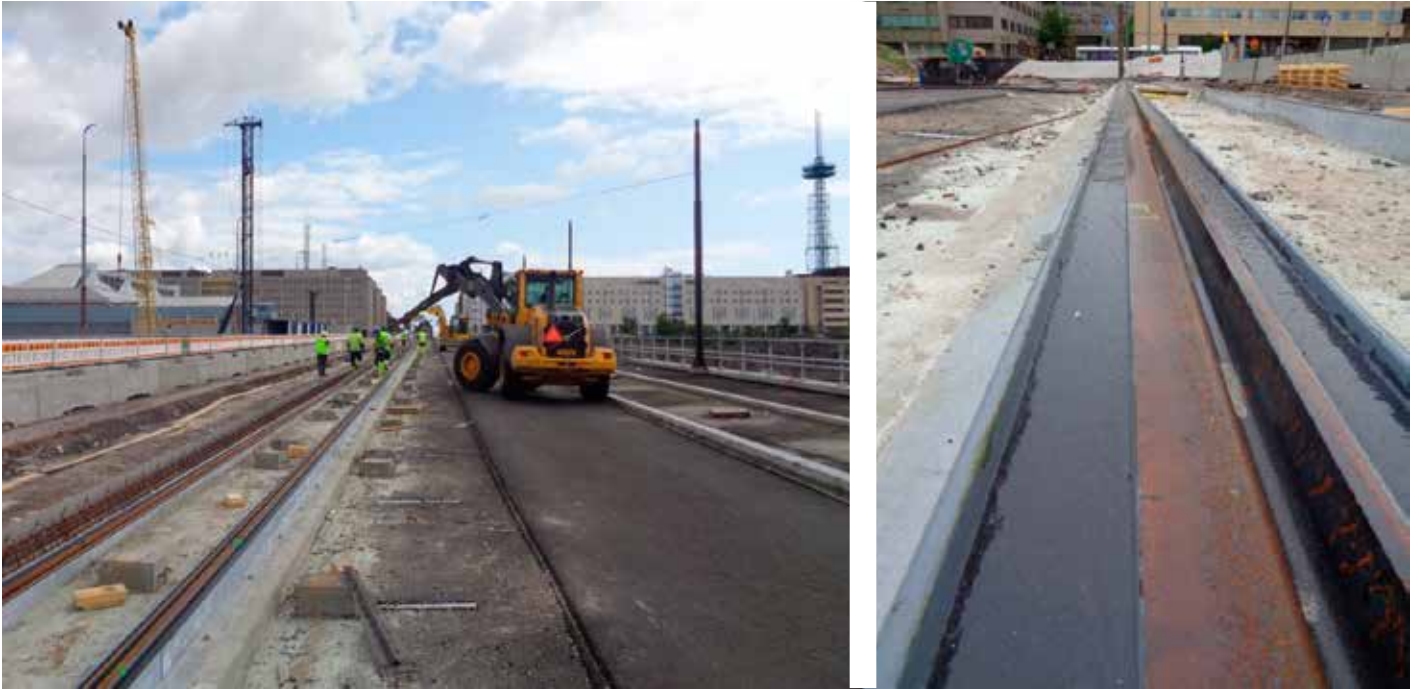
Kuva 4 ja 5. Pasilan sillalle toteutettu raitiotieraide ERS-menetelmällä [Kuva edillon)( sedra]
