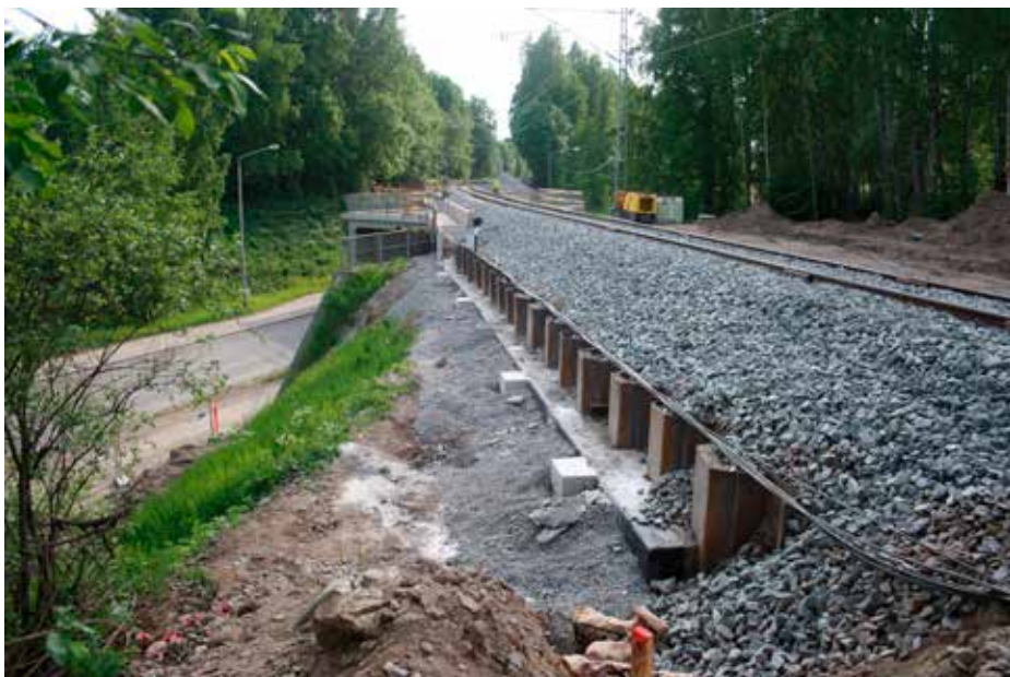
Kuva 3. Ponttiseinä asennettuna sillan päähän. (Kuva, Sweco Finland Oy arkisto)
