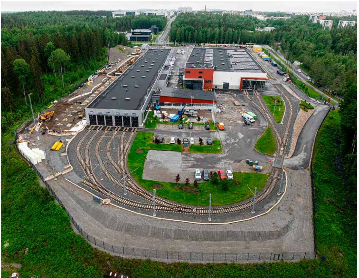
Kuva 5: Hervannassa Tampereen Ratikan kotipesässä rakentamistöiden aikana varmistetaan varikon häiriötön toiminta / Kuva: Pasi Oolas
