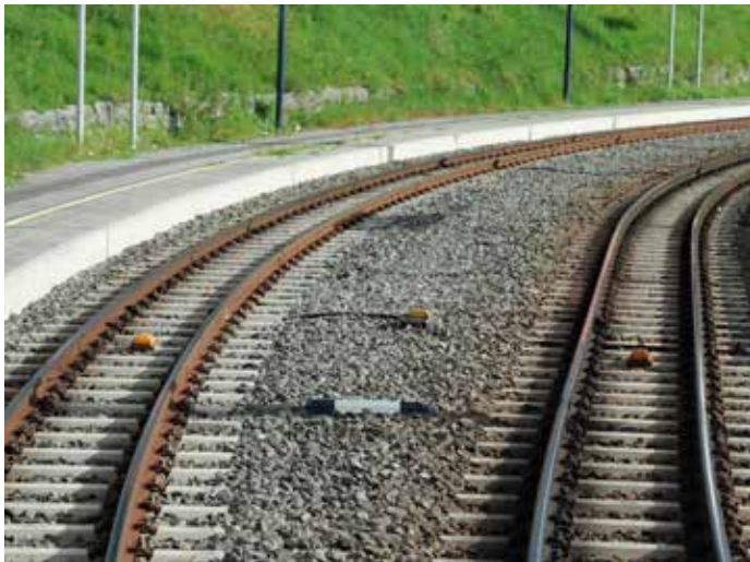
Baliiseja radassa. Paikannus tapahtuu niiden, DGPS:n ja matkamittauksen avulla.
