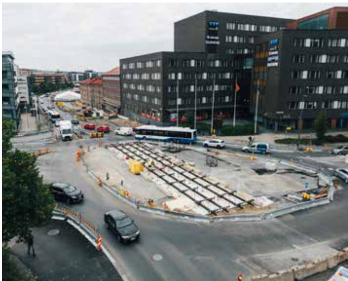
Kuva 2: Liikenteellisesti hankkeen haastavin paikka on Tampereen ja Hatanpään valtateiden risteysalue, johon on jo kiintoraiteet valettu / Kuva: Wille Nyssönen
