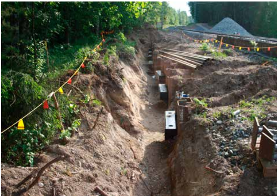
Kuva 4. Vastapontit asennettuna. (Kuva Sweco Finland Oy arkisto)
