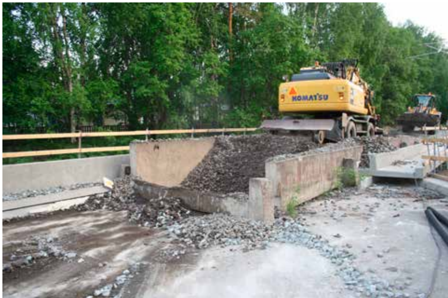
Kuva 2. Aiemmin raide oli kapean tukimuurirakennelman päällä. (Kuva Sweco Finland Oy arkistot)
