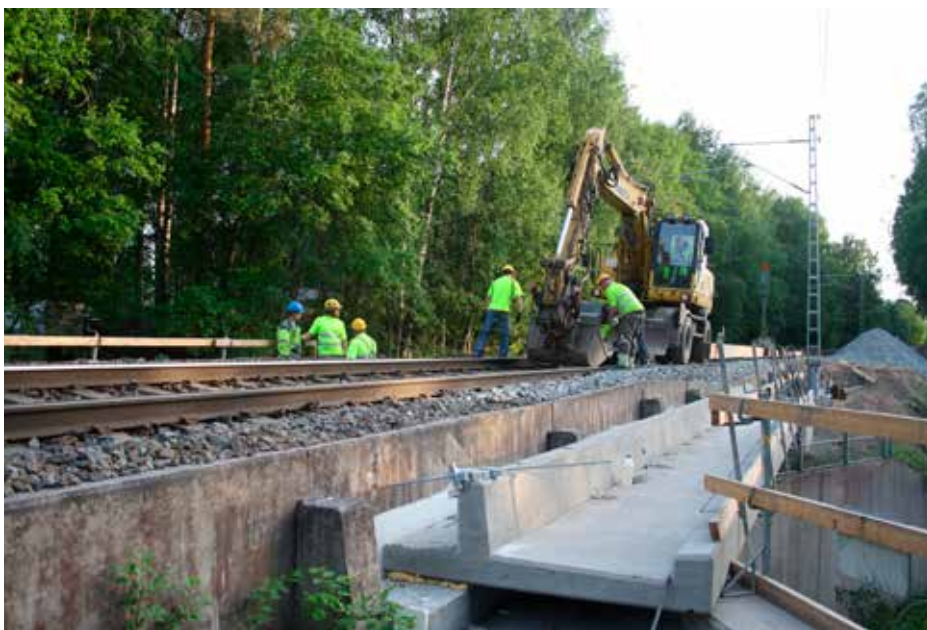
Kuva 5. Vanha tukimuri ja uusi reunaelementti paikoillaan. (Kuva Sweco Finland Oy arkisto)
