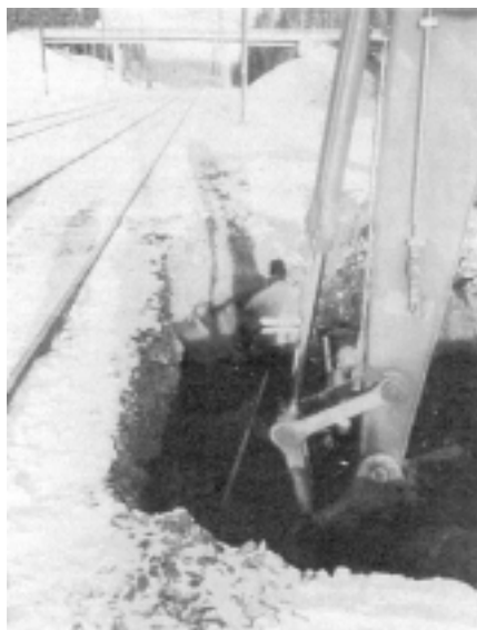
Kuva 4.1 Anturallisen perustuksen vaatima kaivanto.
