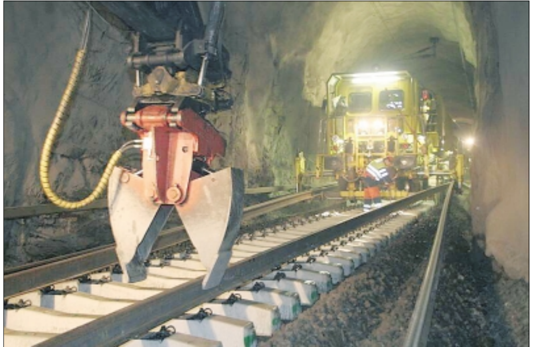
Raiteenvaihtotyö etenee Matomäen tunnelissa.
