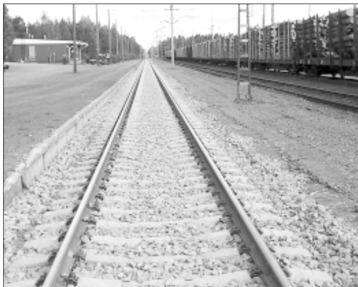
Kuva 2. Kiteen ratapihan pääraide perusparannuksen jälkeen.
