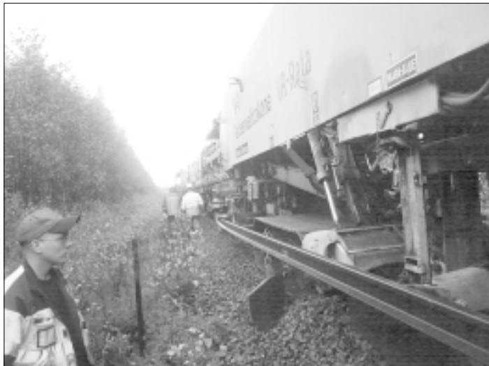
Kuva 3. Raiteenvaihto käynnissä Veeralla.
