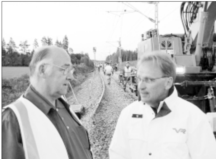
VR-Radan Länsi-Suomen aluepäällikkö Jorma Anttila (vas) keskustelelee työmaapäällikkö Matti Marolan kanssa työn edistymisestä.
