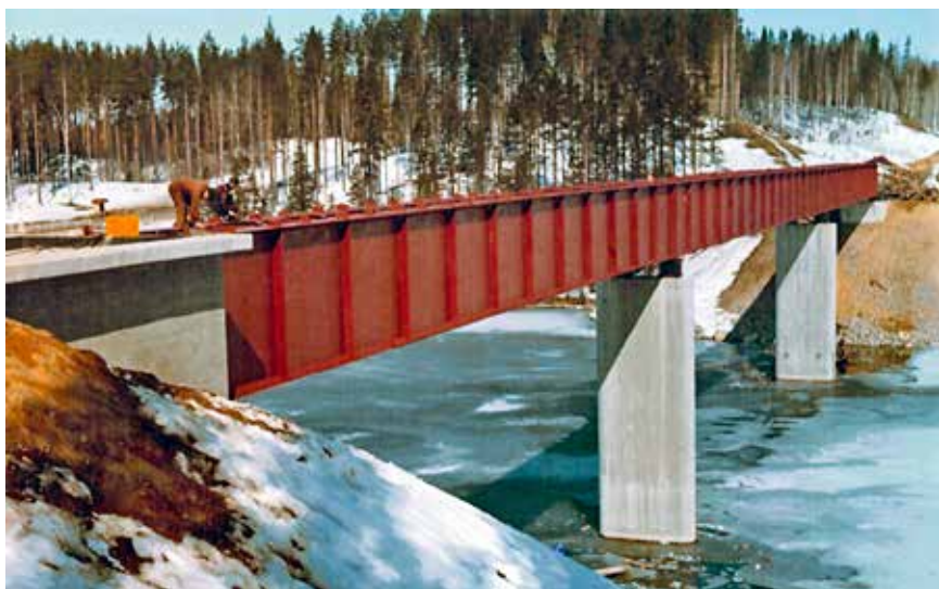
Syrjäsalmen silta vuonna 1967. Kuva Väyläviraston ratapiirustusarkisto
