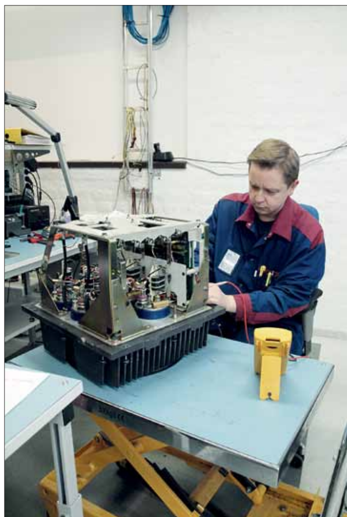
Sr2 apukäyttölaitteiston vaihtosuuntaajan korjauksia on tehty elektroniikkaosaston omana työnä jo vuodesta 2007.
