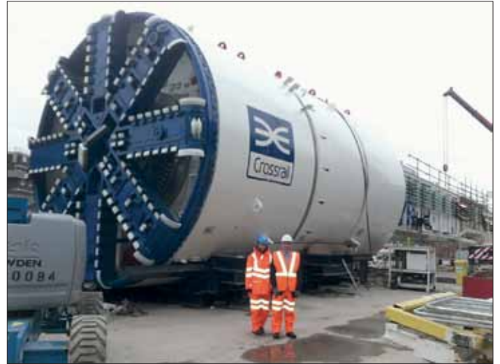
Lontoo alitetaan näillä 150 metriä pitkillä tunneliporakoneilla (kuva: Crossrail).
