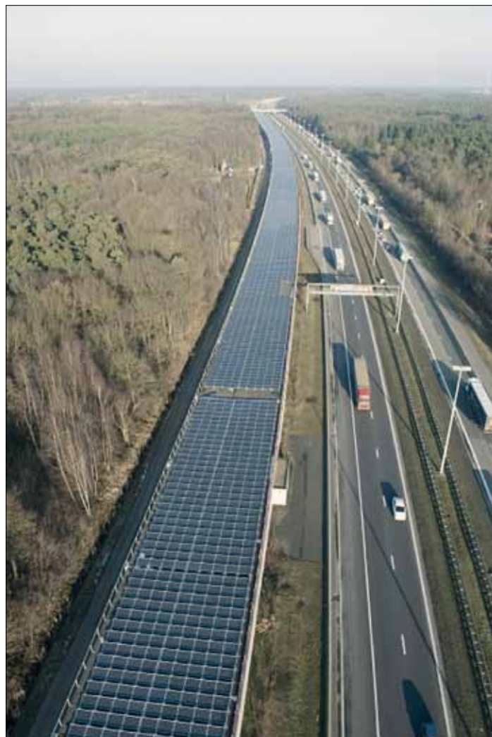
Belgialaisen suurnopeusradan aurinkopaneelikatoksella on pituutta 3,4 kilometriä.
