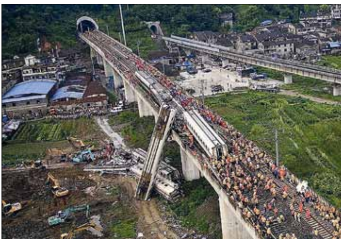
Suurnopeusradan raivaustyöt käynnissä onnettomuusalueen viaduktisillalla Wenzhoussa.
